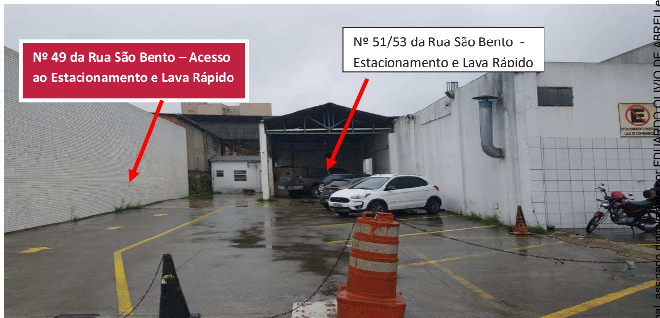
(Vista Frontal dos Imóveis, identificando as Funções dos mesmos juntos ao Auto Posto Valongo)
