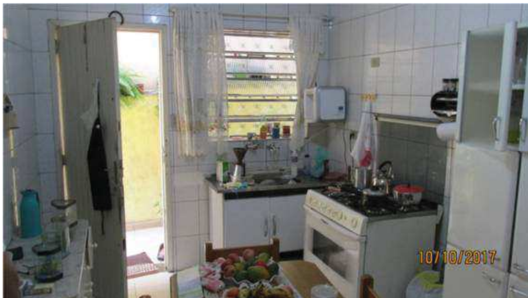
Foto 08) Vista da cozinha. Observar acabamento de piso e paredes, caixilho basculante metálico, pia em aço inoxidável com cuba e tampo em material sintético, sobre gabinete em MDF.
