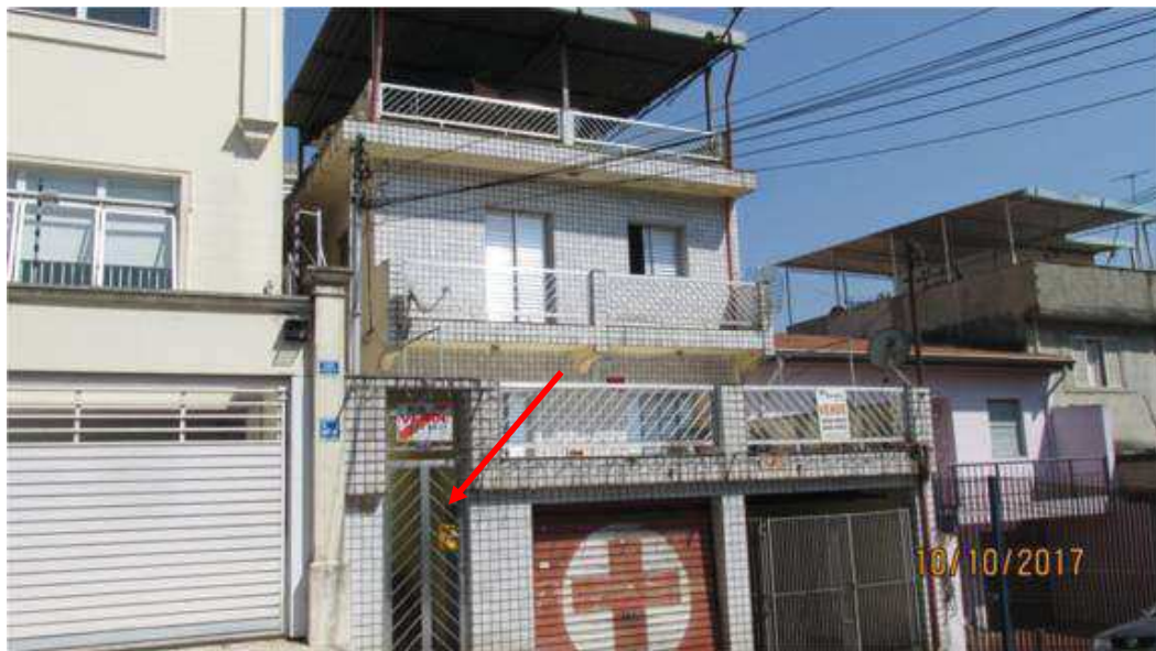
Foto 04) Vista da fachada do imóvel pela Rua Sa-guairú onde, pelo corredor na porção esquerda, é possível acessar três, das seis moradias existentes.
