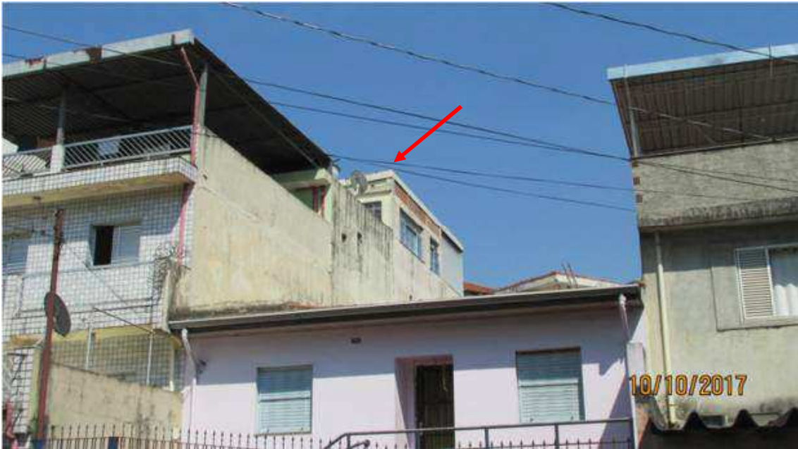
Foto 03) Vista lateral da elevação da construção, que ocorre em 03 (três) níveis na porção frontal, contando ainda com piso adicional na porção de fundos.
