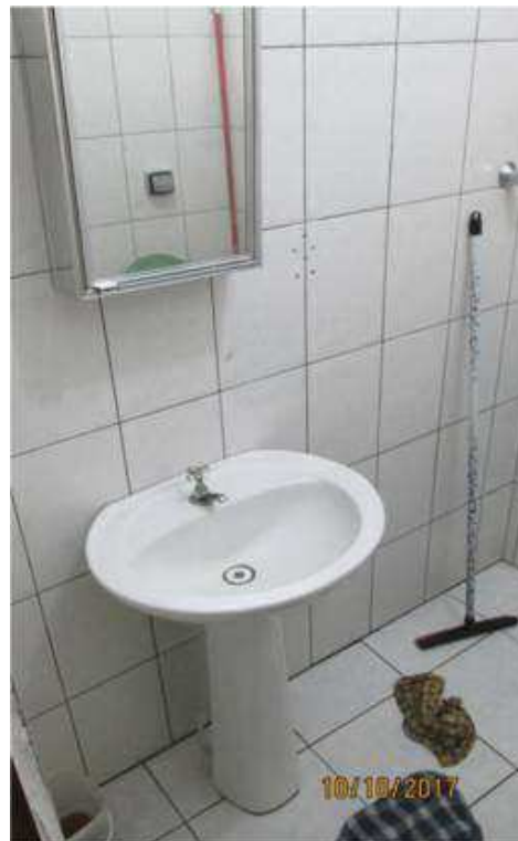
Foto 10) Vista do banheiro. Observar acabamento de piso e paredes, pia com coluna em louça na cor branca e área de banho sem fechamento.
