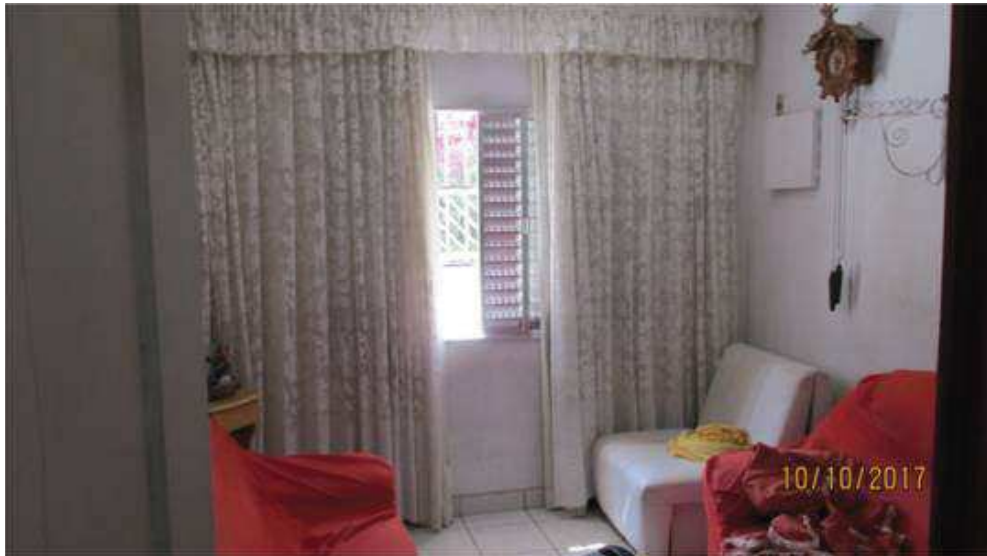
Foto 09) Vista da sala. Observar acabamento de piso e paredes e caixilho em alumínio em alumínio anodizado natural.
