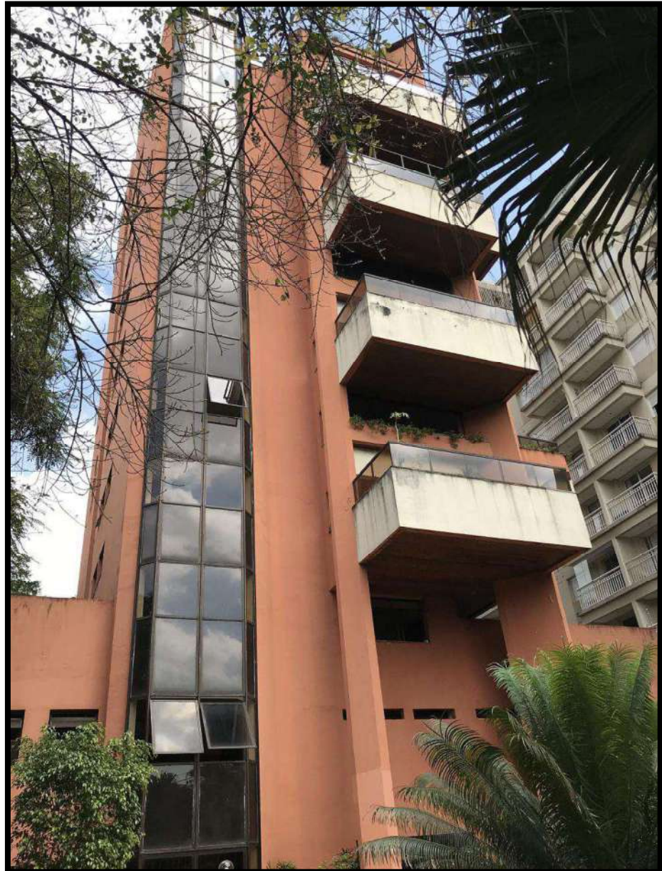
VISTA DA FACHADA DO CONDOMÍNIO EDIFÍCIO PHOENIX.
