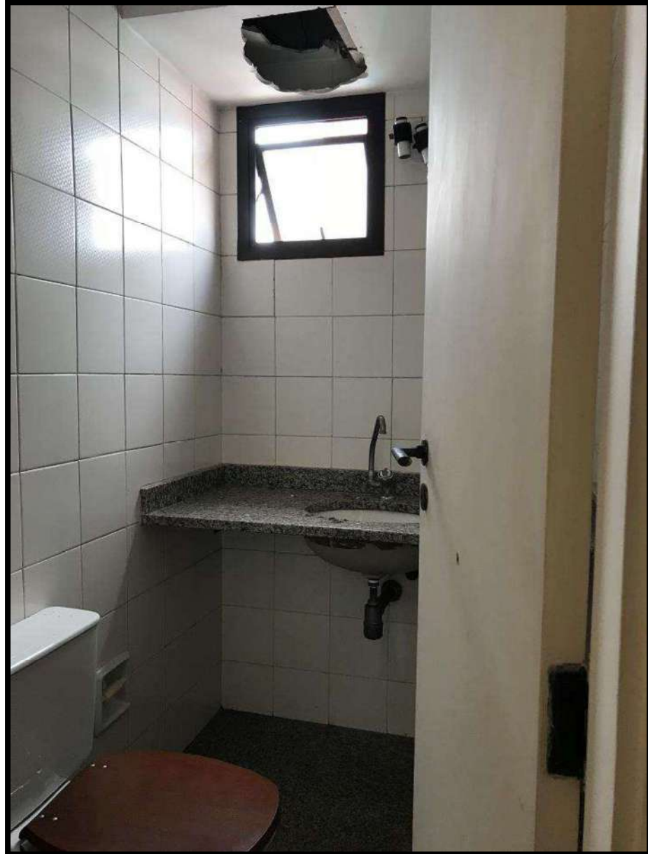
VISTA DO BANHEIRO II, LOCALIZADO NA COBERTURA.
