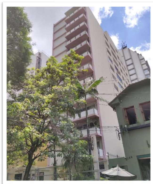
FOTO 01 – Fachada do edifício
