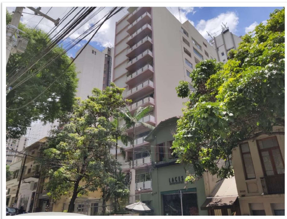
FACHADA DO PRÉDIO DO IMÓVEL AVALIANDO
