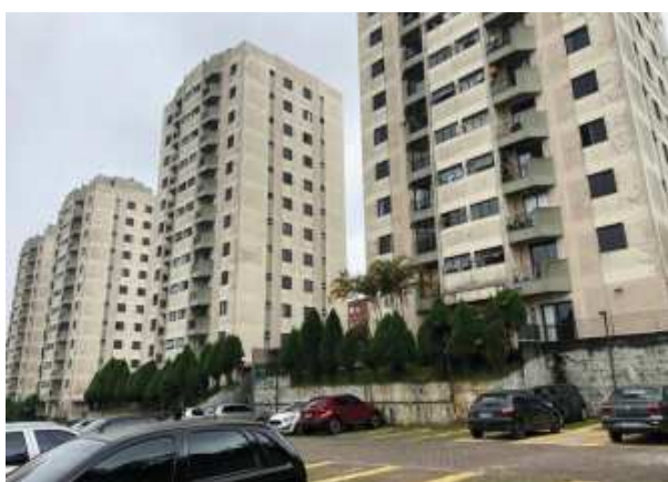
VISTA DO ESTACIONAMENTO DO CONDOMÍNIO
