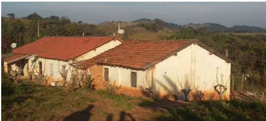
Casa dos trabalhadores
