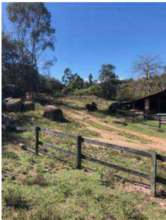
Foto 42 – Cercas de madeira ao longo de toda a sede (muitas danificadas, conforme a foto)
