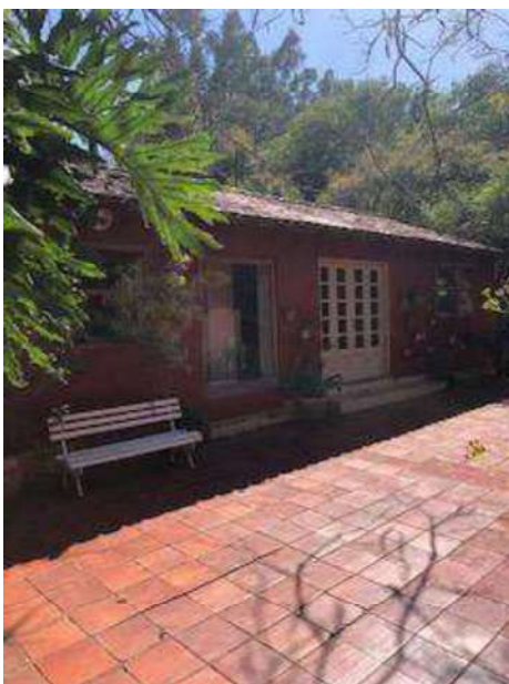
Foto 6 – interface entre a cozinha e a casa principal (vista para sala)
