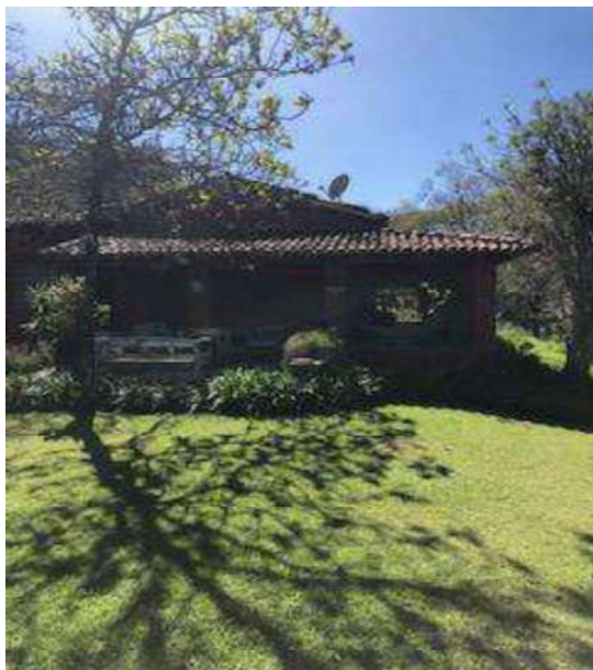
Foto 5 – frente lateral casa sede
