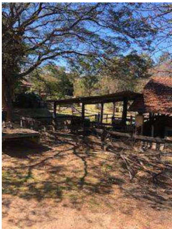
Foto 37 – antiga benfeitoria produtiva e a falta de manutenção
