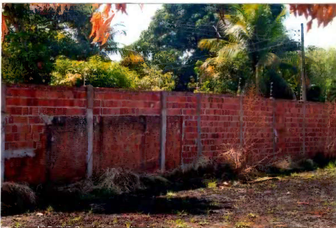
Vista parcial do tipo de muro que cerca a área do terreno, sendo a parte da frente sem muro.
