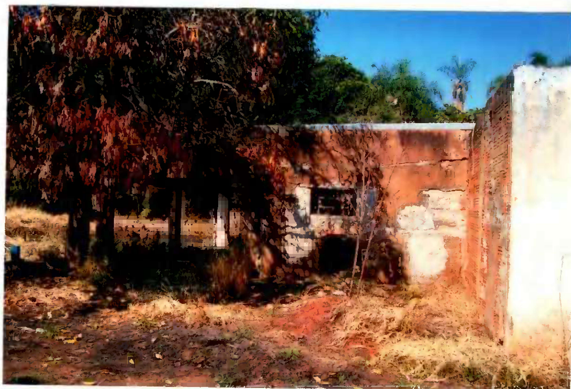
Vista parcial do condições do prédio destinado a administração e loja de conveniência do posto.
