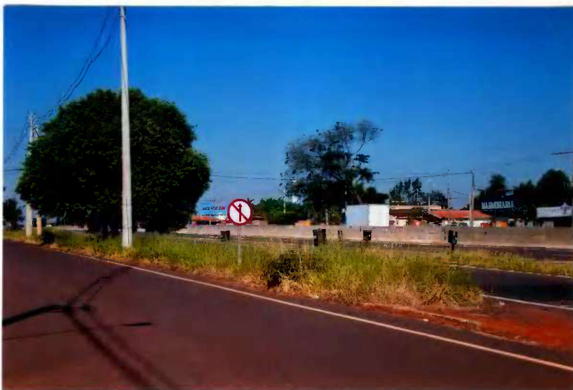
Vista do posto de abastecimento de combustível e as pistas de rolamento da Rodovia Eliezer Montenegro Magalhães - SP. 463.
