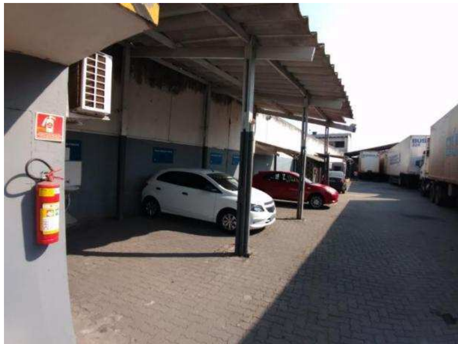
VISTA DO ESTACIONAMENTO DE FUNCIONÁRIOS.
