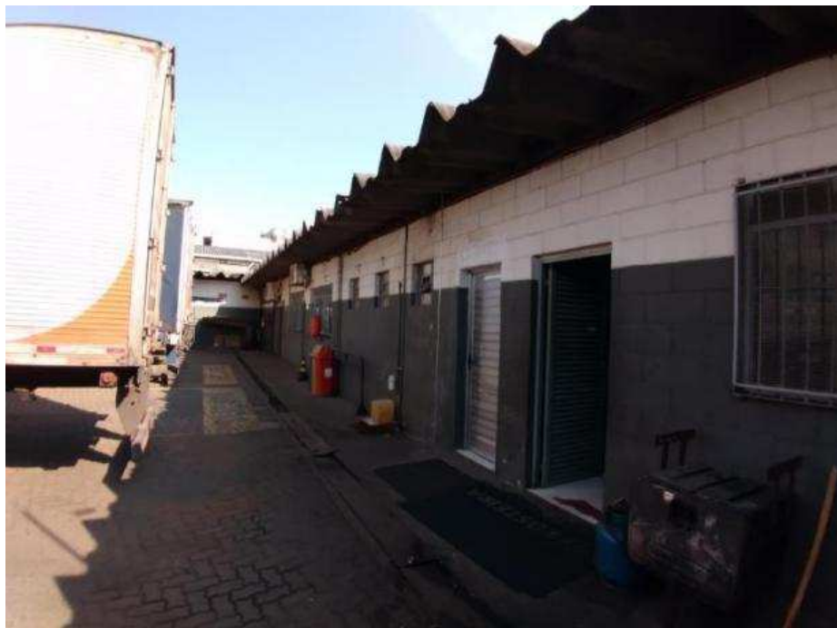
VISTA DA ÁREA DE SERVIÇO.
