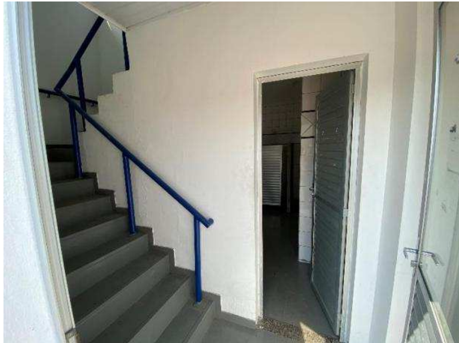
VISTA DO HALL.
