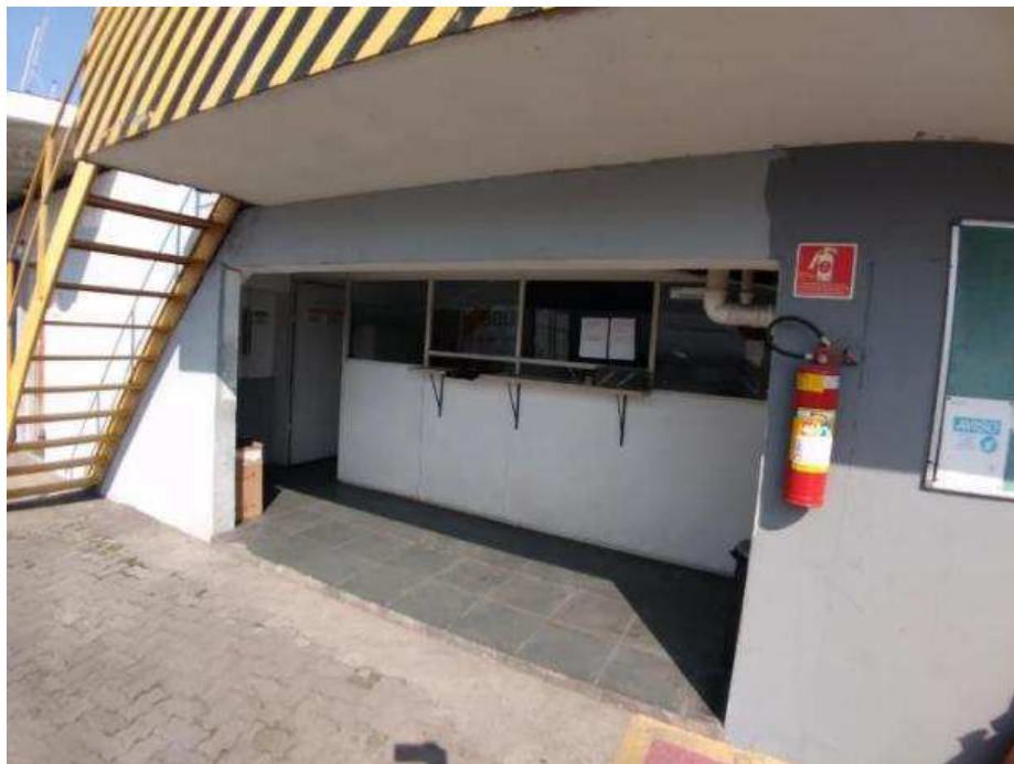
VISTA DA ÁREA OPERACIONAL.
