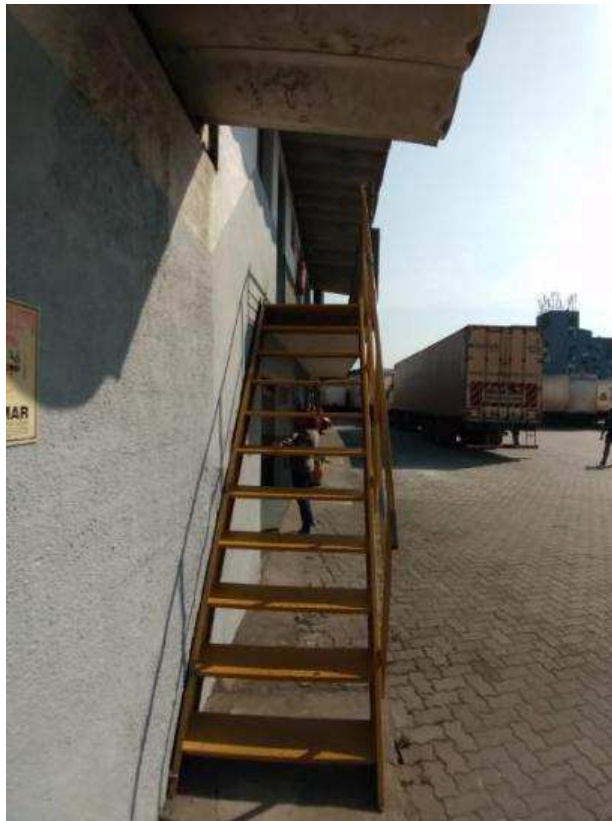
VISTA DA ESCADA DE ACESSO AO PISO SUPERIOR.
