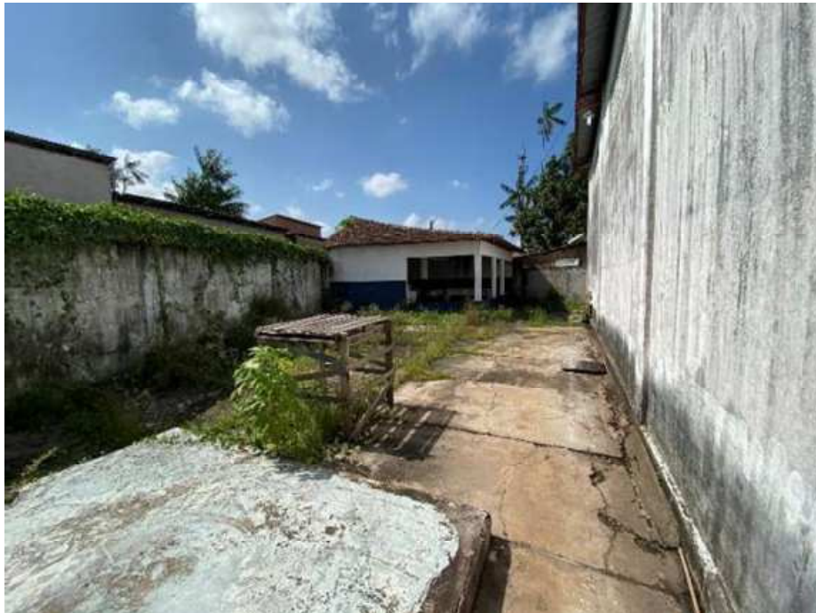
VISTA DOS FUNDOS DO GALPÃO.
