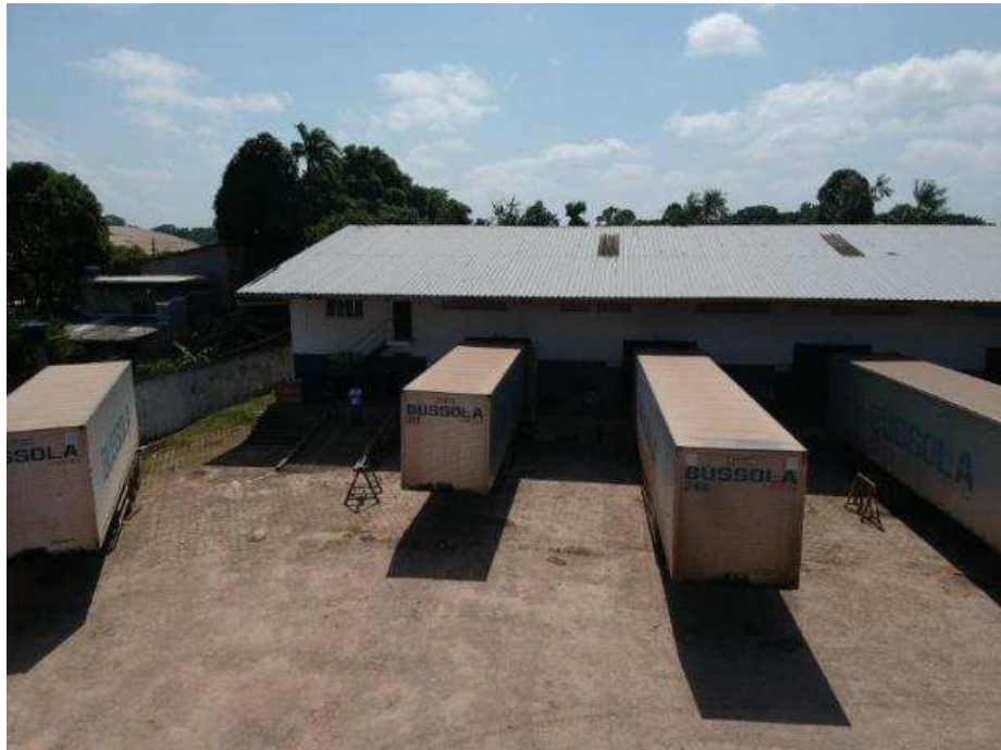
VISTA DA COBERTURA EXTERNA.
