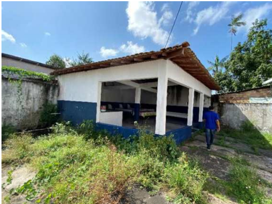
VISTA FDA ÁREA COBERTA.
