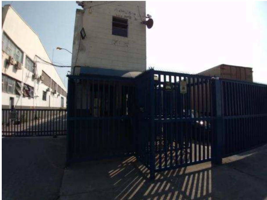
VISTA DA ENTRADA DE PEDESTRES.
