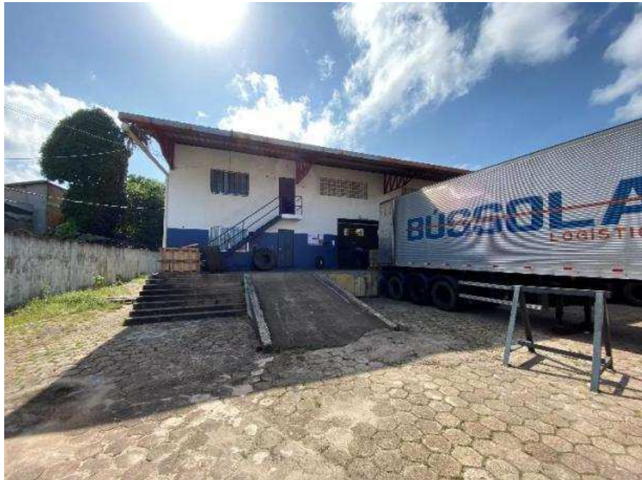
VISTA DO ACESSO A ÁREA ADMINISTRATIVA.
