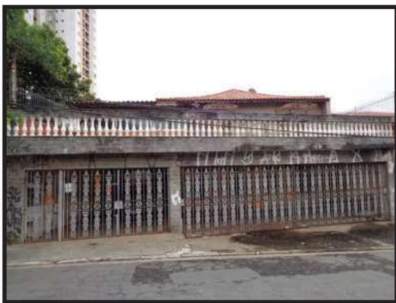
Foto 02: Fachada do imóvel
