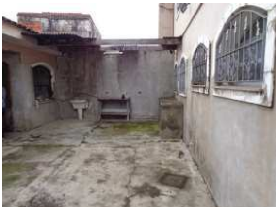
Vista parcial da área de serviço
