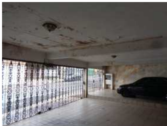
Vista parcial da garagem
