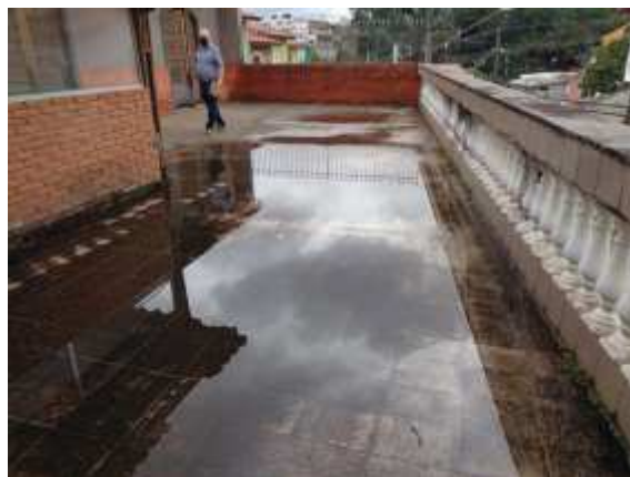
Vista parcial do terraço
