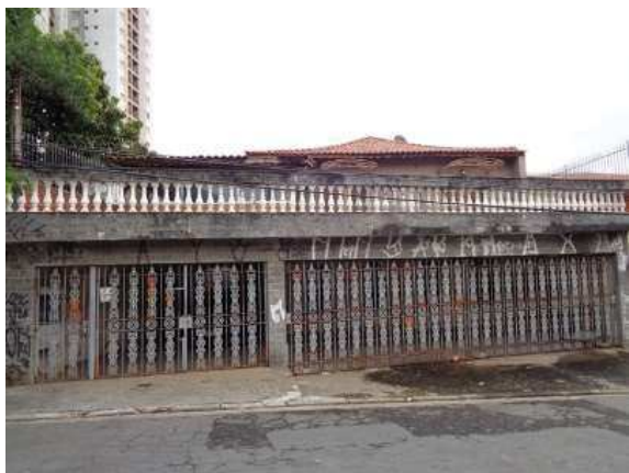
Vista parcial da fachada frontal
