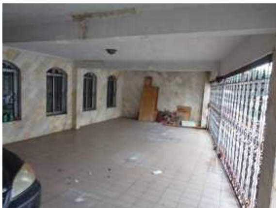
Vista parcial da garagem
