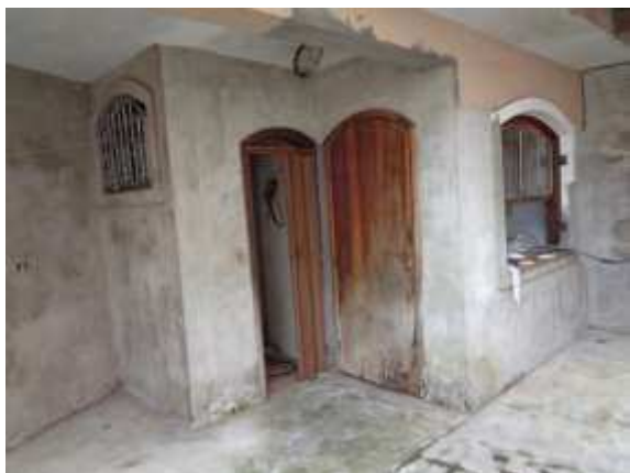
Vista parcial da edícula
