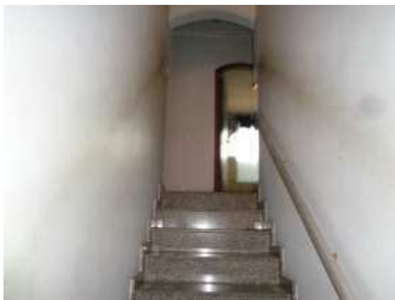
Vista parcial da escada
