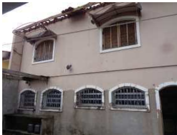
Vista parcial da fachada posterior
