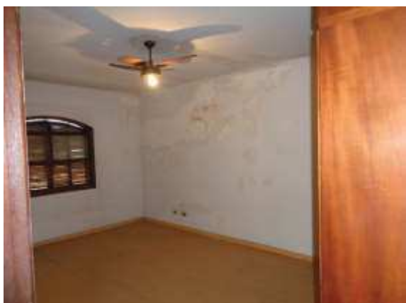
Vista parcial do dormitório 2
