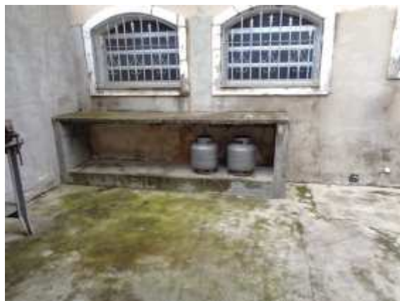
Vista parcial do abrigo de gás
