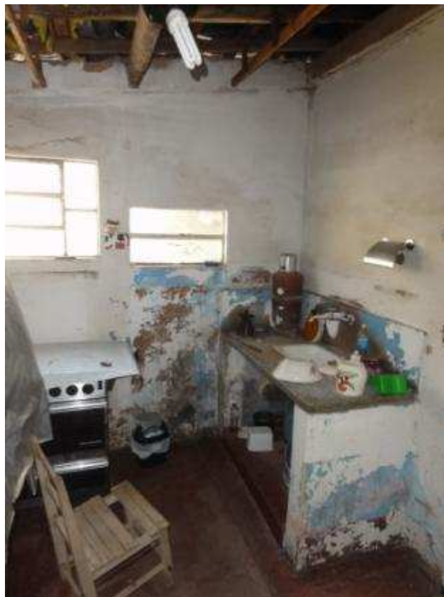
VISTA DA COZINHA.
