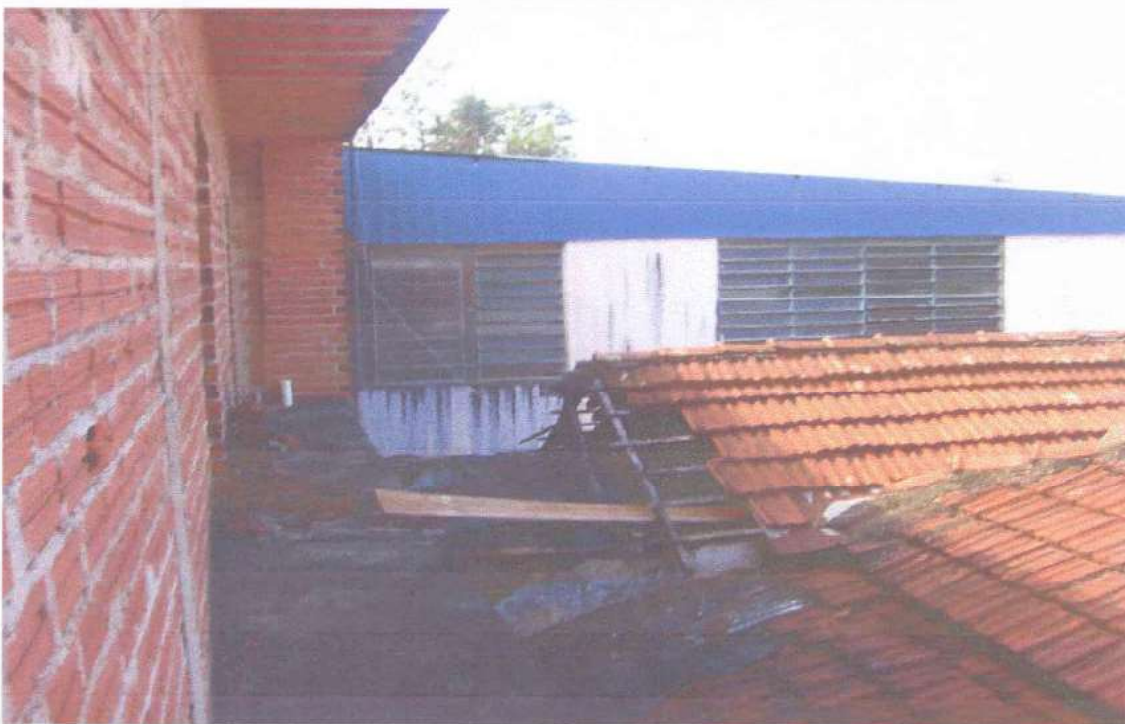
FOTO 10 - Vista onde vemos a sacada da obra dos fundos e o telhado dos cômodos frontais do Imóvel A, e também o Imóvel B ao fundo .
