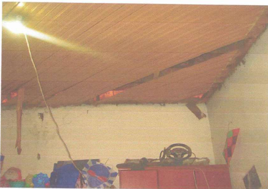
FOTO 11 - Vista do forro de madeira dos cômodos de frente do Imóvel A.
