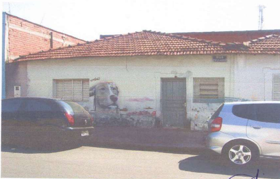
FOTO 02 - Vista do mesmo Imóvel onde vemos o estado de conservação.
