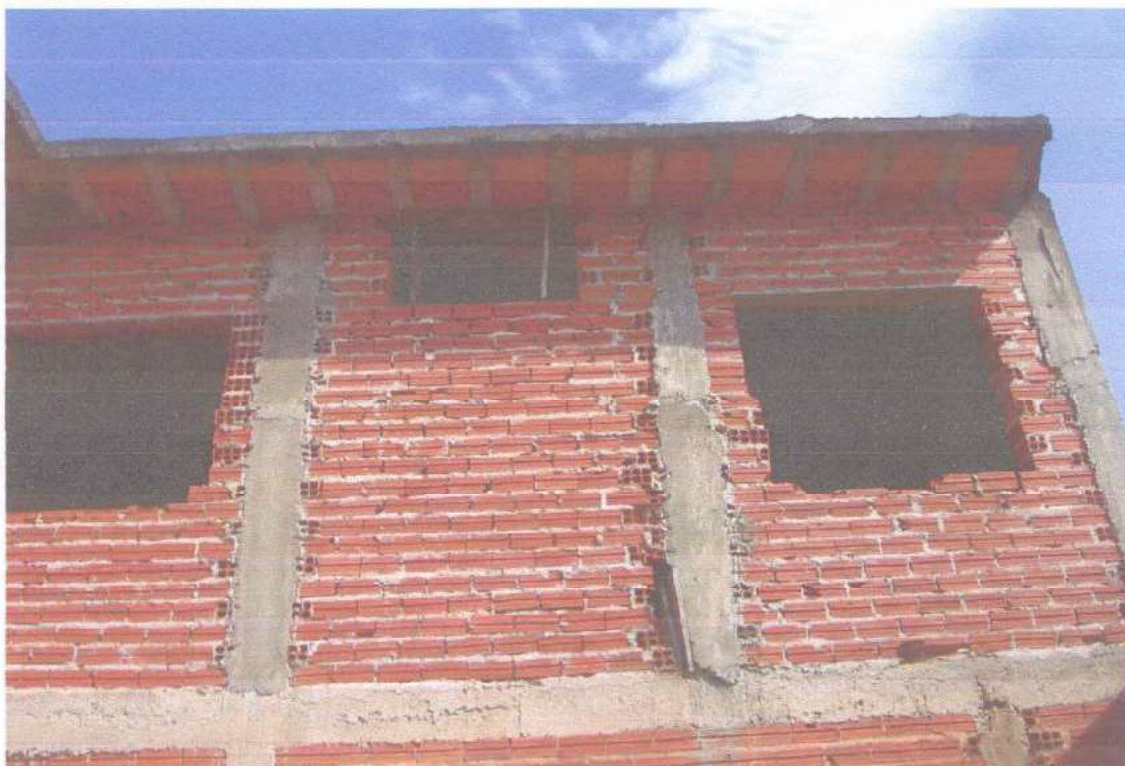
FOTO 06 - Outra Vista da parte superior da obra, sem acabamento e sem telhado.
