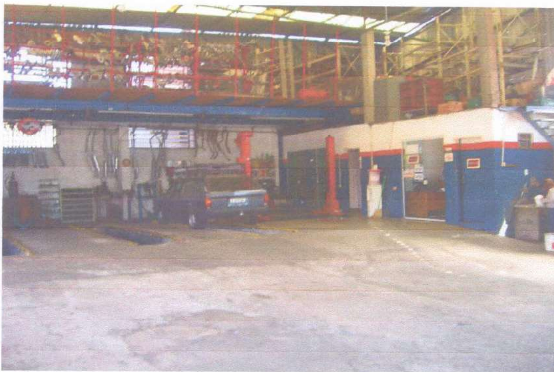
FOTO 17 - Vista do Imóvel com piso em concreto desempenado.
