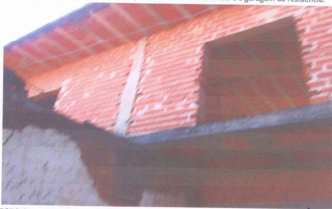
FOTO 04 - Vista da fachada da construção na parte dos fundos (Sobrado) onde vemos sua sacada.
