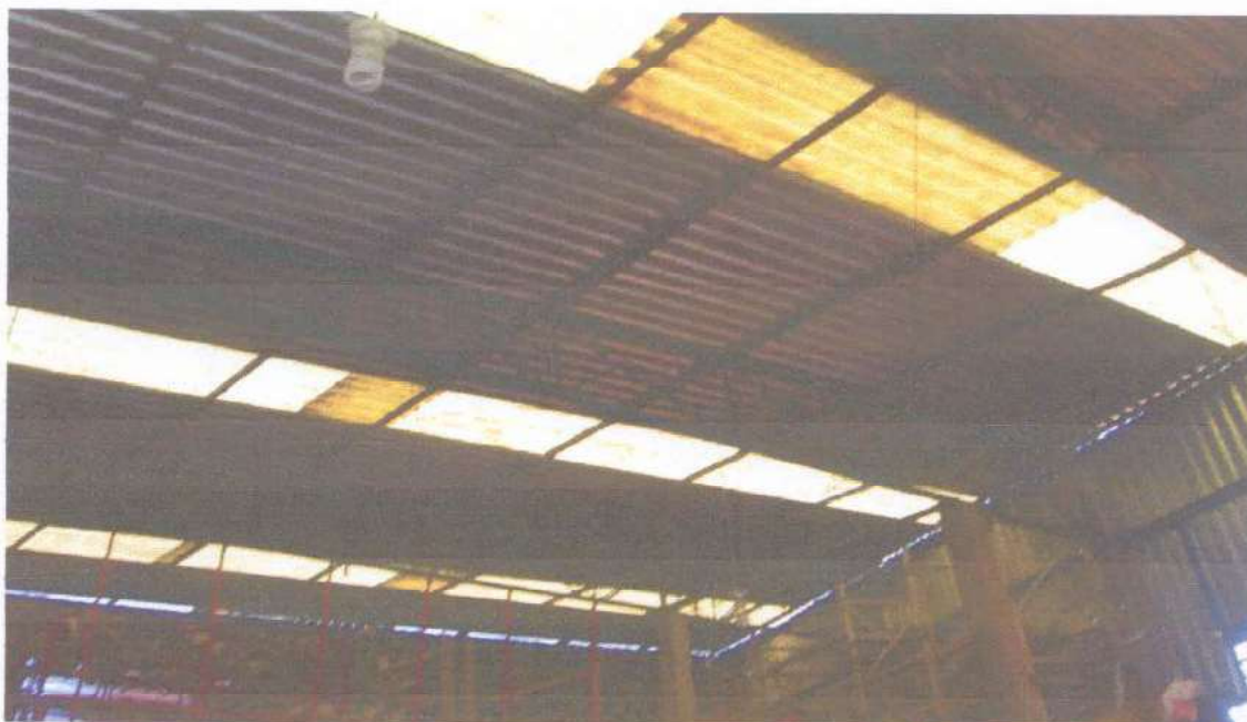
FOTO 16 - Vista da cobertura do barracão feita com estrutura metálica e telhas galvanizadas.
