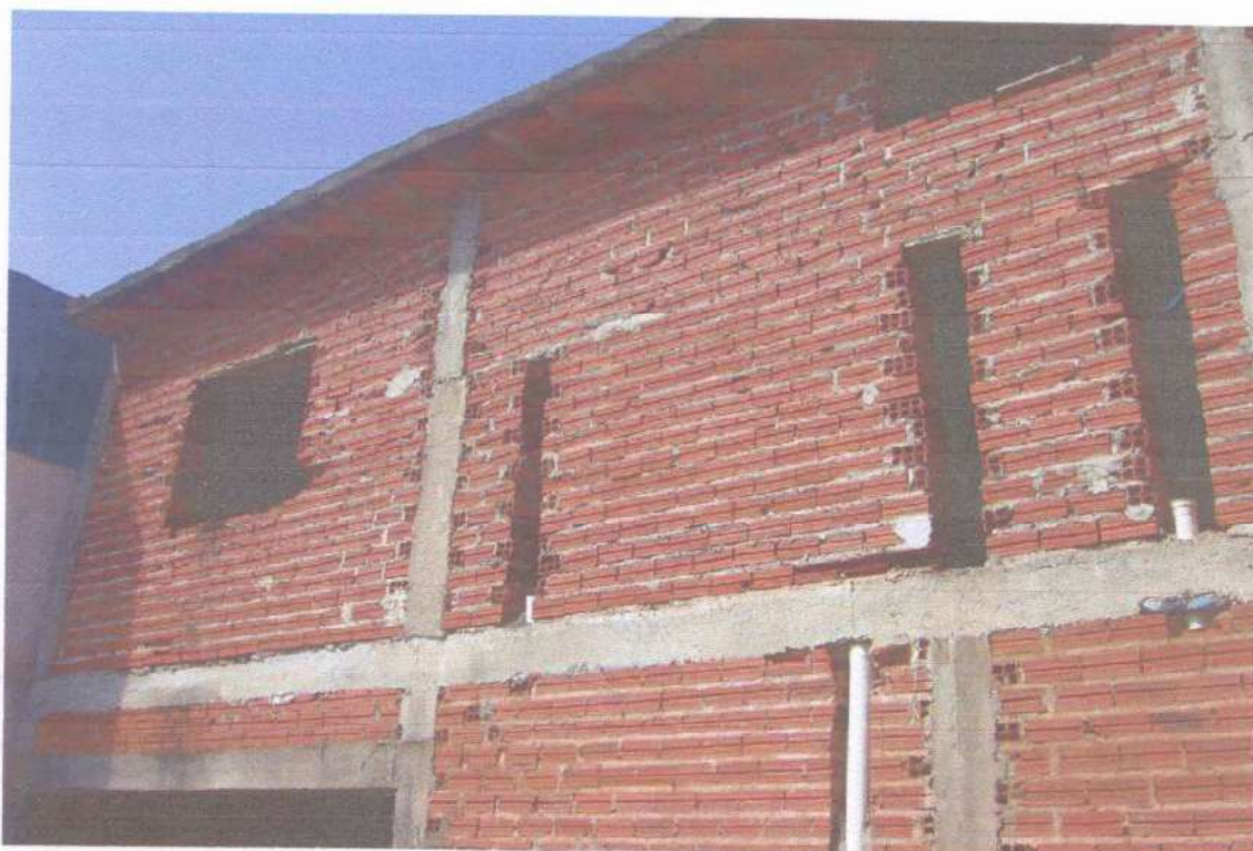
FOTO 07 - Outra Vista da mesma obra.
