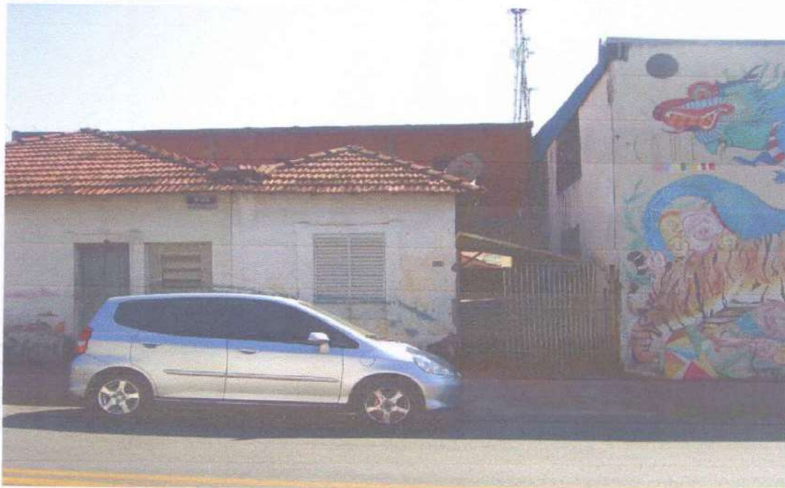
FOTO 01 - Vista da Fachada do Imóvel A onde vemos os 06 cômodos na parte frontal em precário estado de conservação.
