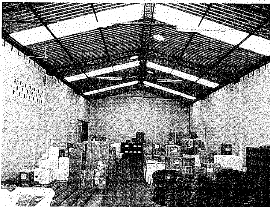
Interior Lote 02 - Ao fundo, acesso ao Lote 03
