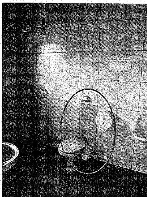
Chácara São Pedro - Banheiro externo. Detalhe umidade do sanitário e forro de PVC
