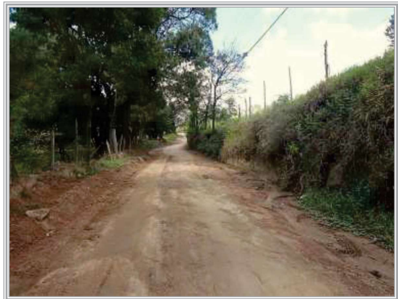
Foto nº 03 (📍): Visão da Estrada do Banho Turco evidenciando as razoáveis condições de conservação do leito viário.
