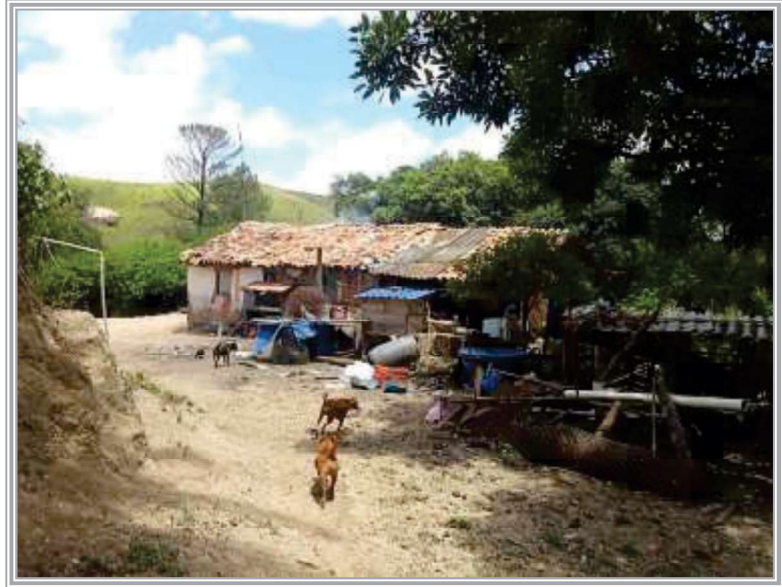
Foto nº 18 (📍): Registra a imagem a elevada antiguidade da habitação (principal benfeitoria), cuja rusticidade proporciona precárias condições de de habitação.
