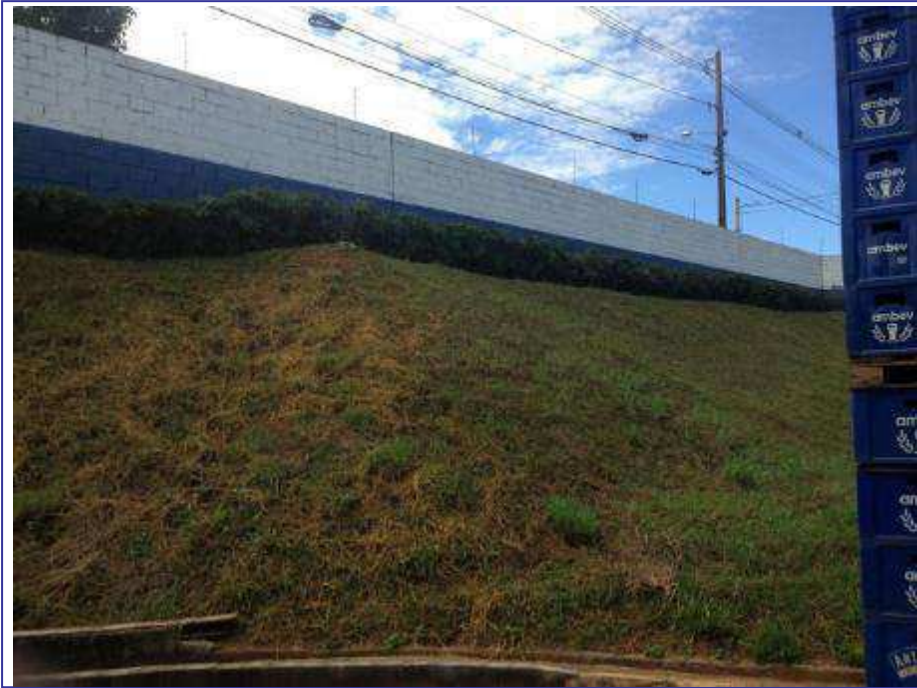
TALUDE E MURO
