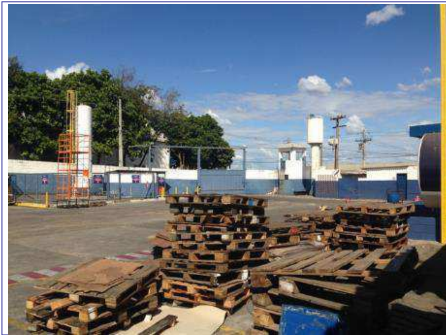
GLP, GUARITA DISTRIBUIÇÃO E CASA DE BOMBAS DO LAVADOR
