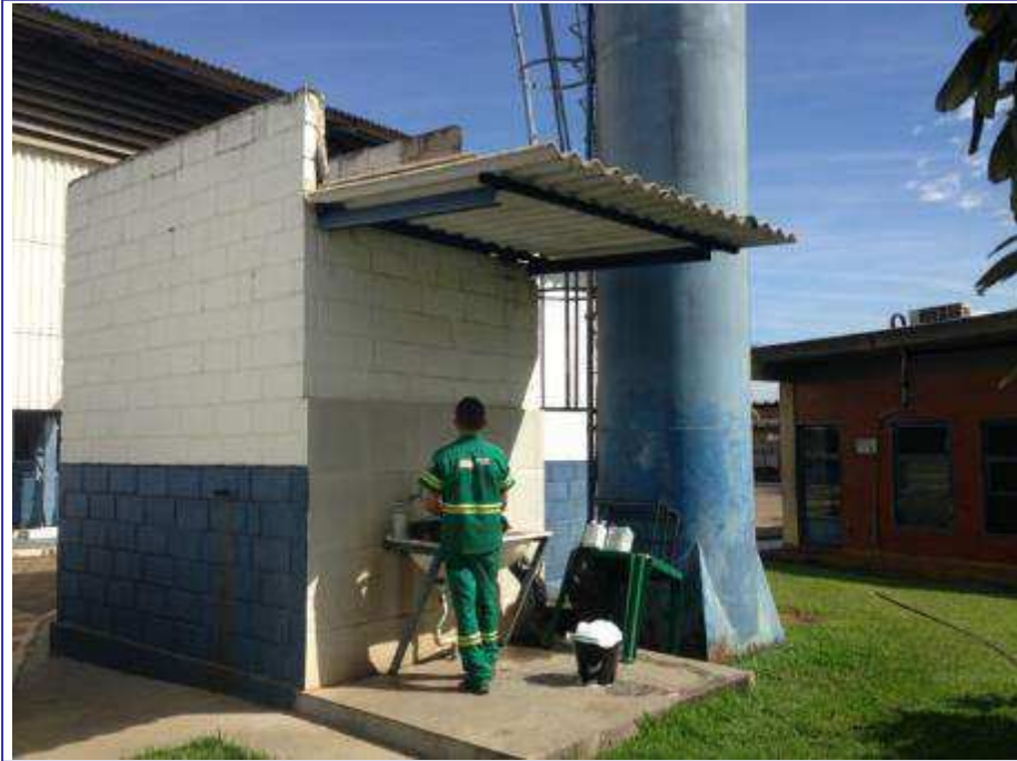
CASA DE BOMBAS
