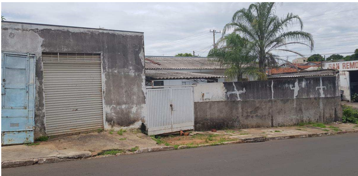
Fachada do imóvel avaliando sito à Rua Alcides Caliman nº 358 x Rua Miguel Pastori.
