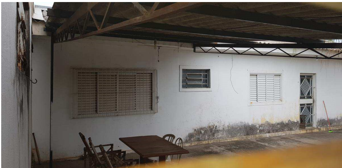
Vista da edificação sita à Rua Alcides Caliman nº 358.
