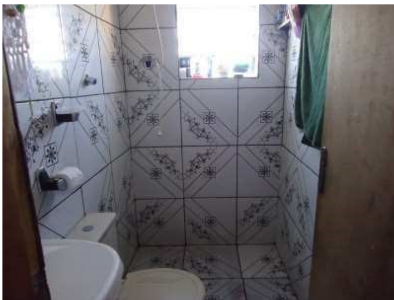
Foto 16 - Detalhe interno da edificação – Pav. Superior – Banheiro
