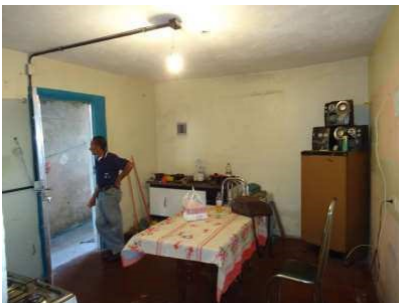
Foto 22 - Detalhe interno da edificação – Pav. Térreo – Cozinha
