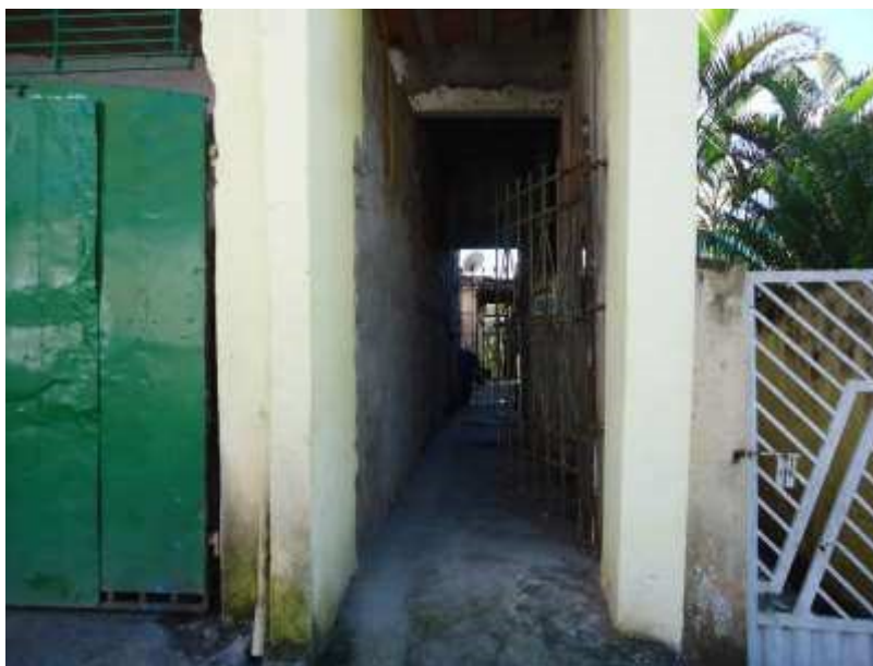
Foto 19- Entrada para a construção II
