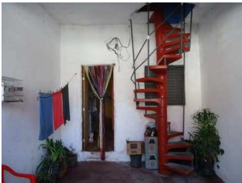
Foto 12- Detalhe externo da edificação – Escada para o Pav. Superior
