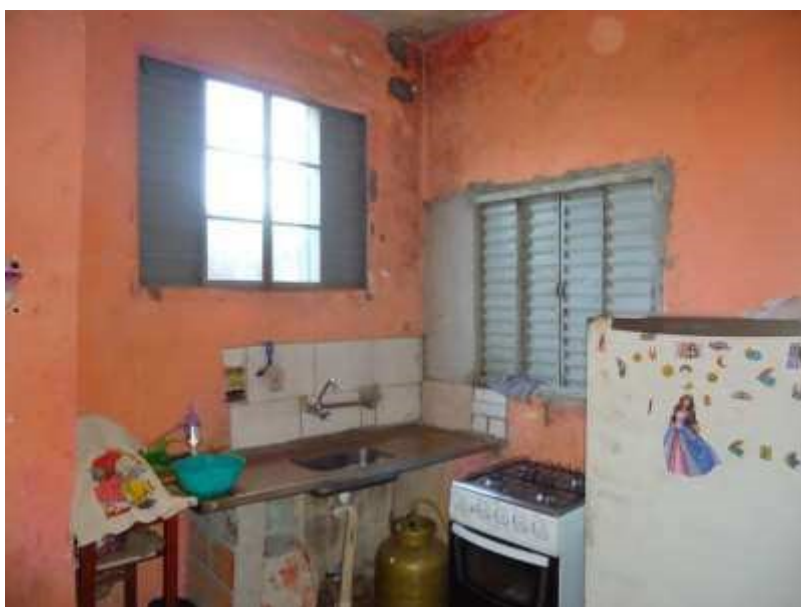
Foto 08- Detalhe interno da edificação – Pav. Térreo - Cozinha
