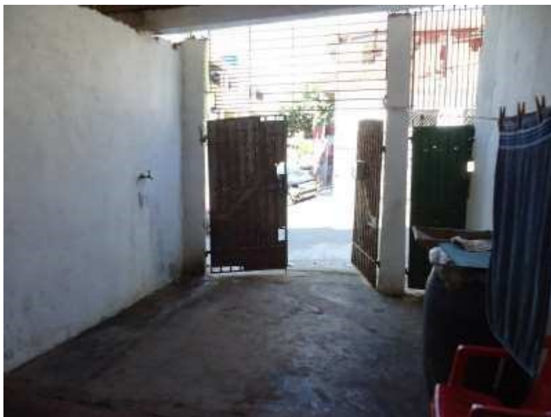
Foto 07: Detalhe externo da edificação – Pav. Térreo - Garagem
