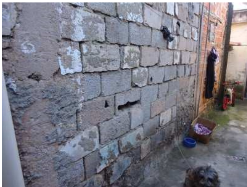
Foto 05- Detalhe externo da edificação – Pav. Térreo – utilização de sobra de materiais
