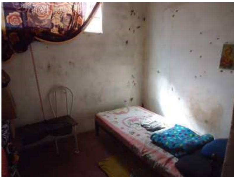
Foto 11 - Detalhe interno da edificação – Pav. Térreo - Dormitório
