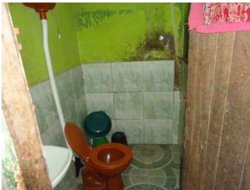
Foto 09- Detalhe interno da edificação – Pav. Térreo - Banheiro
