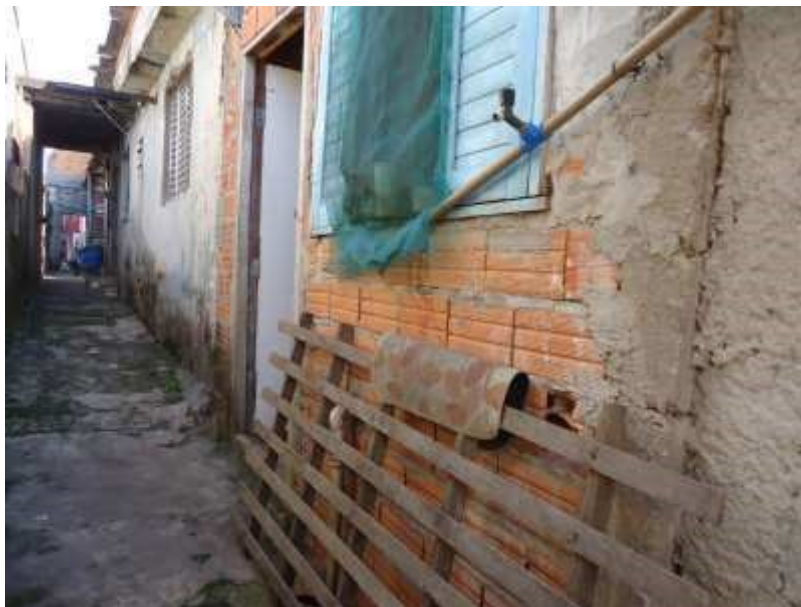
Foto 25 - Fachada da construção II - Fundos
