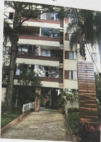
Vista da fachada do Edifício Antúrio.
