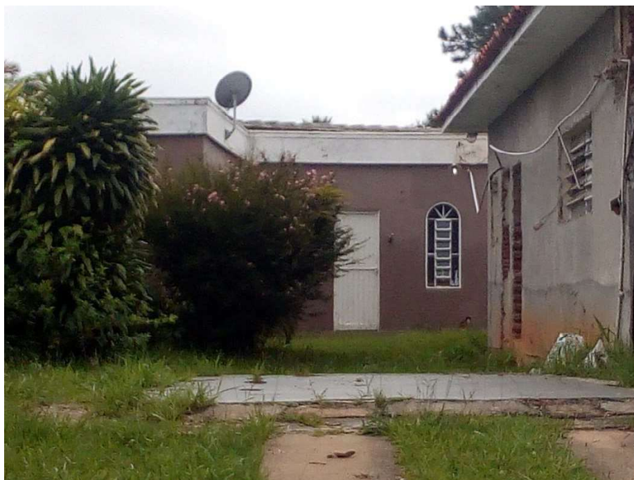
VISTA DAS CONSTRUÇÕES ERGUIDAS NOS FUNDOS DO TERRENO.
