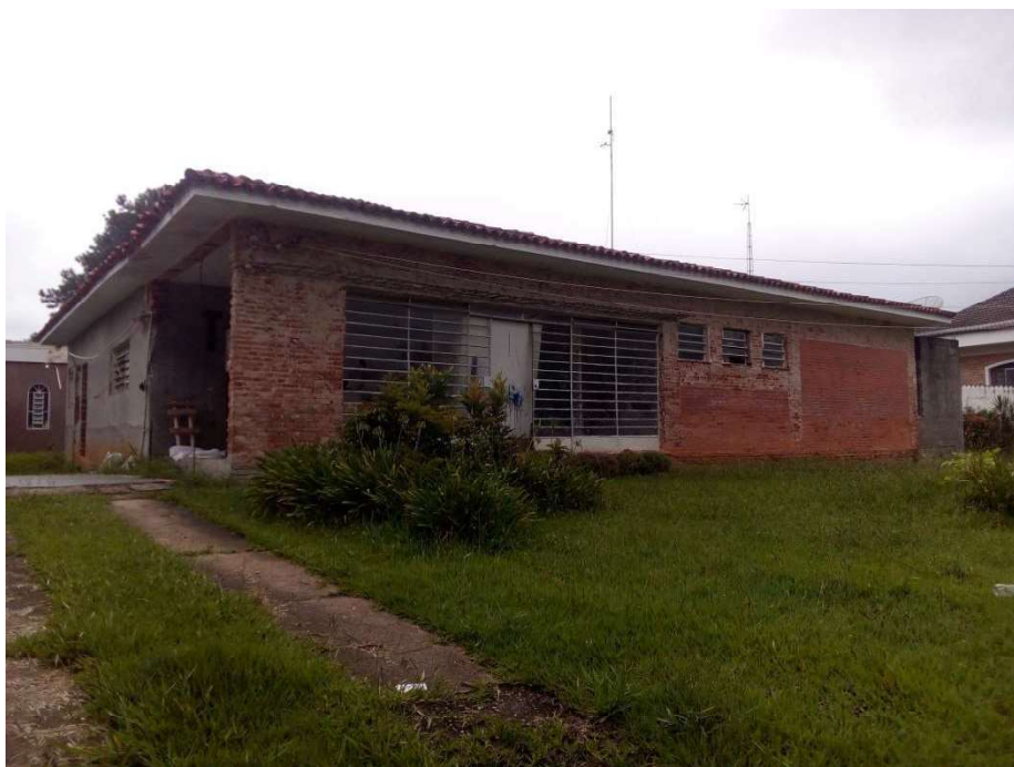
VISTA DAS CONSTRUÇÕES ERGUIDAS SOBRE O TERRENO.
