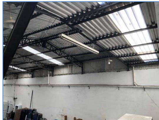
Foto 8 – Vista da cobertura metálica
