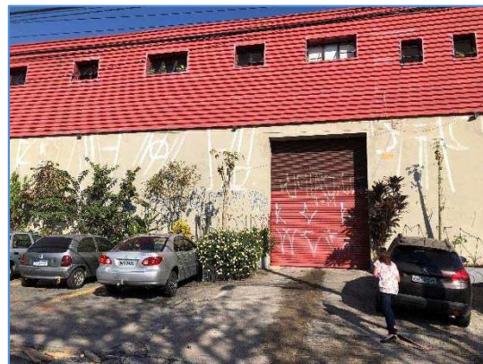
Foto 2 – Vista da fachada frontal do imóvel, consubstanciado nas duas matriculas penhoradas nos autos
