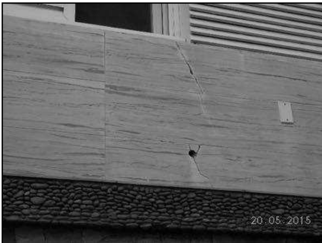
vista da fachada: detalhe da alvenaria
