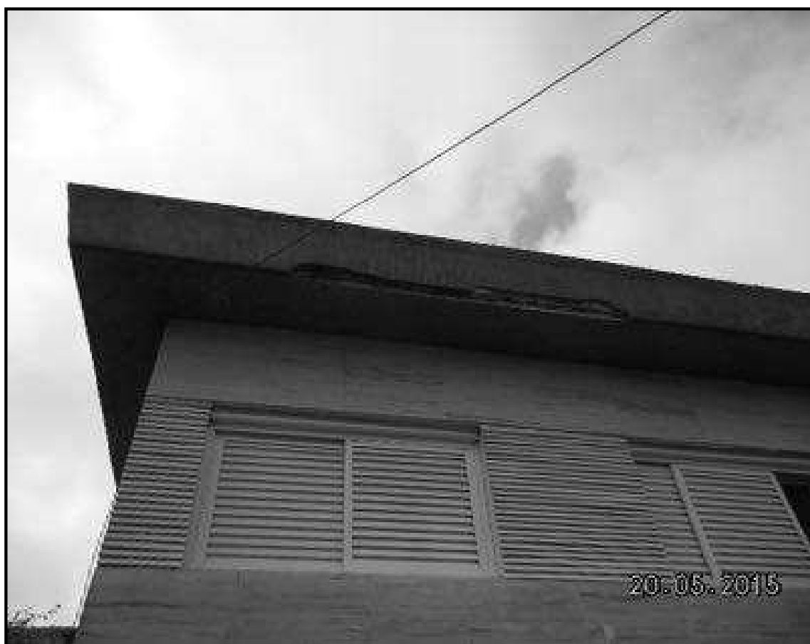
vista da fachada: detalhe do beiral do telhado
