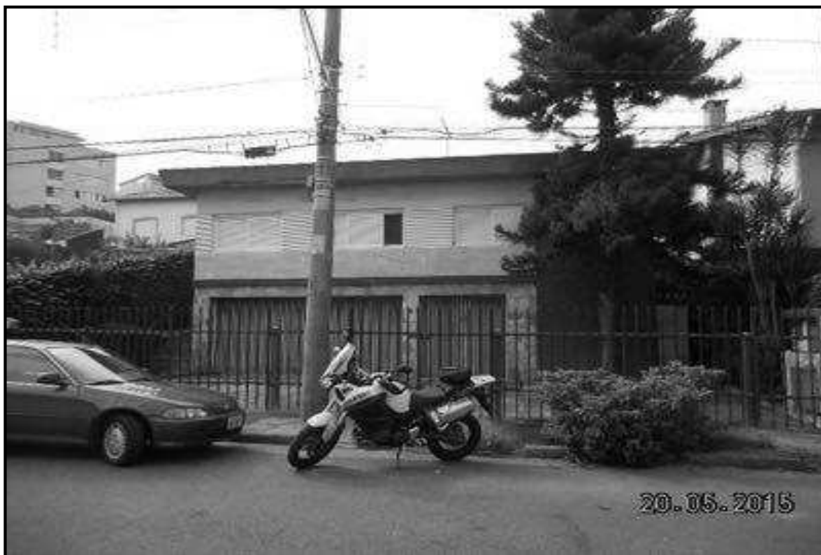
vista frontal do imóvel avaliando
