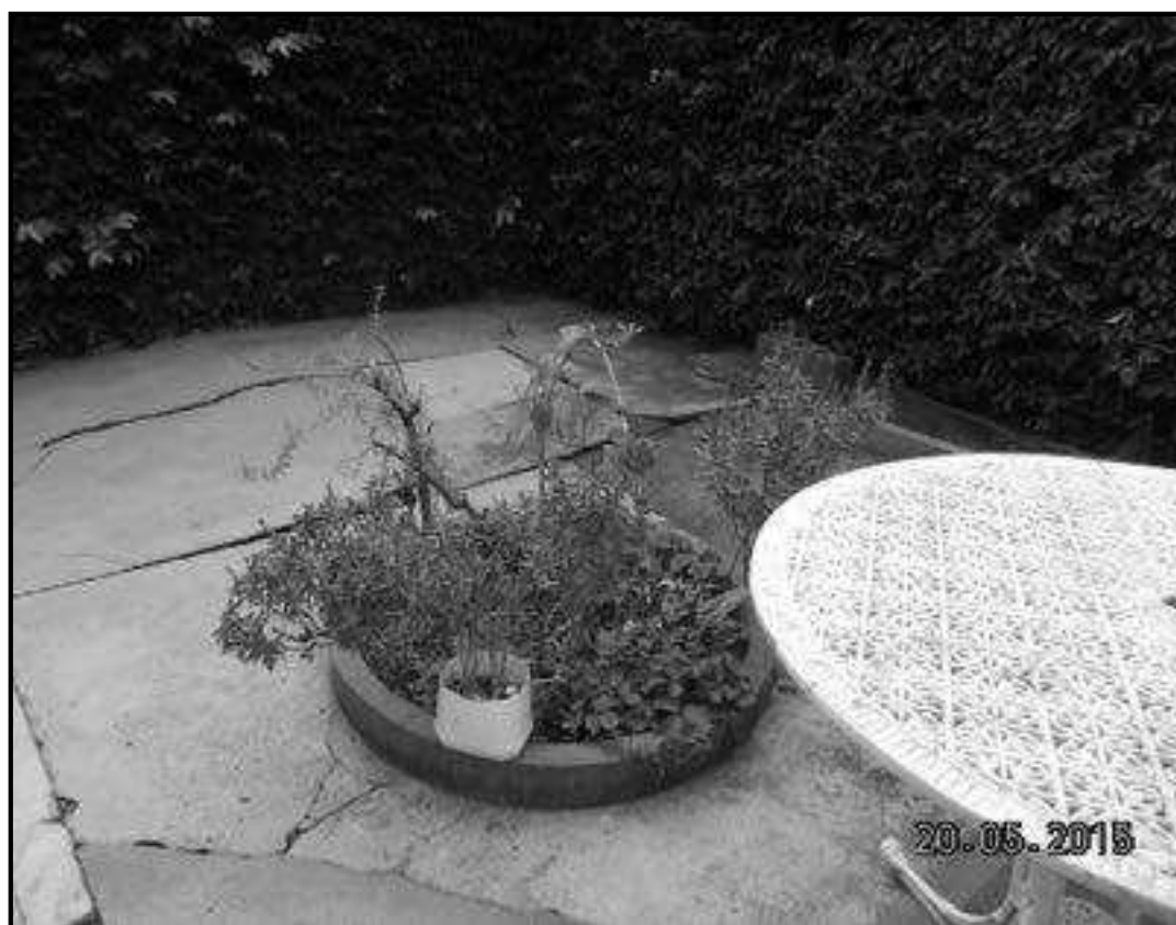
vista da fachada dos fundos: detalhe do piso
