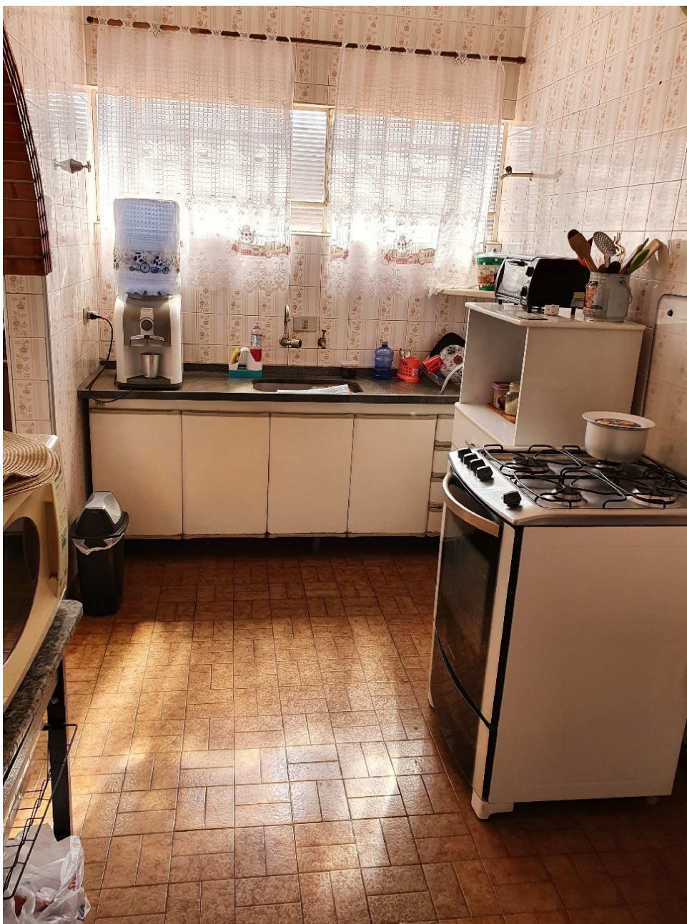
Foto 36 – Azulejos até o teto e piso de cerâmica.
