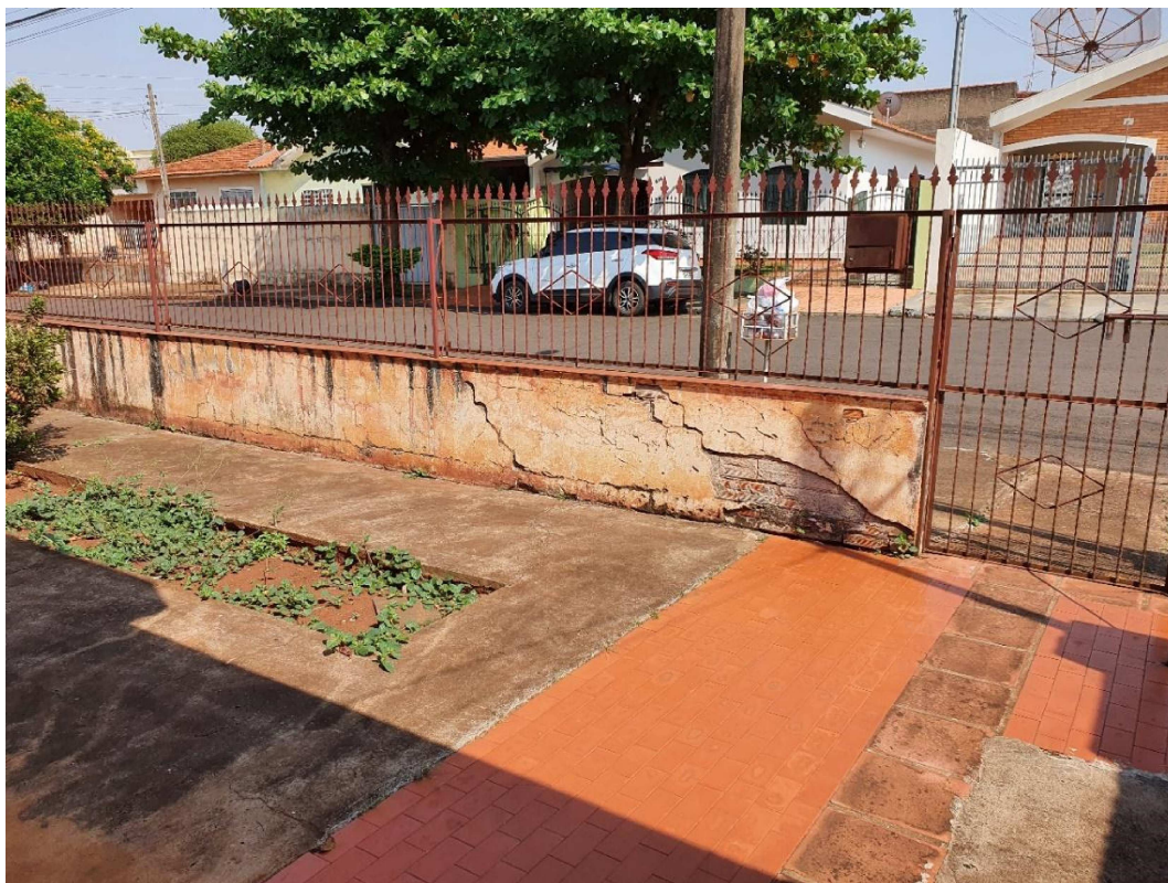
Foto 73 – Reboco do muro despregando, calçada do passeio público, quebrada
