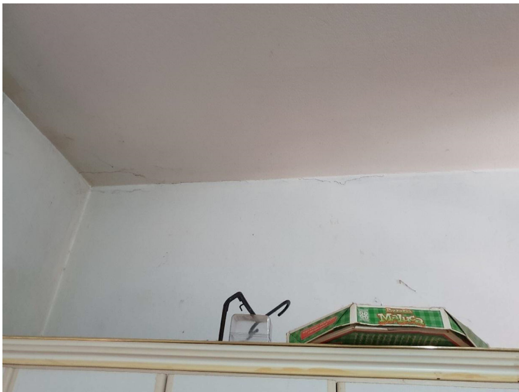
Foto 49 – Trincas seguem pela parede da janela.
