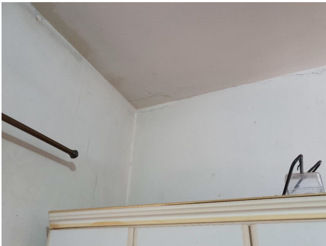
Foto 49 – Trincas seguem pela parede da janela.
