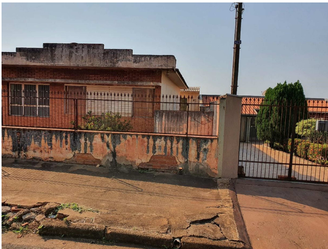
Foto 73 – Reboco do muro despregando, calçada do passeio público, quebrada
