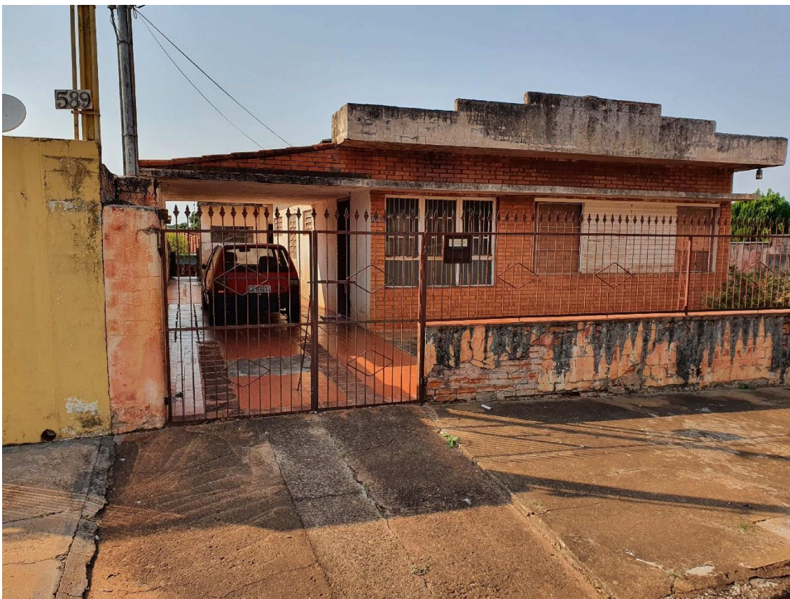
Fotos 1 e 2 - Vistas da Fachada do imóvel
