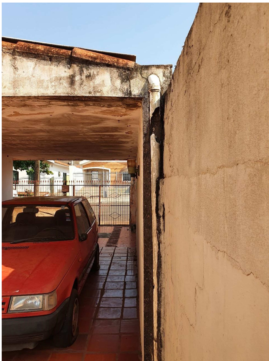
Foto 24 –Garagem, vista dos fundos para a frente
