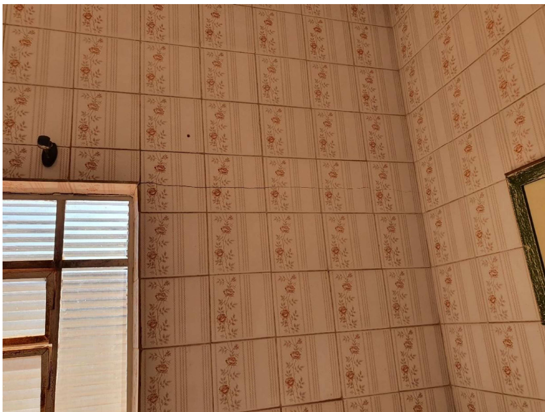
Foto 40 – Várias Rachaduras horizontais nos azulejos ao lado da janela, lado direito para quem fica de frente para ela.
