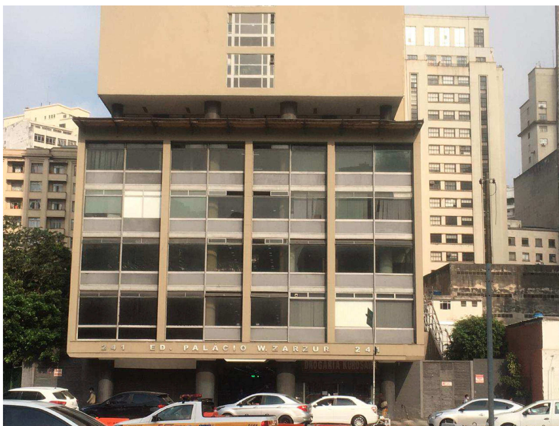
FOTO 5: FACHADA DO PRÉDIO.
