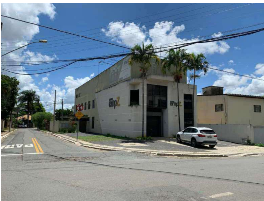
Figura 4: Imagens externas do Prédio Comercial, na Rua 135.
