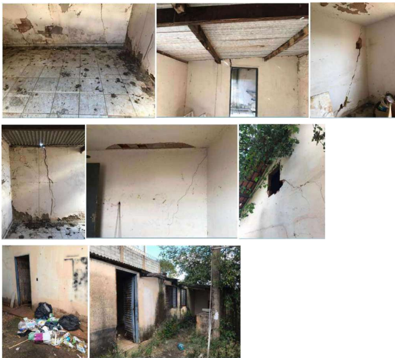
Figura 4: Imagens externas e internas do imóvel.
