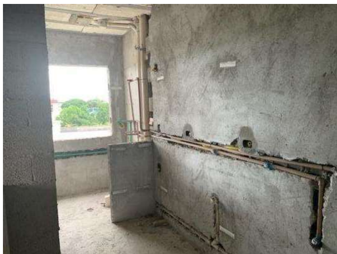
Foto 13. Vista da cozinha de um dos apartamentos da Torre 2. Vide aí, que foram instaladas as tubulações hidrossanitárias, e passados os eletrodutos da rede elétrica. Observe aí também, que faltam acabamentos e instalação de esquadrias.
