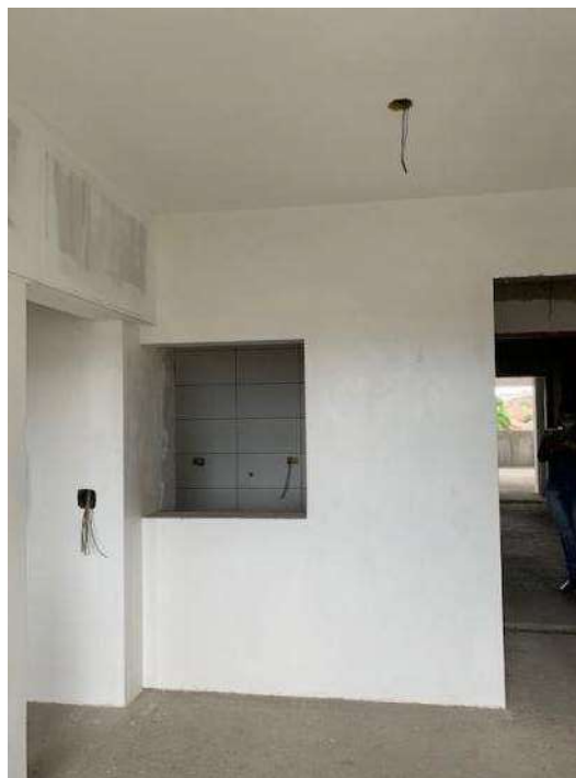
Foto 08. Vista da sala de um dos apartamentos da Torre 1. Vide aí que foi realizada aplicação de gesso nas paredes, executado contrapiso e passados eletrodutos e condutores da rede elétrica. Não foi instalada esquadria. Situação repete-se do 4º ao 12º pavimento.
