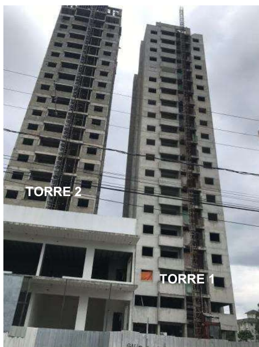
Foto 02. Vista da fachada das edificações residenciais denominadas Torres 1 e 2 do empreendimento denominado "Condomínio Single Life Residence". Vide aí que encontram-se inacabadas.
