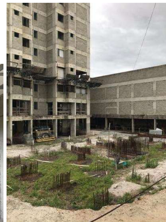
Foto 15. Vista do local em que seria construída a Torre 3 do empreendimento em tela. Vide aí, os arranques para pilares, para construção da edificação.
