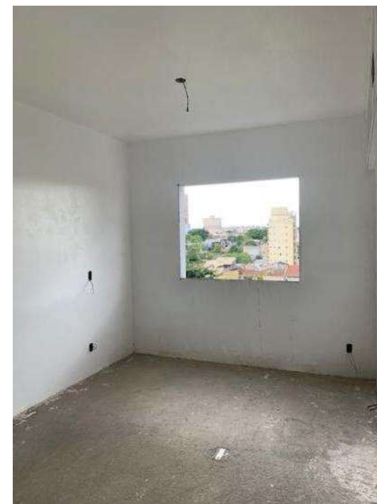
Foto 06. Vista do dormitório de um dos apartamentos da Torre 1. Vide aí que foi realizada aplicação de gesso nas paredes, executado contrapiso e passados eletrodutos e condutores da rede elétrica. Não foi instalada esquadria. Situação repete-se do 4º ao 12º pavimento.
