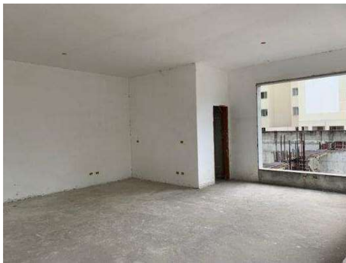
Foto 16. Vista de umas salas comerciais do pavimento térreo do bloco comercial. Observa-se aí, que possui revestimento nas paredes, contrapiso executado e instalação elétrica feita. Em vistoria verificou-se que foram realizadas instalações hidrossanitárias, ficando restante a instalação das esquadrias de vidro da fachada.
