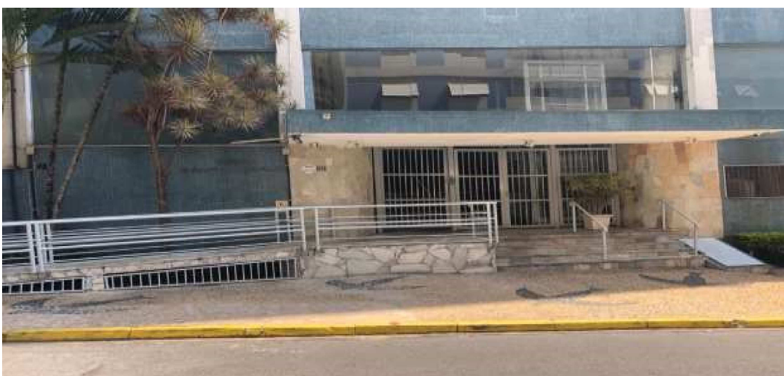
Portão de acesso
