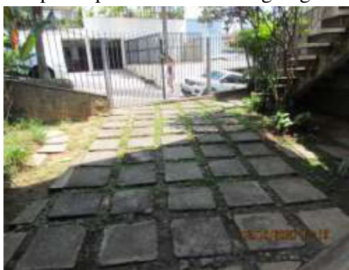
Tipo de piso na entrada da garagem
