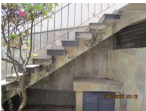
Área embaixo da escada, com acesso à parte superior do imóvel
