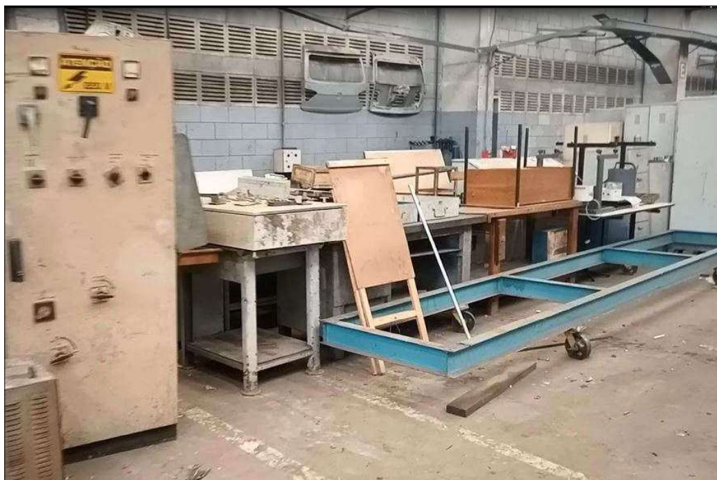
VISTA DO PAINEL ELETRICO EM FERRO, BANCADAS EM FERRO, MESAS DE MADEIRA
