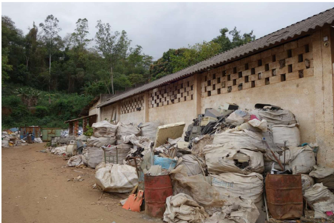
Foto 34. Lateral do galpão.
