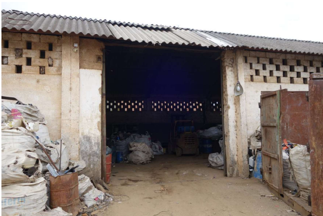
Foto 24. Entrada para o galpão.
