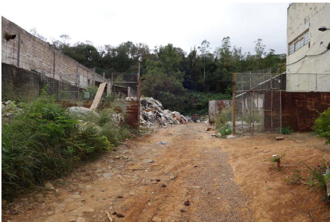
Foto 19. Acesso para o galpão
