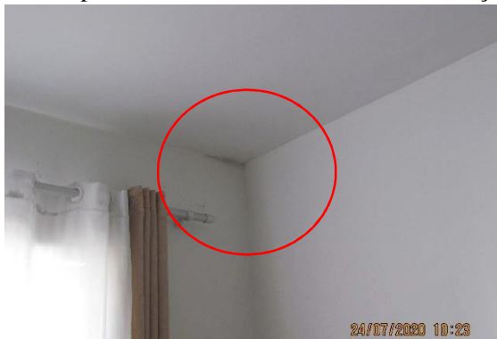
Canto parede da sala com sinal de infiltração
