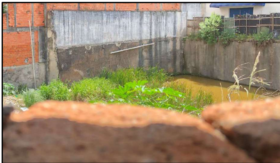
Foto 4 – Vista interna do terreno – Vista 1
