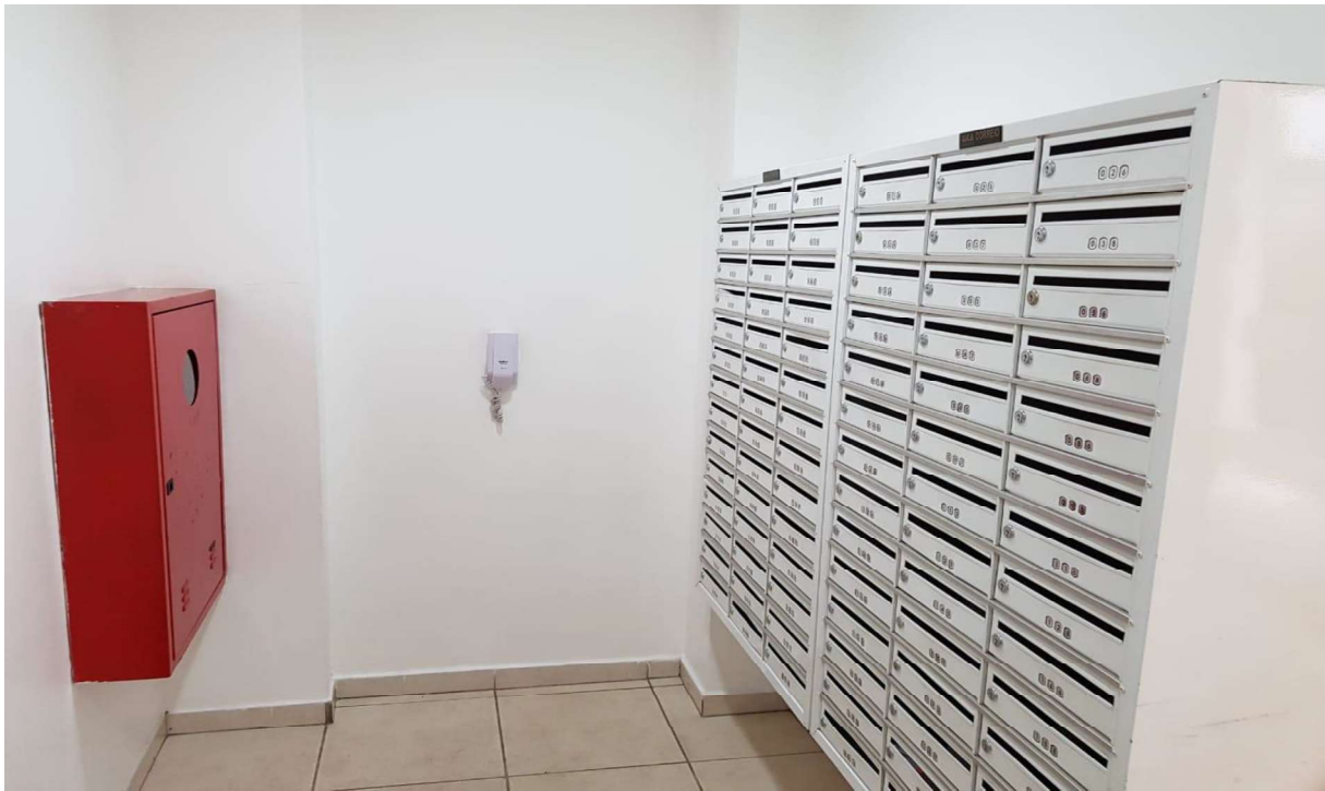
Foto 9 – Escaninho de correspondências – Bloco 3 – apartamentos finais 5 a 8
