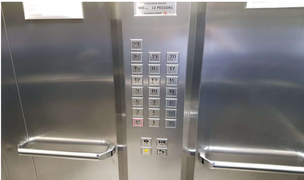
Foto 10 – Elevador Bloco 3 – apartamentos finais 5 a 8
