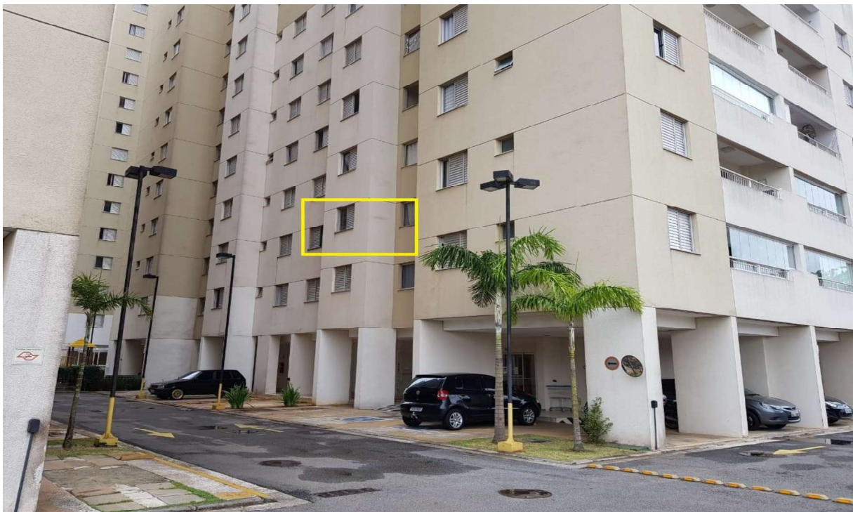
Foto 6 – Fachada Bloco 3 – no detalhe o apartamento 25
