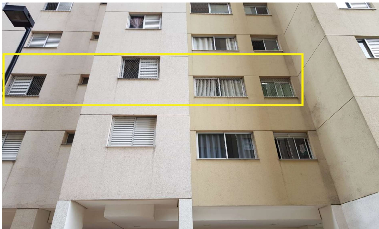
Foto 3 – Fachada do Bloco 3 – no detalhe a fachada do apartamento 25
