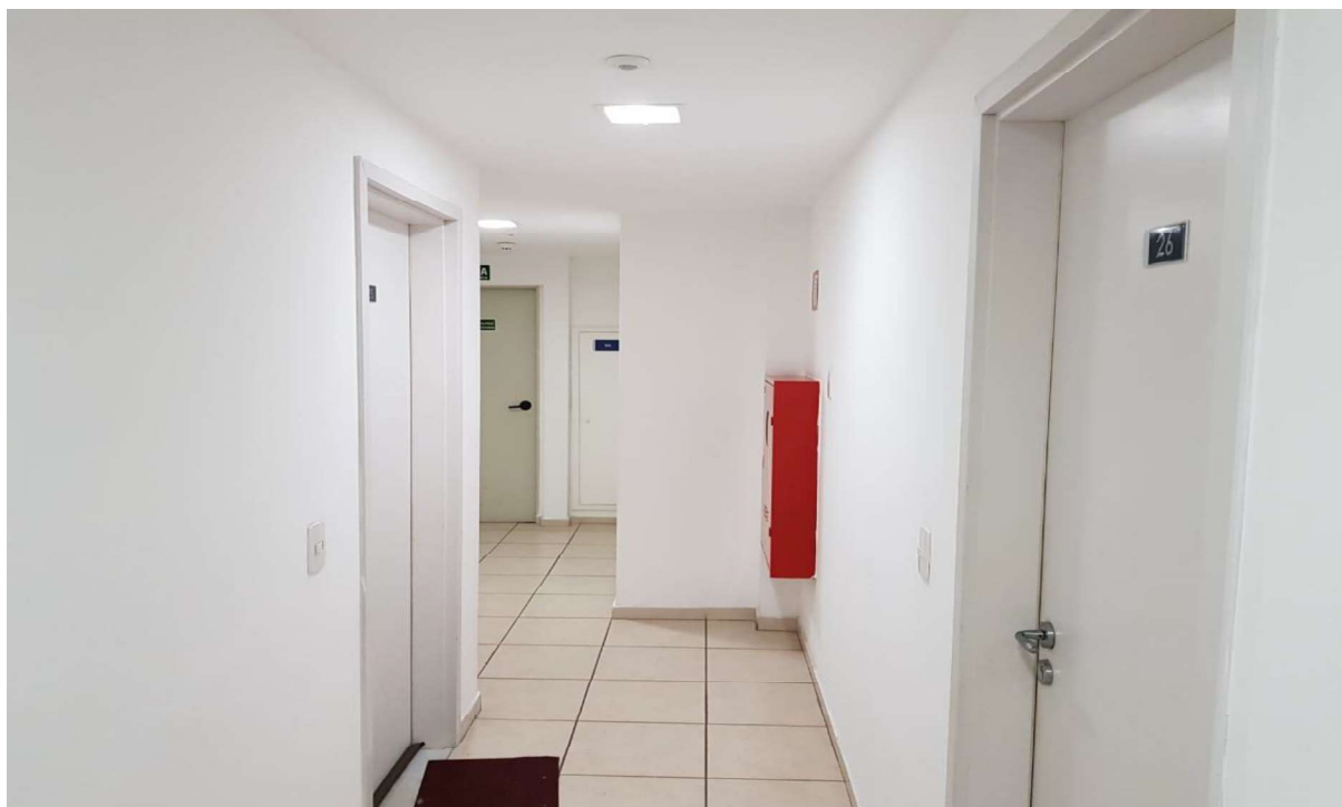
Foto 12 – Hall dos apartamentos 5 a 8 – 2° andar
