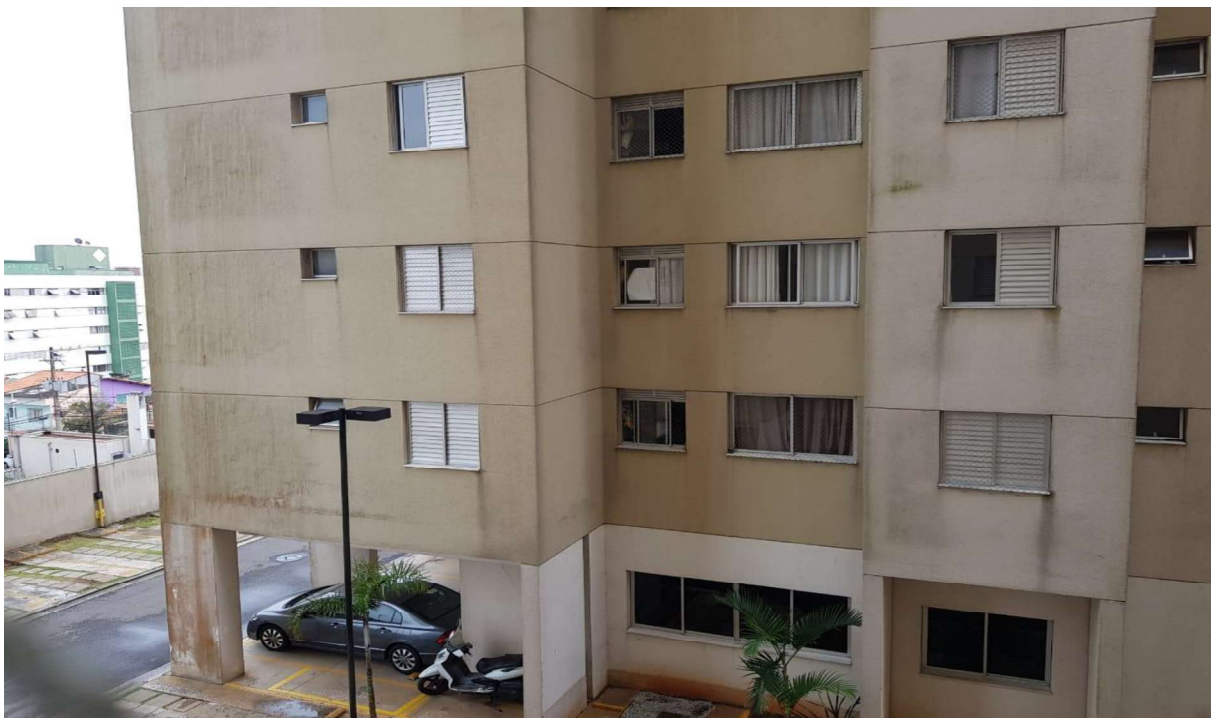
Foto 28 – Vista da via de circulação interna e do Bloco 2
