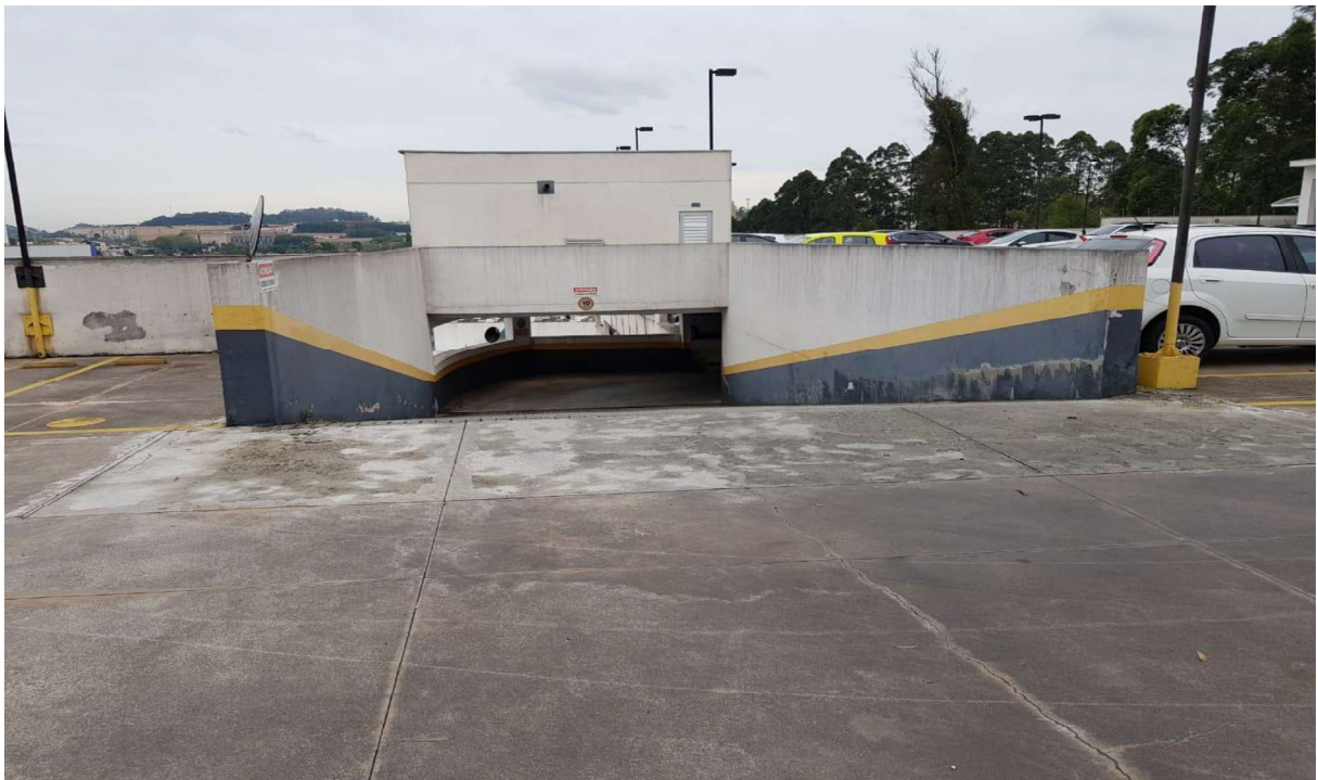
Foto 56 – Rampa de acesso à garagem do subsolo
