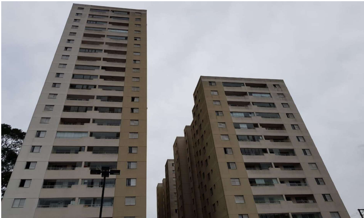
Foto 5 – Fachada dos Blocos 4 e 1
