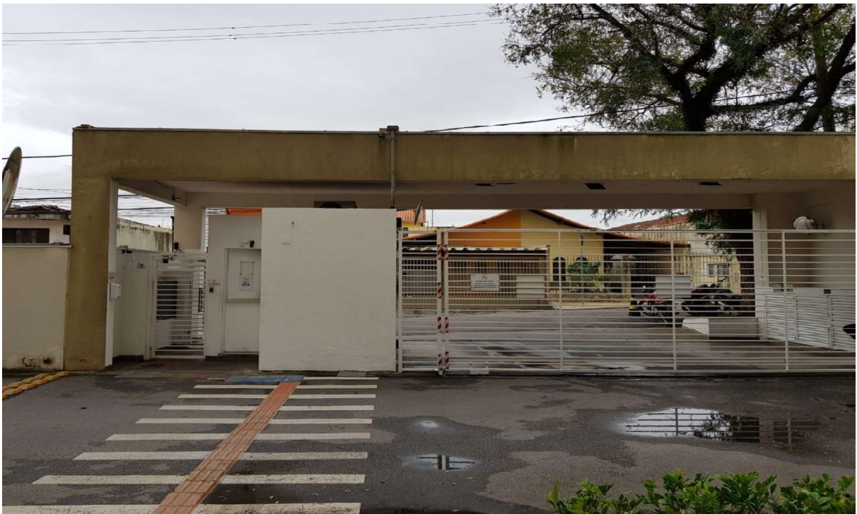
Foto 58 – Portaria – lado interno
