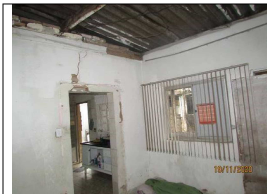
Foto n.º 14. Vista do quarto 2 da casa 1.
