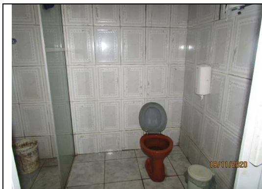
Foto n.º 11. Vista do Banheiro da casa 1.
