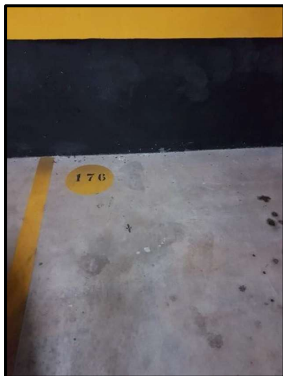
Indicação da vaga nº 176 junto a parede
