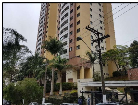
Vista geral da fachada do Edifício
