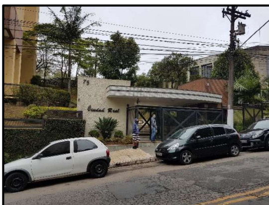
Vista da entrada do Edifício
