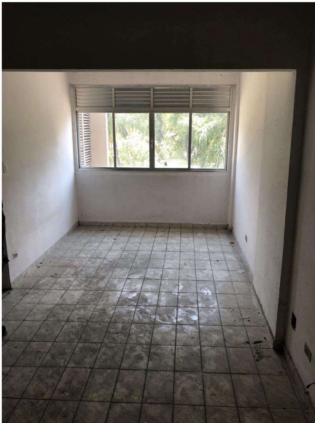
FOTO 3 – VISTA DA SALA
