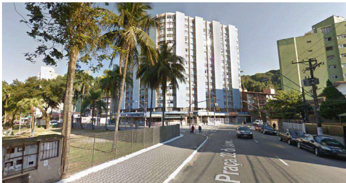
FOTO 2 – VISTA FRONTAL DA EDIFICAÇÃO
