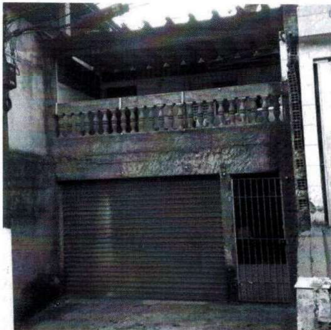
Frente do imóvel, vista a partir da Rua Alexandre Biagio. Fotografia realizada em 08/05/2020.
