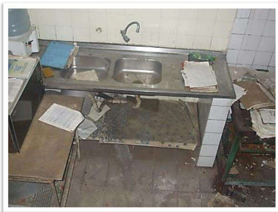
Foto 13: Vista parcial da cozinha nos fundos do andar térreo.
