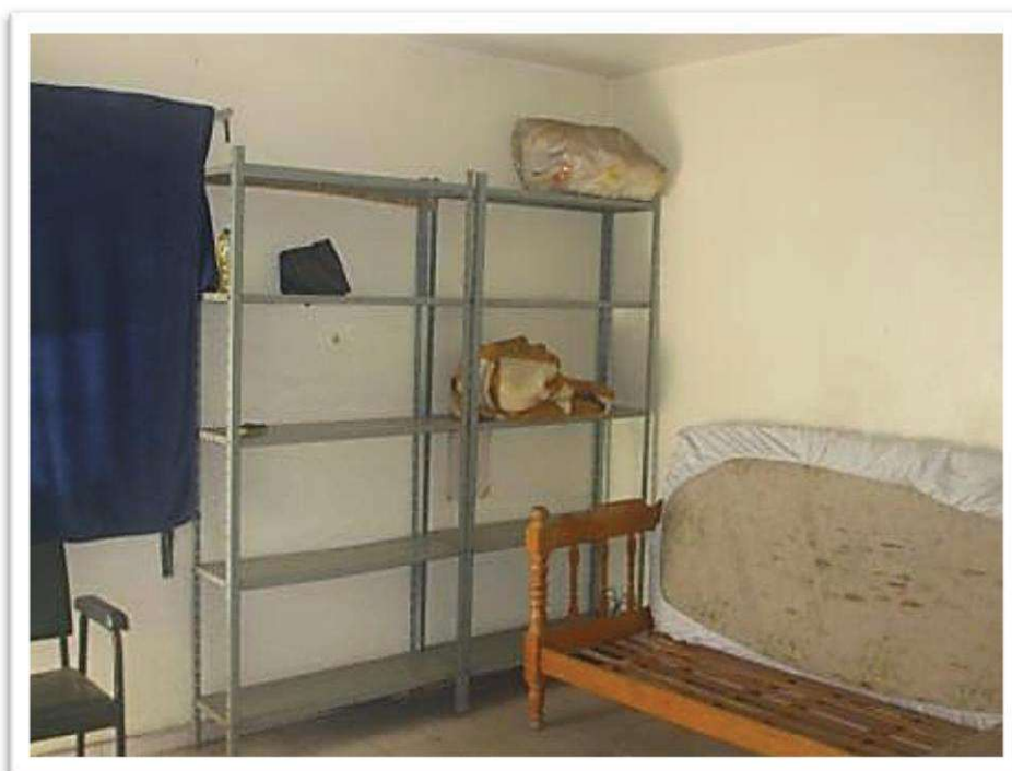
Foto 6: Vista parcial do cômodo da frente no andar superior.
