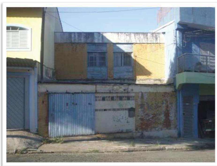
Foto 1: Fachada para a Rua Senador Queiros.
