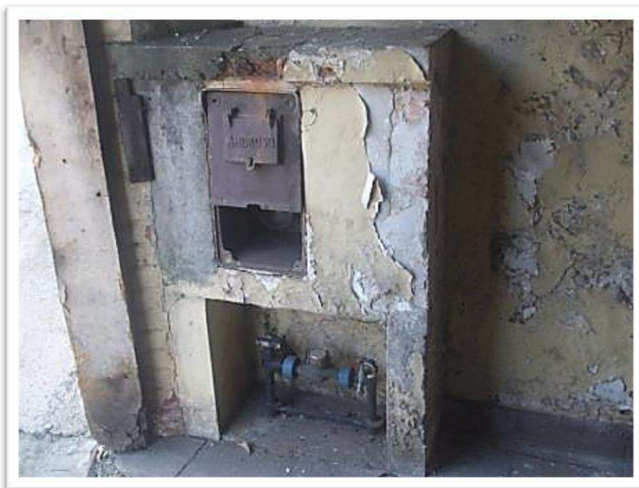
Foto 3: Vista do medidor de energia elétrica e água.
