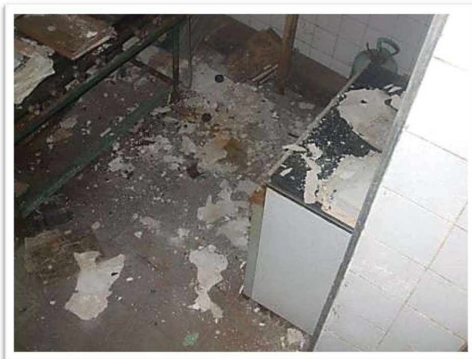
Foto 14: Vista de parte da copa nos fundos no térreo.
