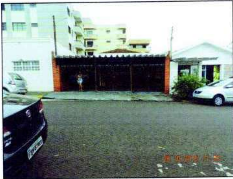
Fachada frontal do imóvel
