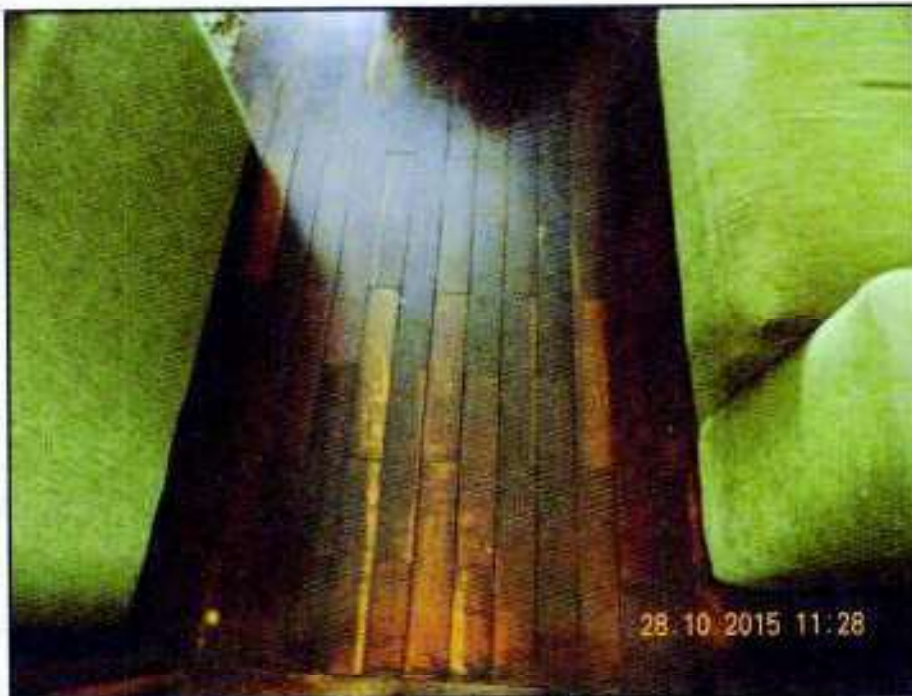
Sala – detalhe do piso
