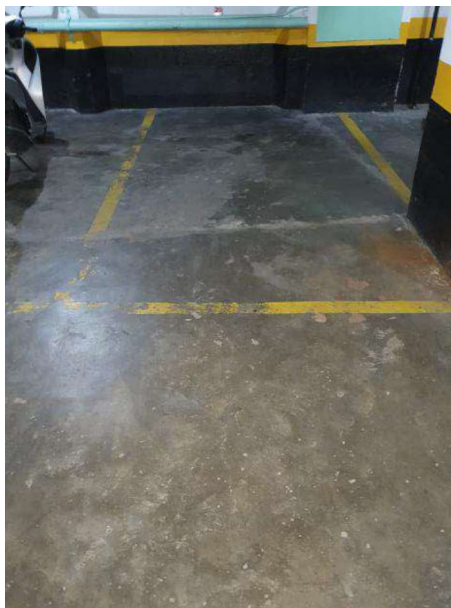
FOTO N° 02 Vista da vaga de garagem do imóvel avaliando
