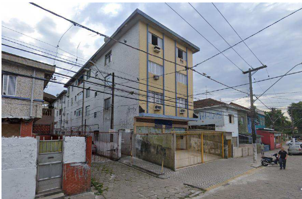
FOTO 2 – VISTA FRONTAL DA EDIFICAÇÃO
