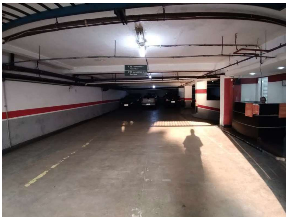
VISTA DA ÁREA COMUM DA GARAGEM.
