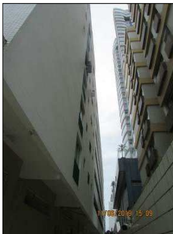
Fotos 02/04 – Vista parcial das áreas comuns do edifício.
