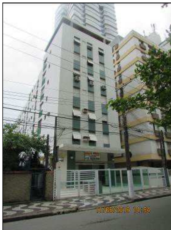
Foto 01 – Fachada frontal do Cond. Edifício Praia Linda.
