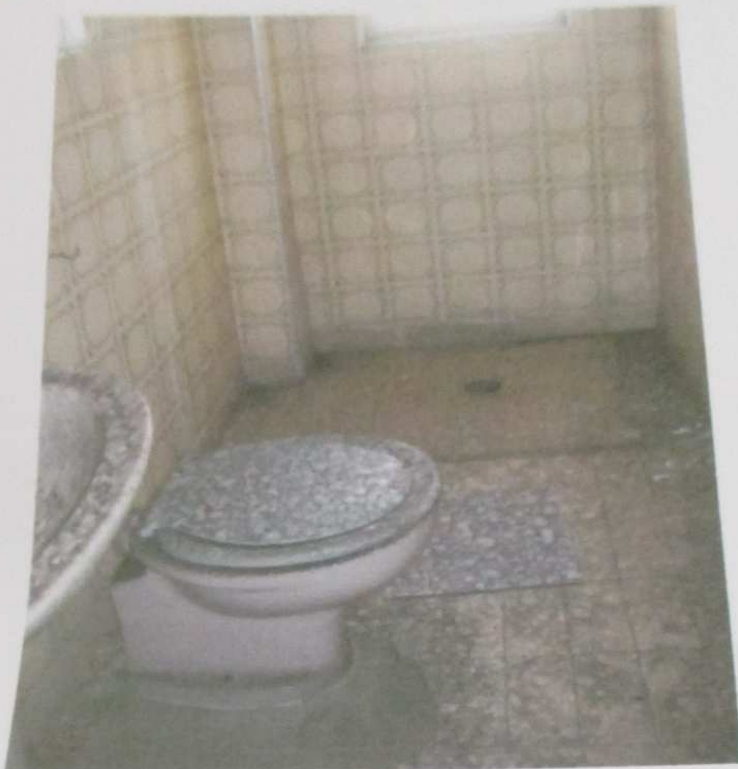
FOTO 142: Vista do banheiro do imóvel.
