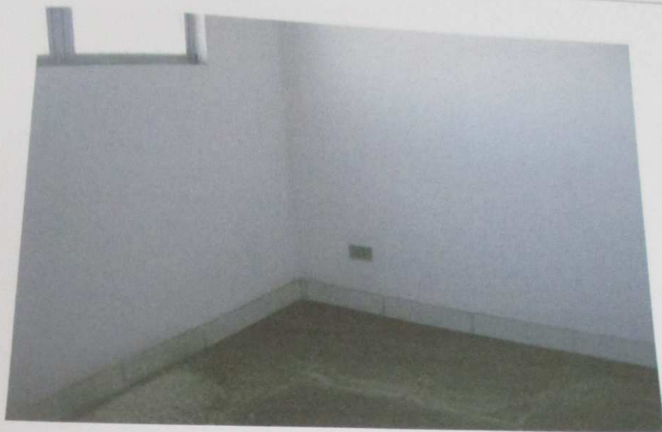
FOTO 105: Vista da sala do imóvel.
