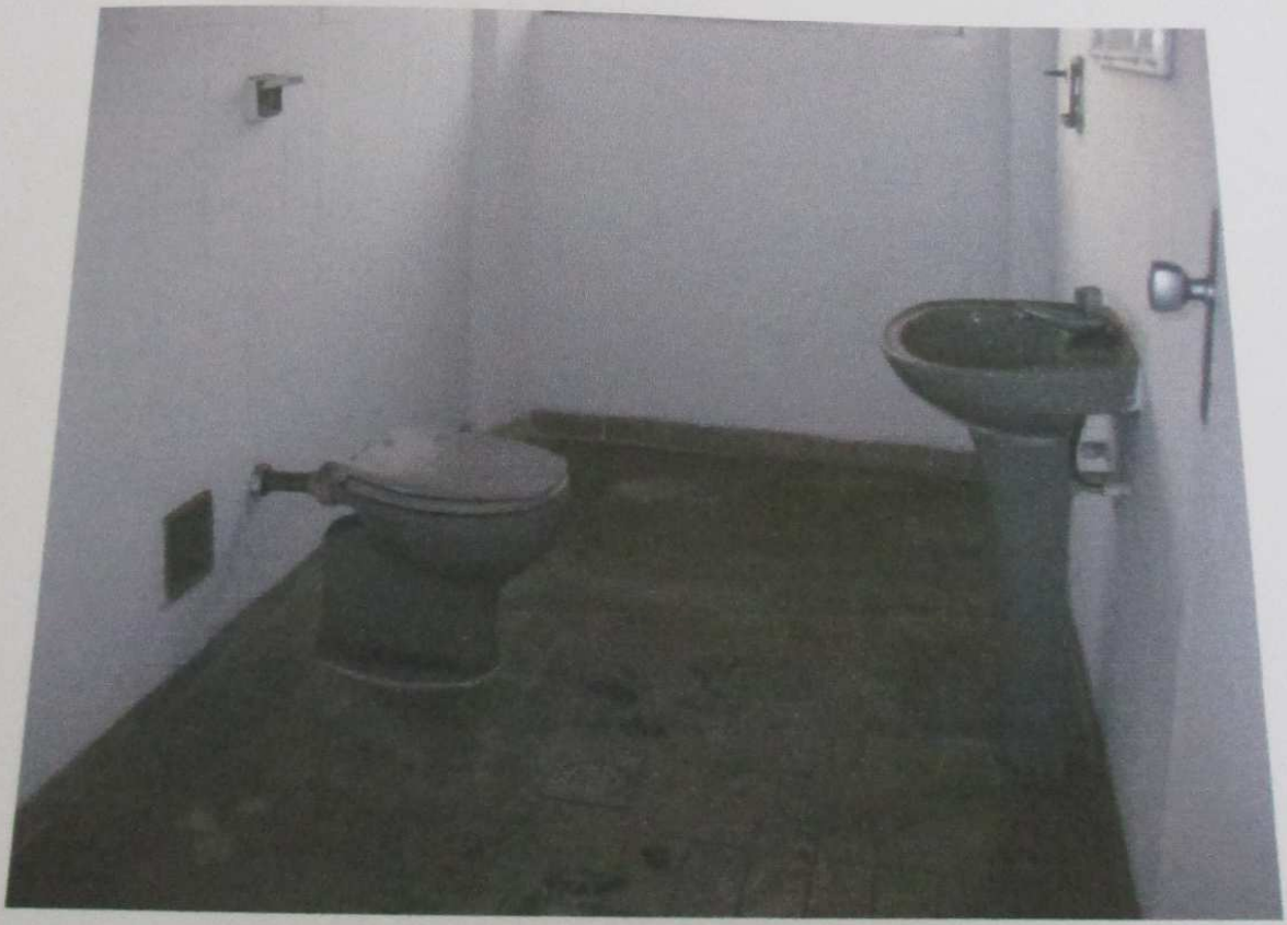
FOTO 32 : Vista do banheiro do imóvel.
