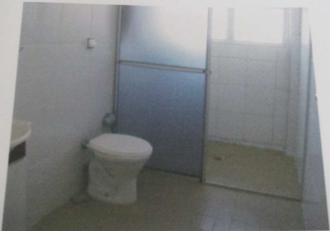
FOTO 179: Vista do banheiro do imóvel.
