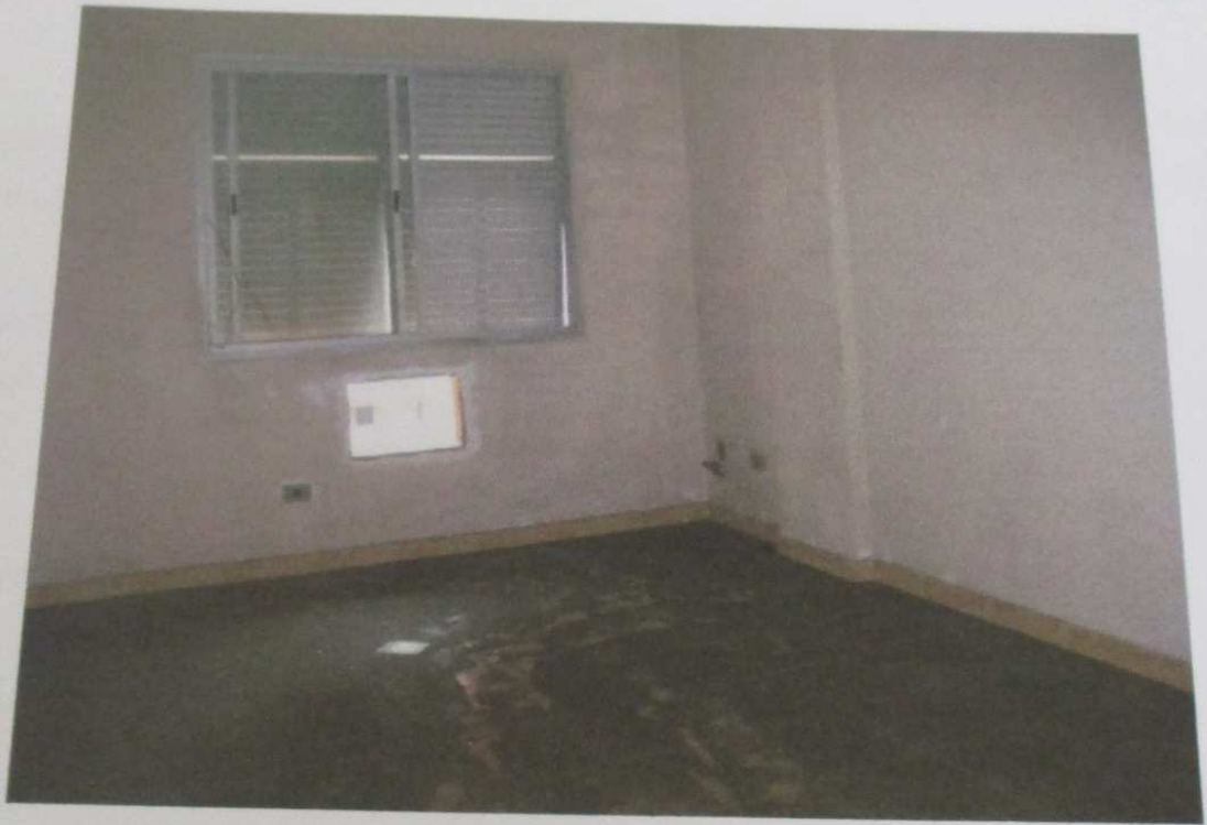
FOTO 144: Vista do dormitório do imóvel.
