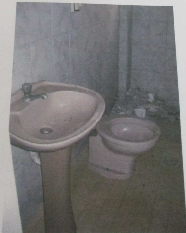
FOTO 18: Vista do banheiro do imóvel.
