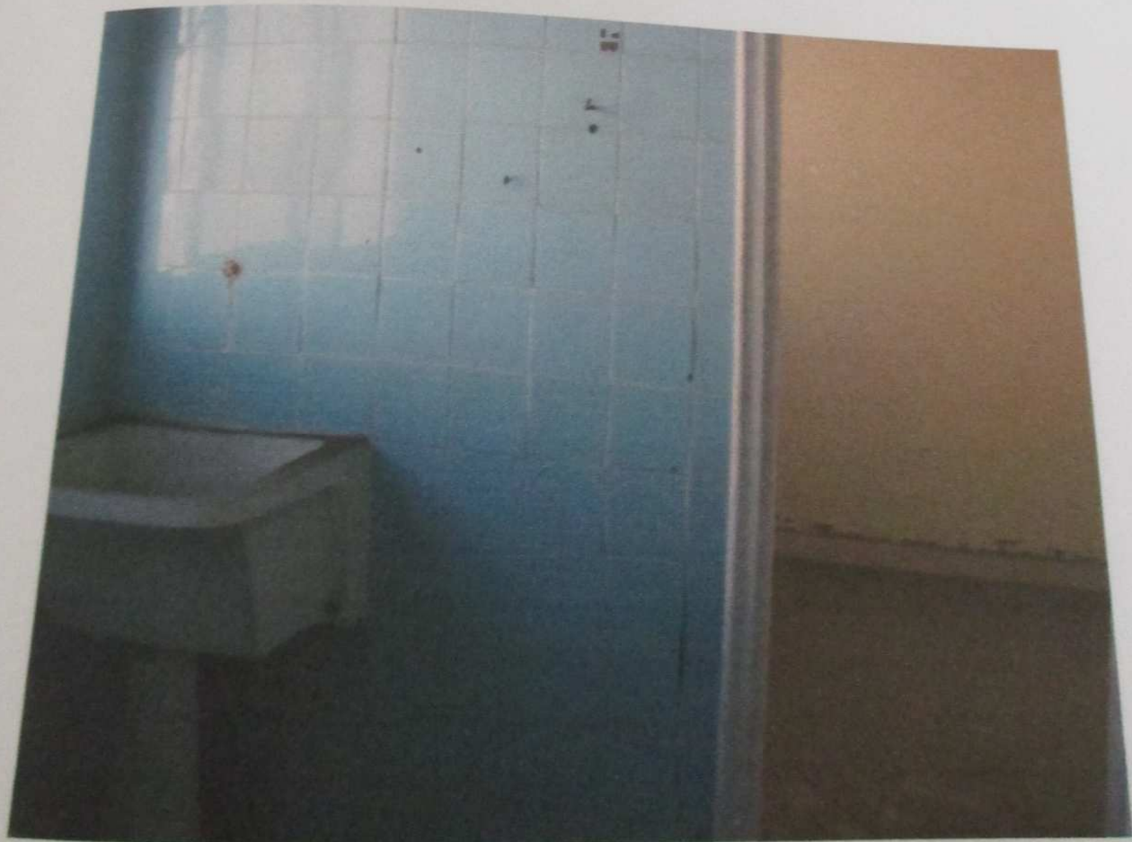
FOTO 91: Vista da área de serviço do imóvel.
