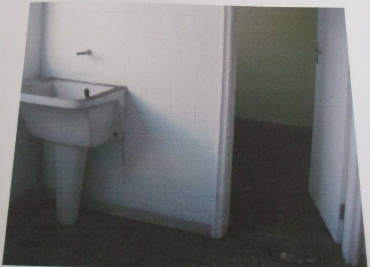
FOTO 30 : Vista da área de serviço do imóvel.
