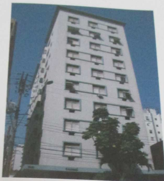
FOTO 3 : Outra vista da fachada do imóvel.
