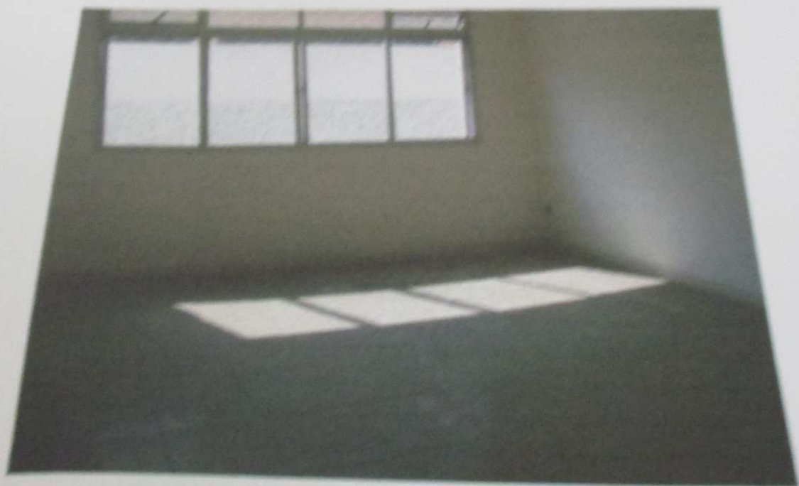
FOTO 124: Vista da sala do imóvel.
