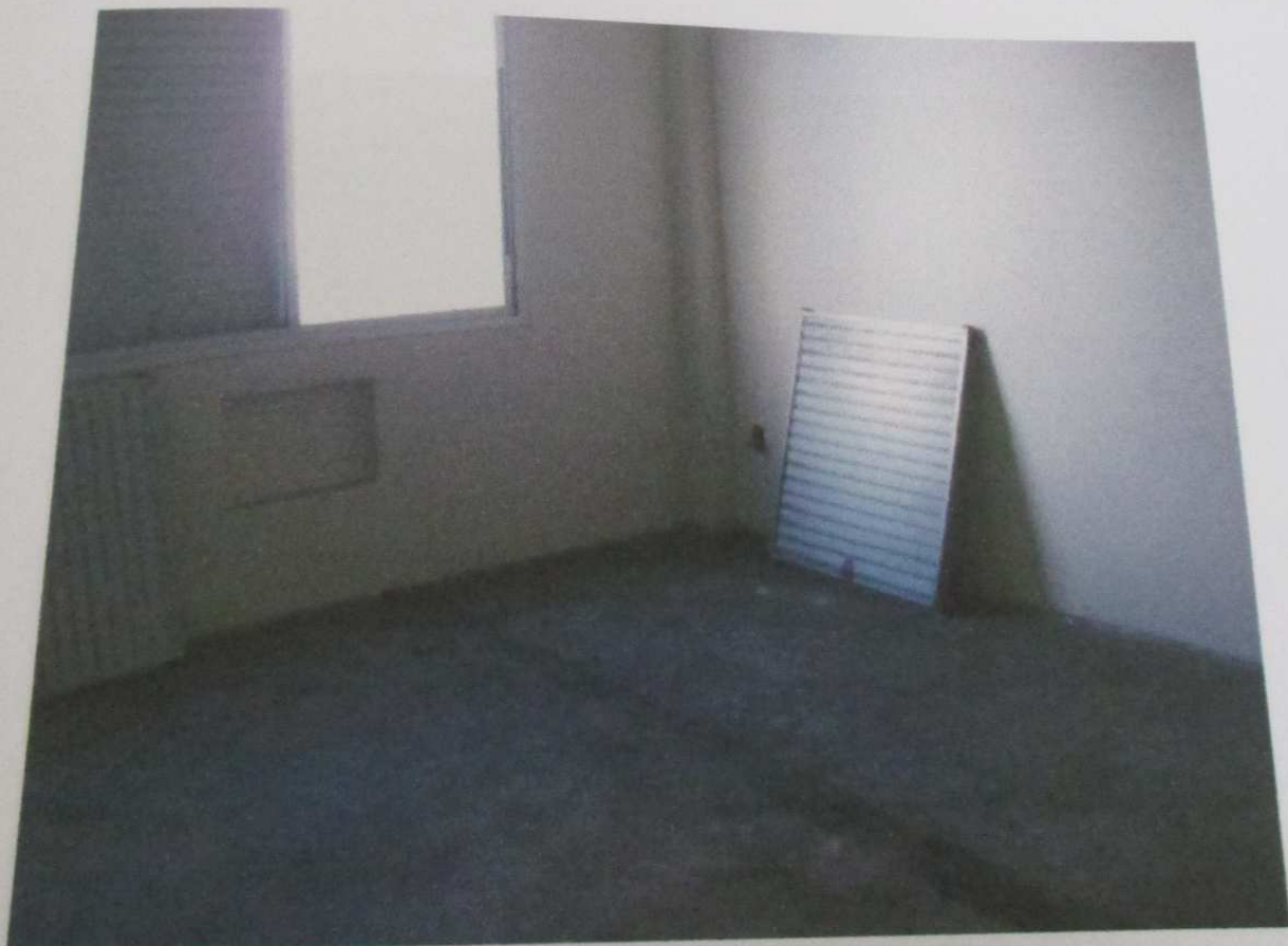
FOTO 70: Vista do dormitório do imóvel.
