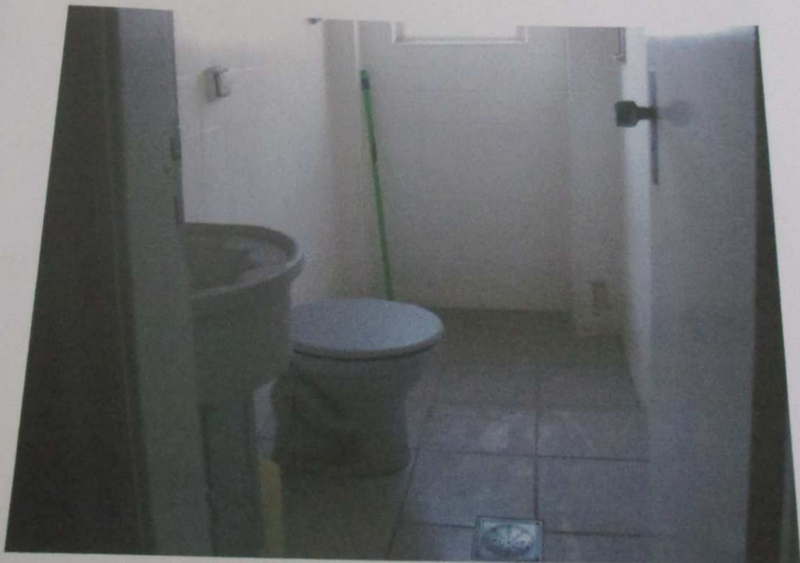
FOTO 191: Vista do banheiro do imóvel.
