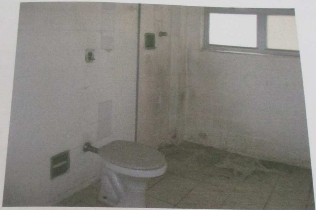
FOTO 21 : Vista do banheiro do imóvel.
