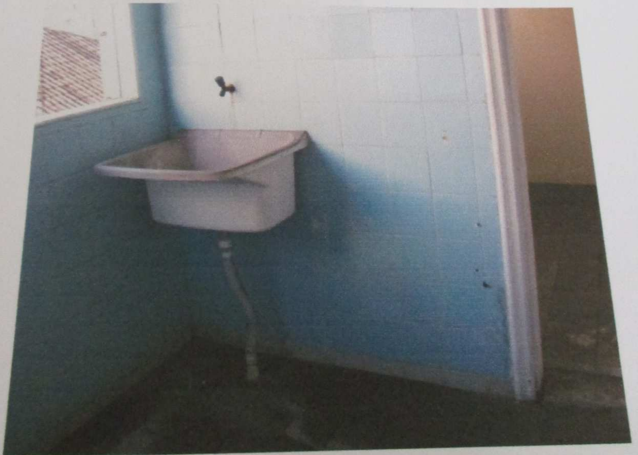
FOTO 51 : Vista da área de serviço do imóvel.
