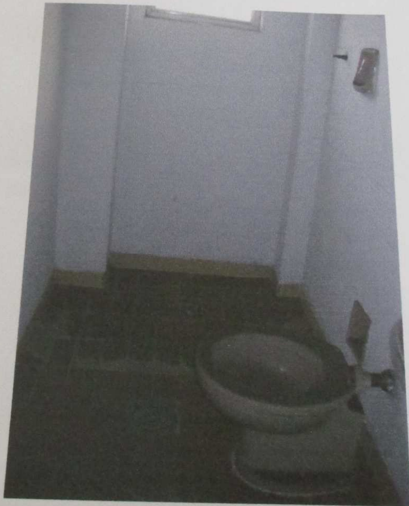
FOTO 34: Vista do banheiro do imóvel.
