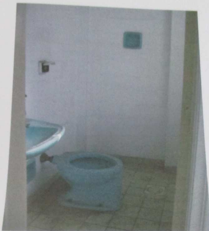
FOTO 114: Vista do banheiro do imóvel.
