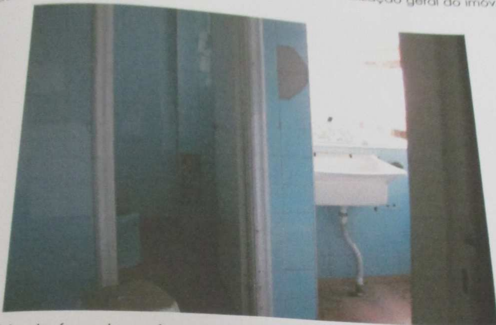
FOTO 75: Vista da área de serviço e banheiro de dependências da empregada.
