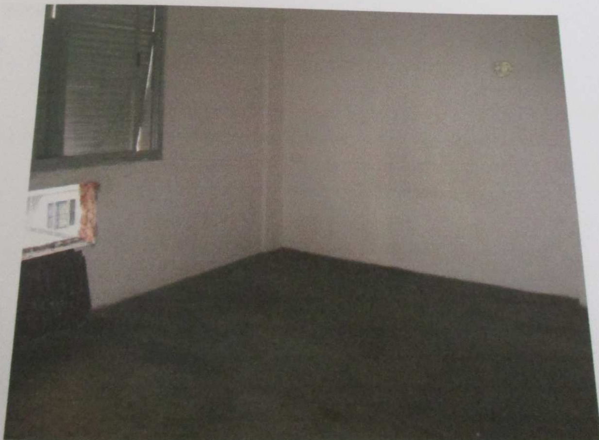
FOTO 57 : Vista do dormitório do imóvel.
