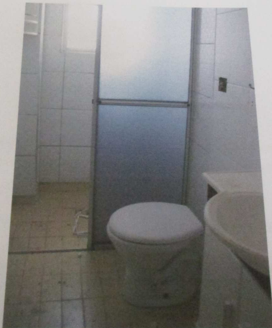
FOTO 183: Vista do banheiro do imóvel.
