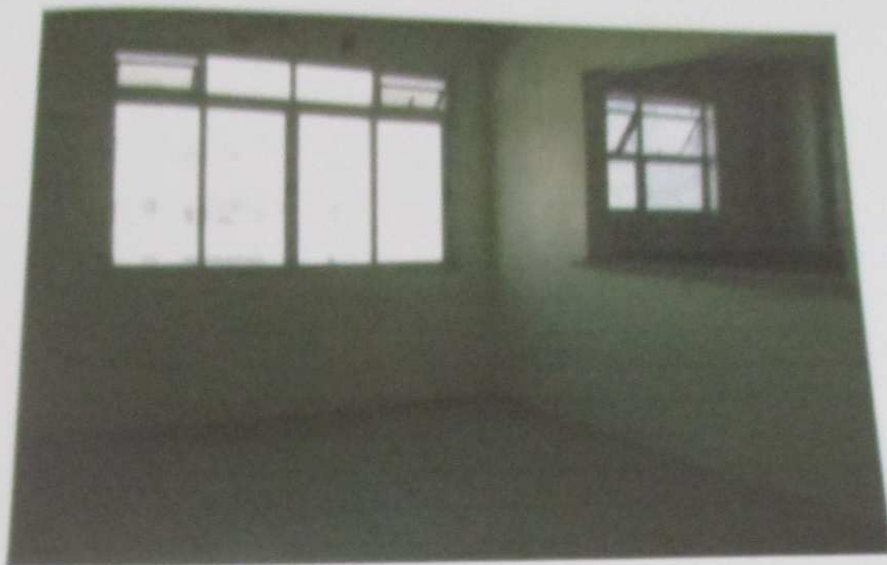
FOTO 130: Vista da sala do imóvel.
