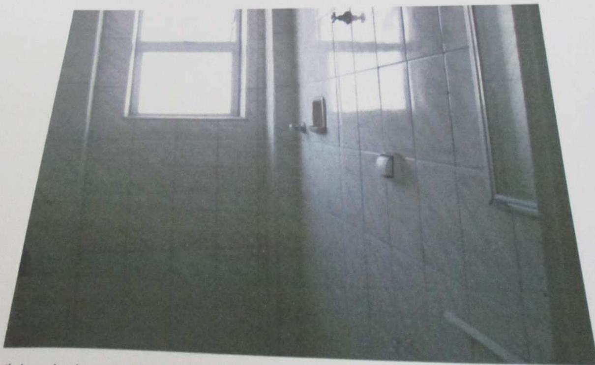
FOTO 133: Vista do banheiro do imóvel.
