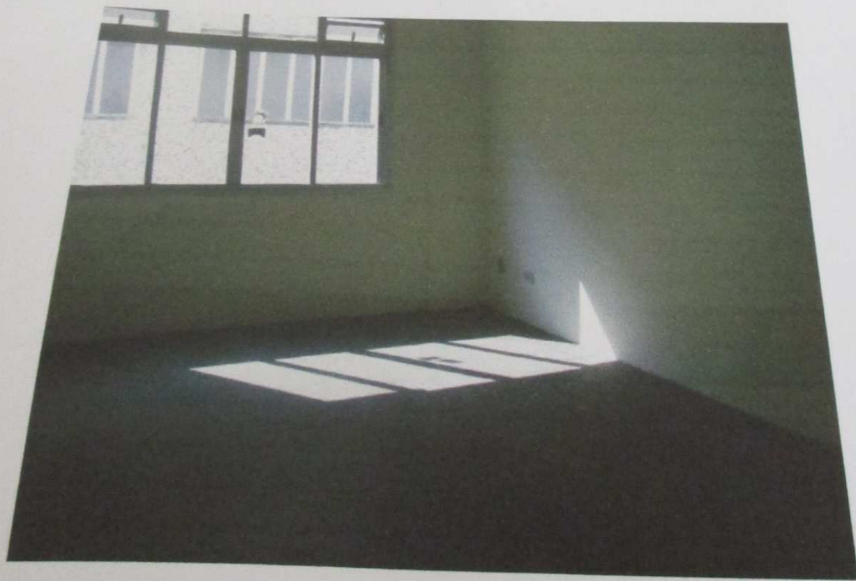
FOTO 115: Vista da sala do imóvel.
