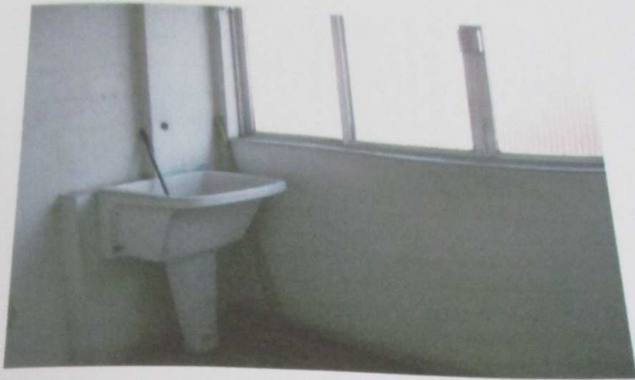
FOTO 44 : Vista da área de serviço do imóvel.
