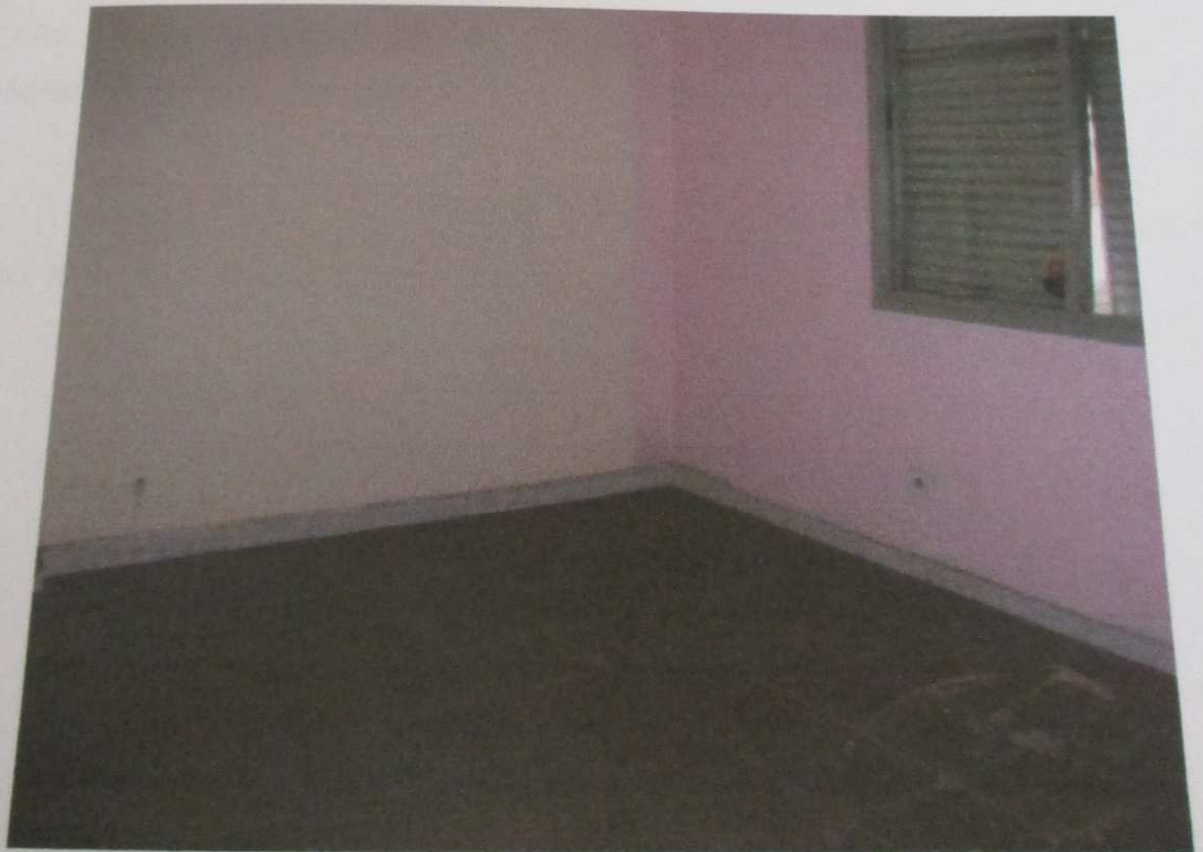
FOTO 41 : Vista do dormitório do imóvel.
