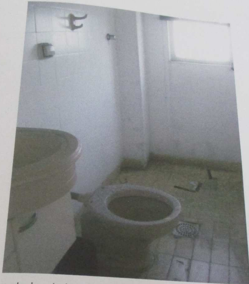
FOTO 89 : Vista do banheiro do imóvel.
