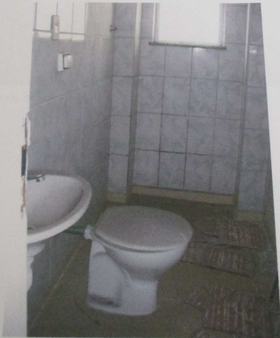
FOTO 162: Vista do banheiro do imóvel.
