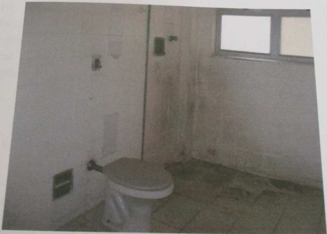
FOTO 11: Vista do banheiro do imóvel.
