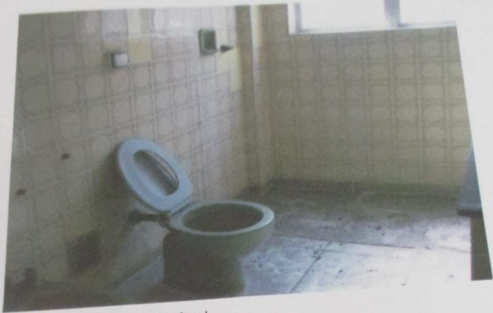
FOTO 140: Vista do banheiro do imóvel.
