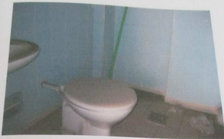
FOTO 52: Vista do banheiro do imóvel.
