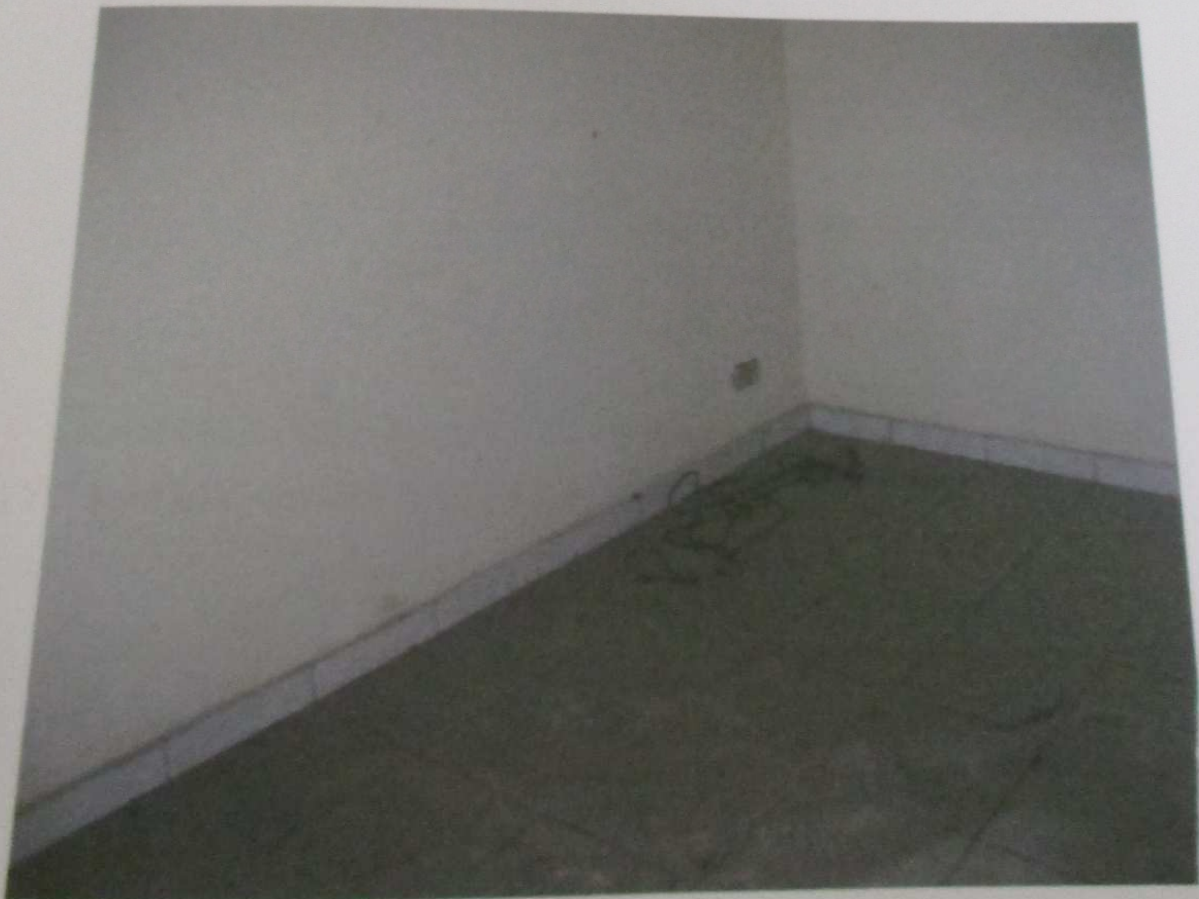
FOTO 59: Vista do dormitório do imóvel.
