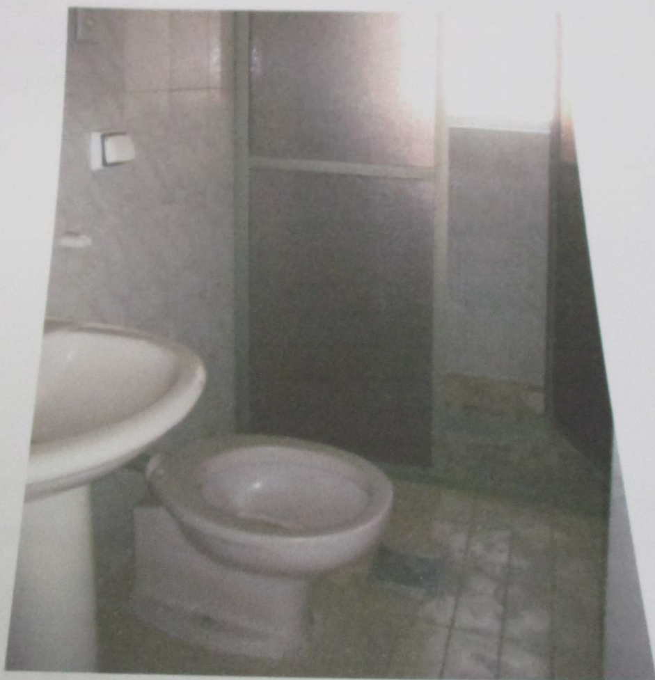
FOTO 127: Vista do banheiro do imóvel.
