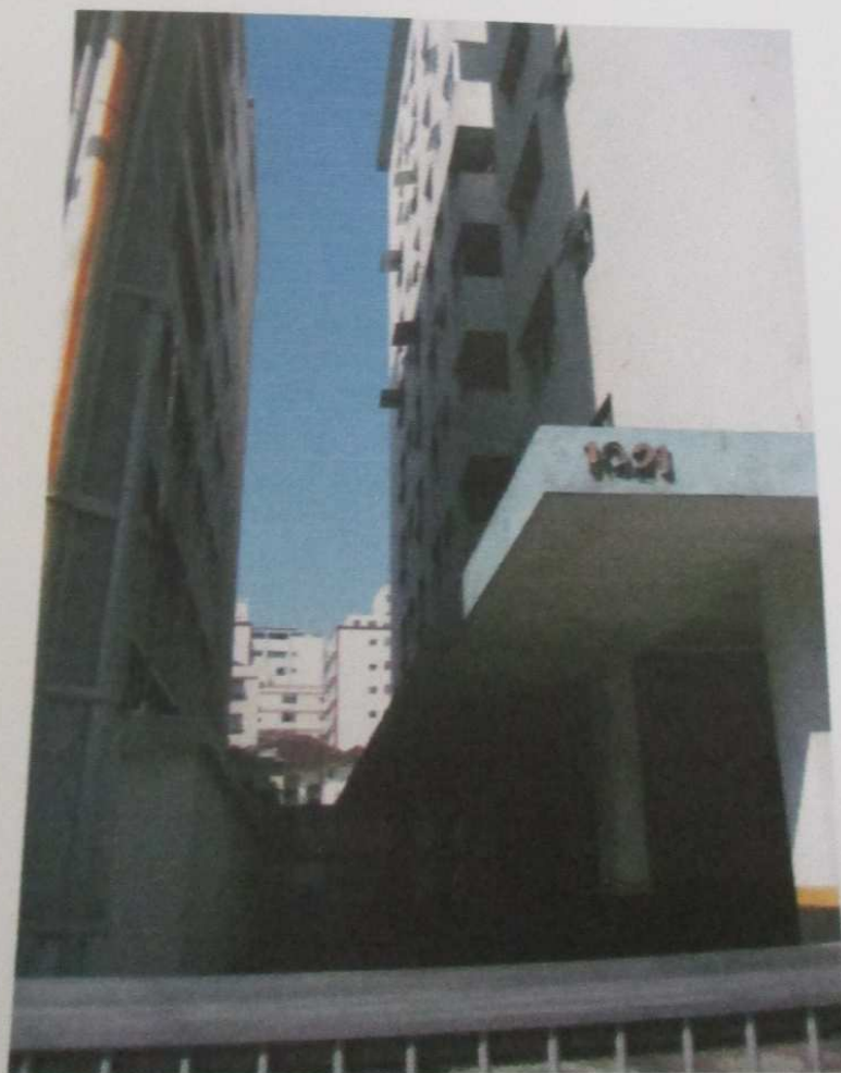
FOTO 4 : Outra vista da fachada do imóvel.
