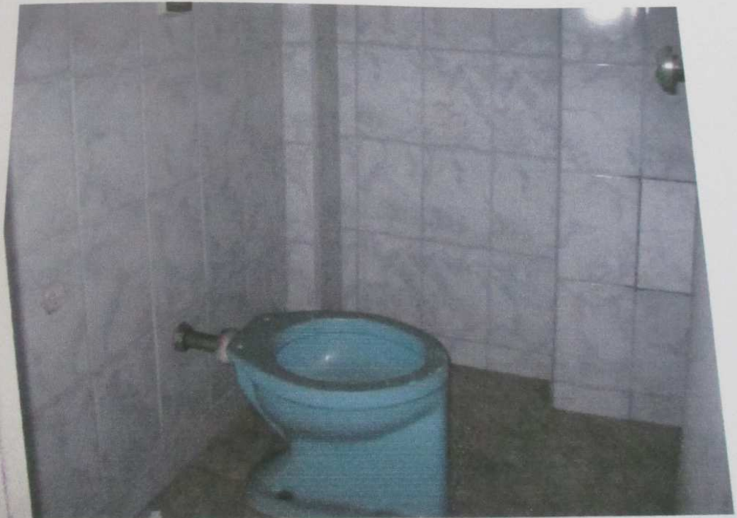
FOTO 16: Vista do banheiro do imóvel.
