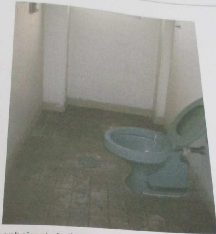
FOTO 73: Vista do banheiro do imóvel.
