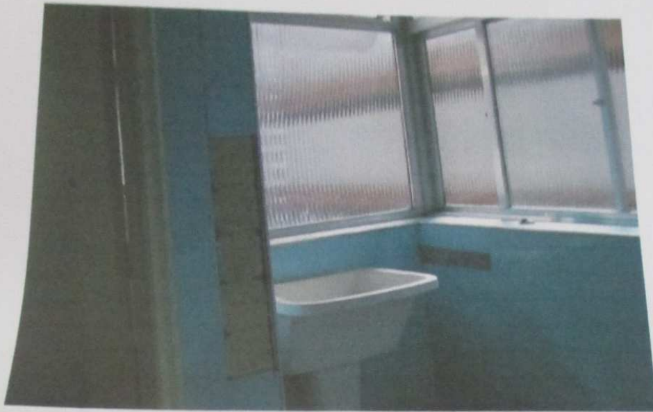
FOTO 112: Vista da área de serviço e banheiro de dependências da empregada.
