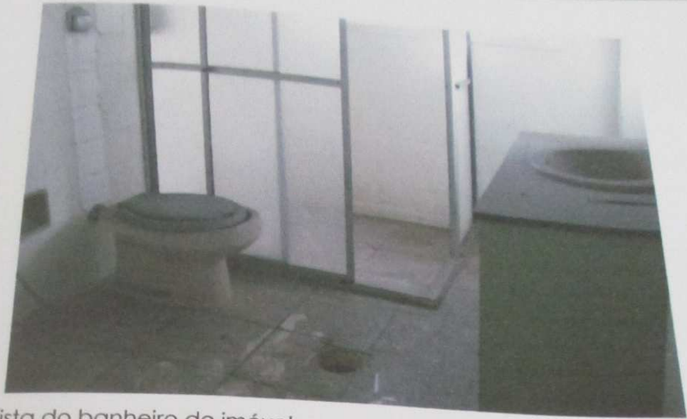
FOTO 46: Vista do banheiro do imóvel.
