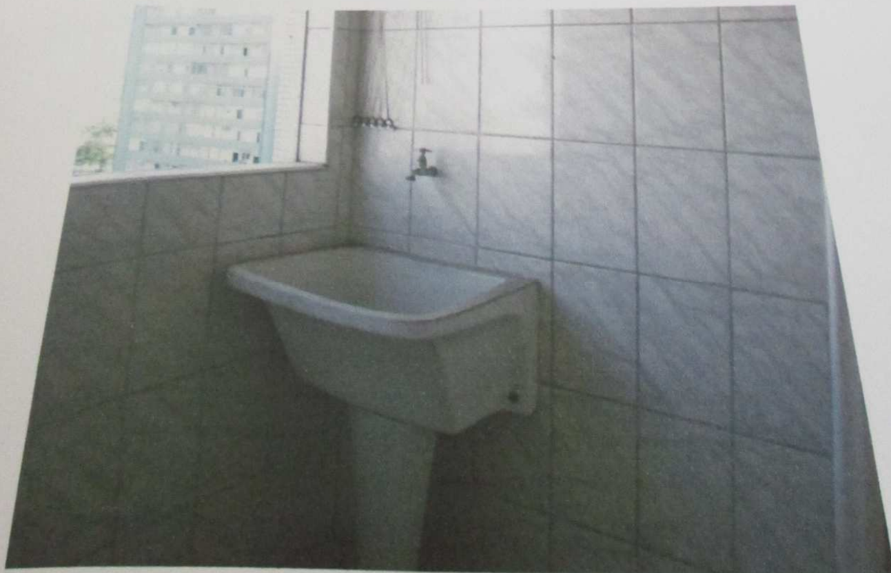
FOTO 129: Vista da área de serviço do imóvel.
