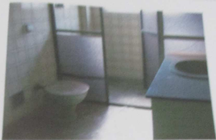
FOTO 123: Vista do banheiro do imóvel.
