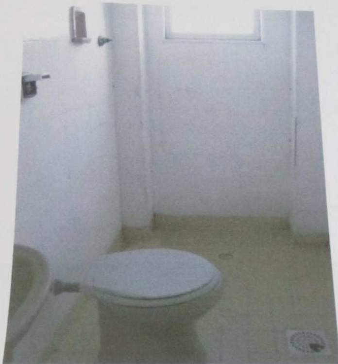
FOTO 118: Vista do banheiro do imóvel.
