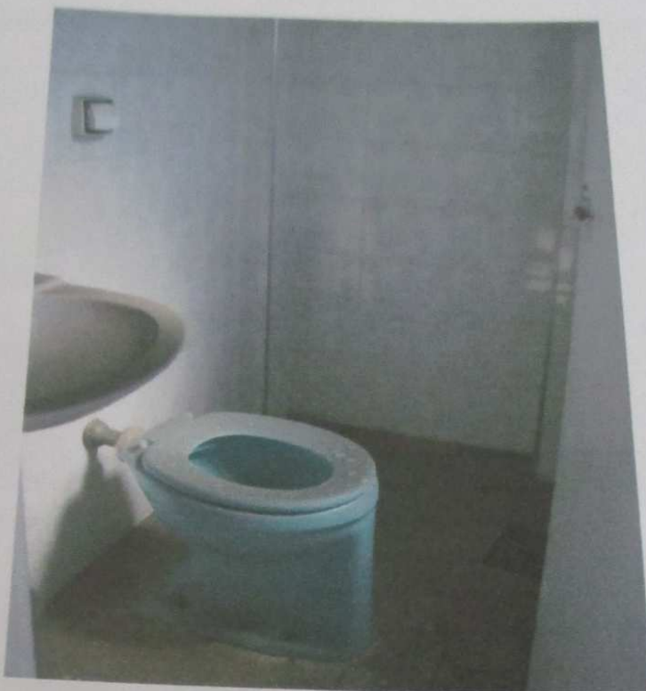
FOTO 186: Vista do banheiro do imóvel.
