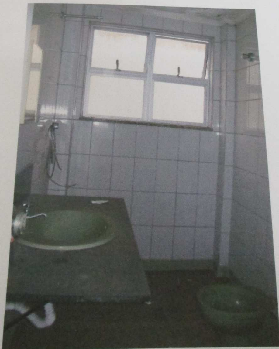
FOTO 63: Vista do banheiro do imóvel.
