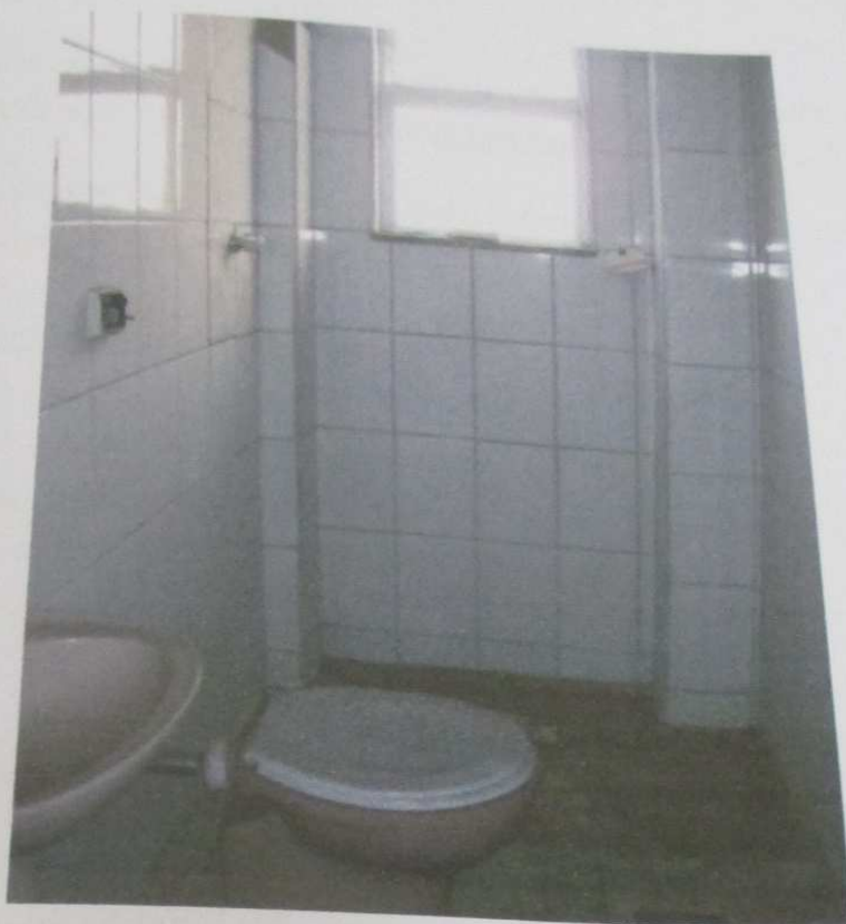
FOTO 64: Vista do banheiro do imóvel.
