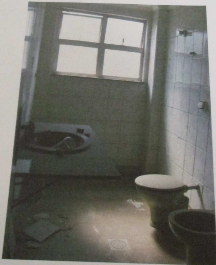
FOTO 160: Vista do banheiro do imóvel.
