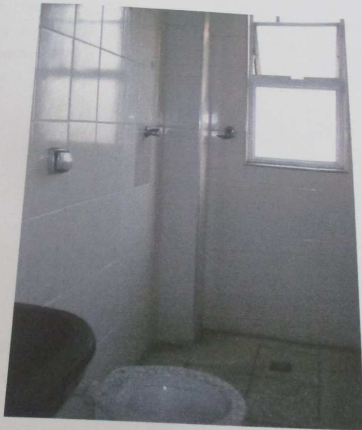
FOTO 28 : Vista do banheiro do imóvel.
