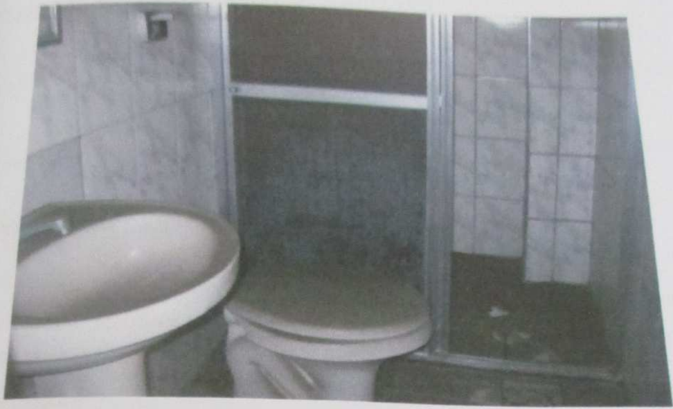
FOTO 40 : Vista do banheiro do imóvel.
