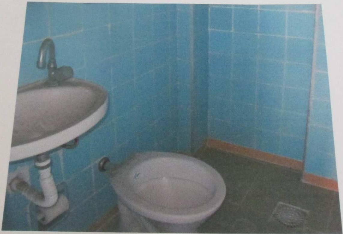
FOTO 149: Vista do banheiro do imóvel.
