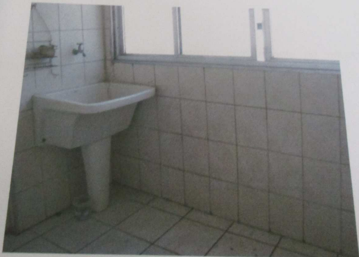
FOTO 173: Vista da área de serviço do imóvel.
