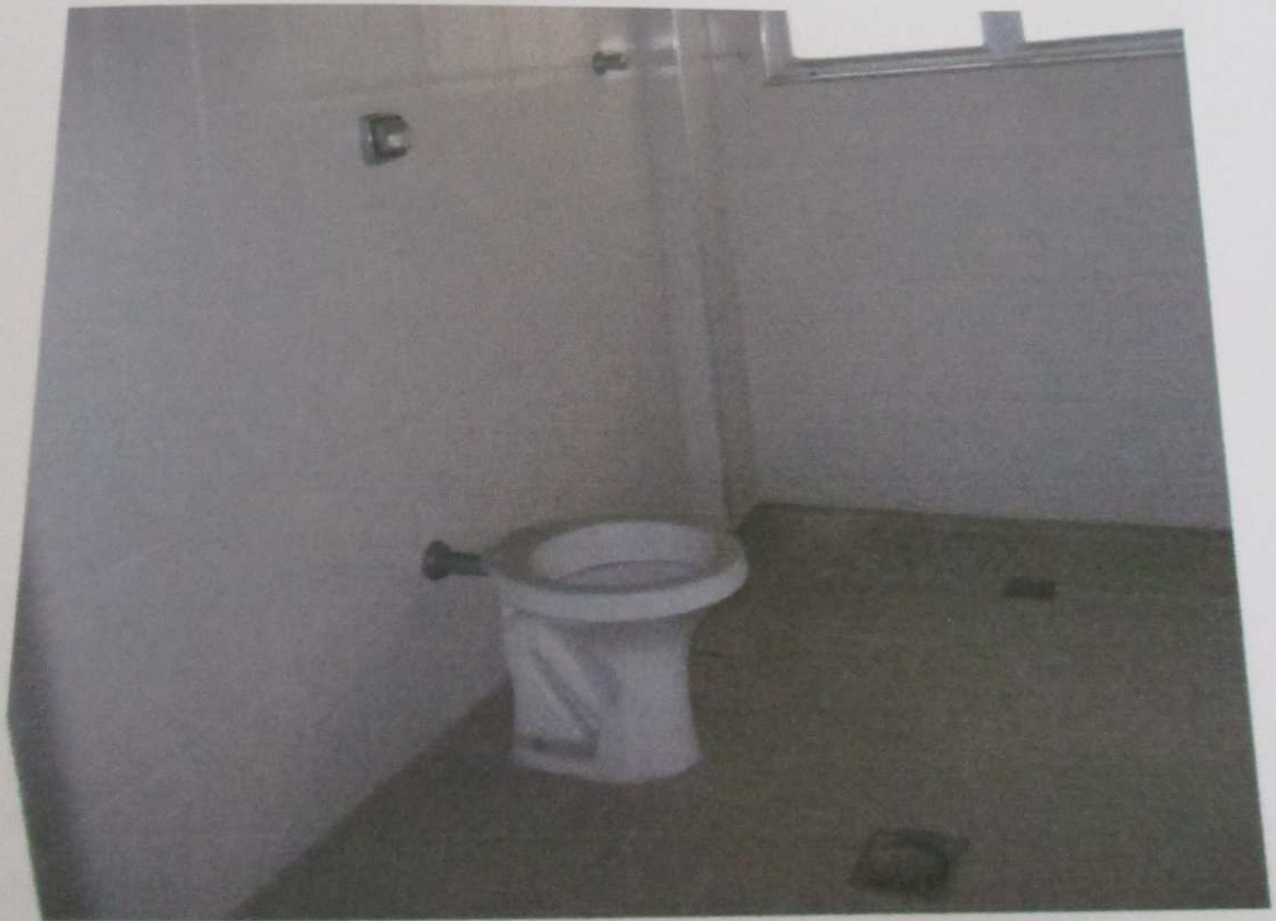
FOTO 25: Vista do banheiro do imóvel.
