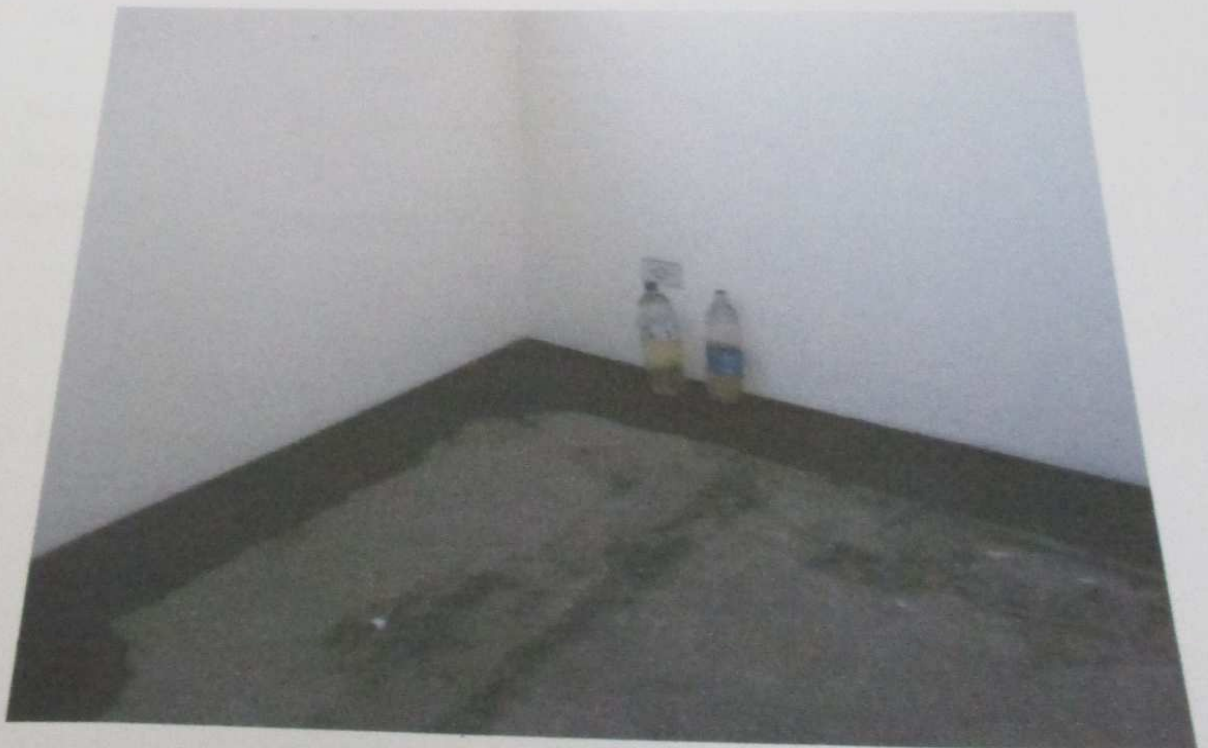
FOTO 135: Vista do dormitório do imóvel.
