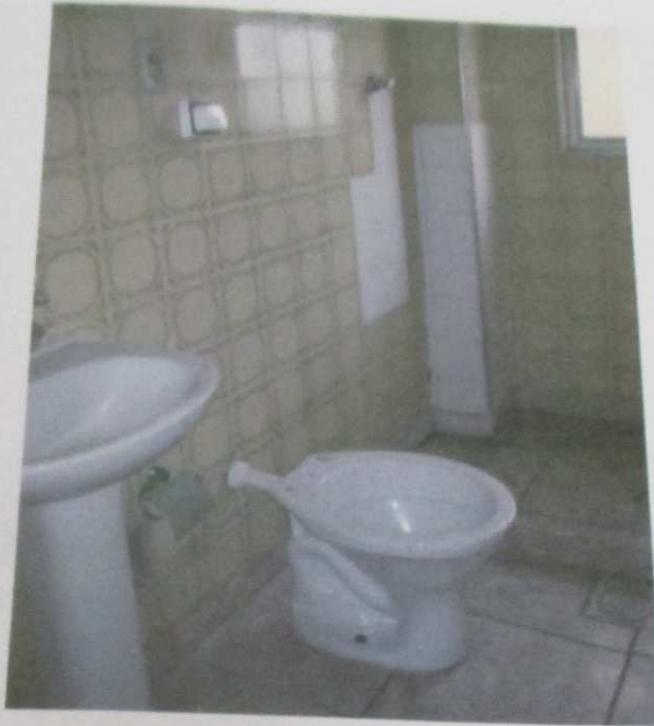
FOTO 8: Vista do banheiro do imóvel.
