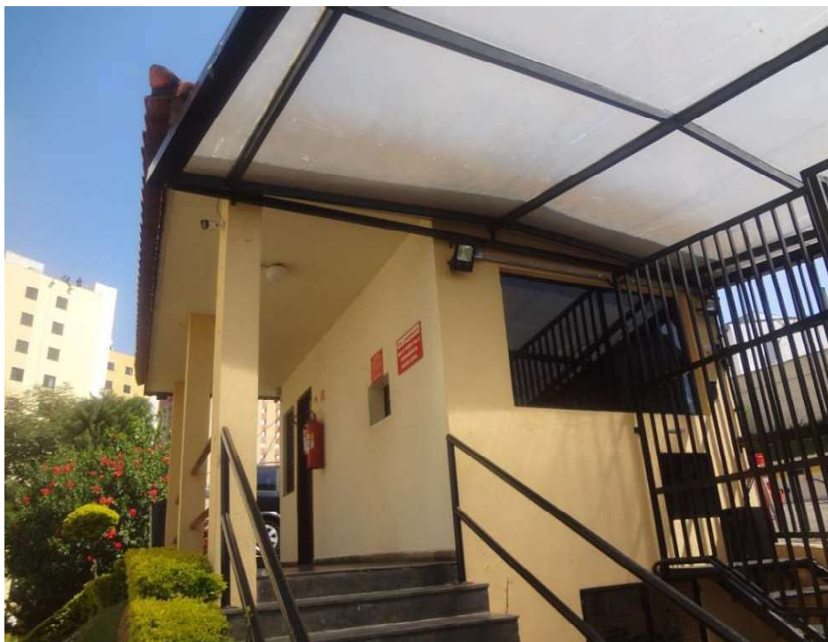
Foto 3 – Vista da Portaria
