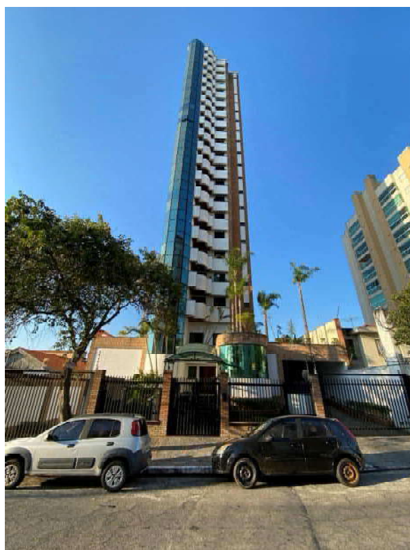
VISTA DA FACHADA DO EDIFÍCIO ONDE SE LOCALIZA A UNIDADE AVALIANDA.
