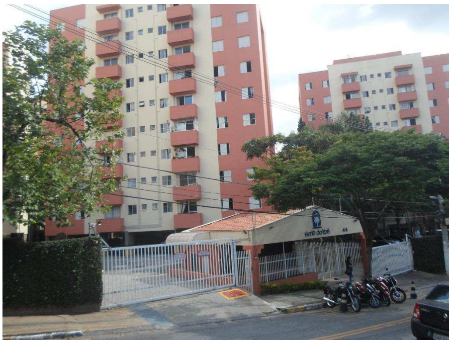
Aspectos externos dos blocos próximos à guarita de entrada do Condomínio.
