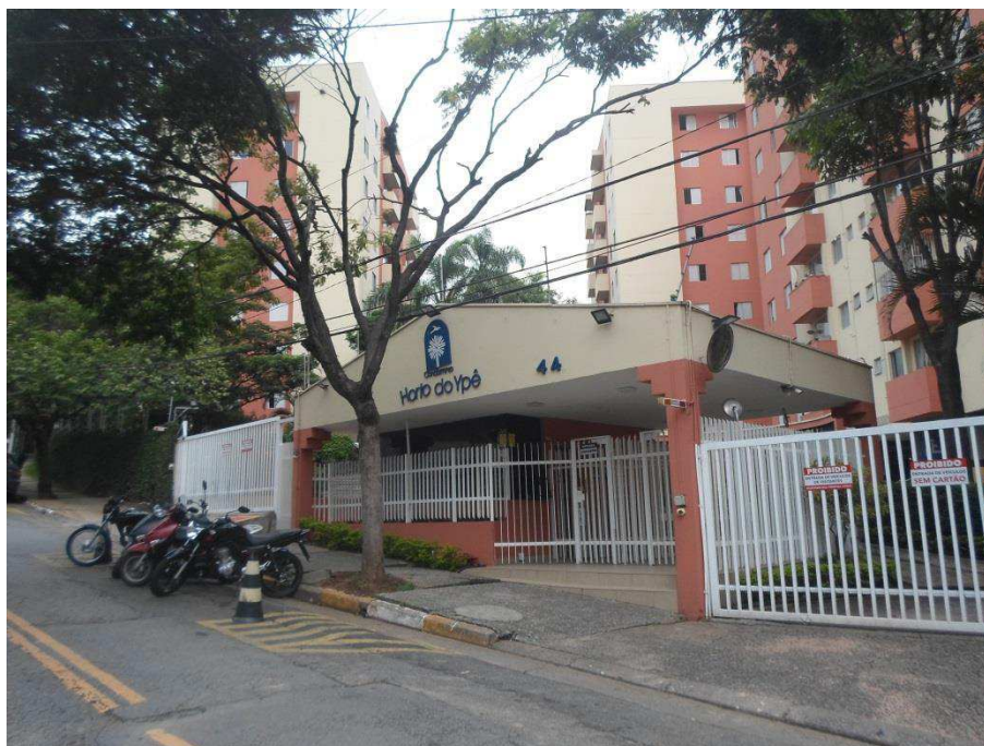
Entrada do Condomínio Horto do Ypê, à Rua Pedrina Maria da Silva Valente, 44.
