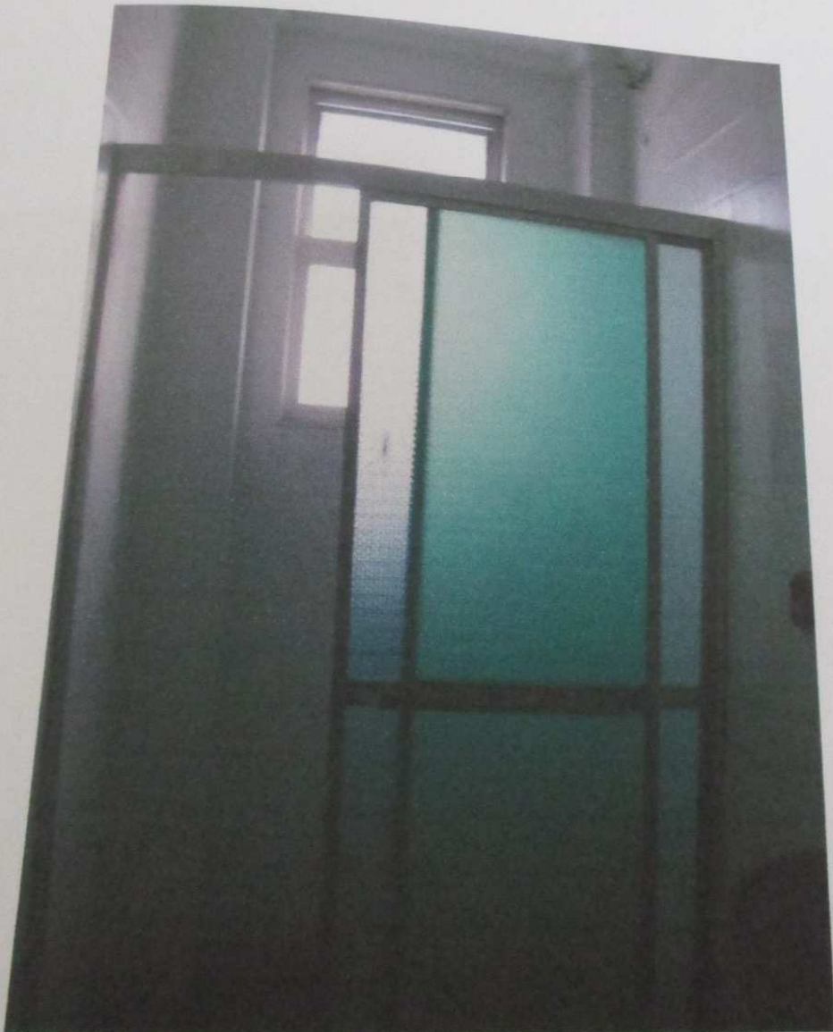
FOTO 95 : Vista do banheiro do imóvel.
