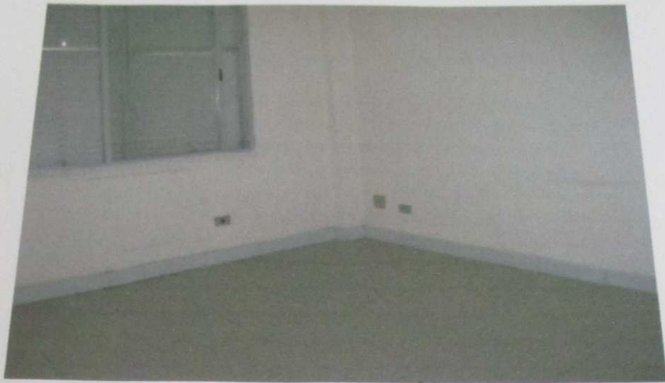
FOTO 152: Vista do dormitório do imóvel.
