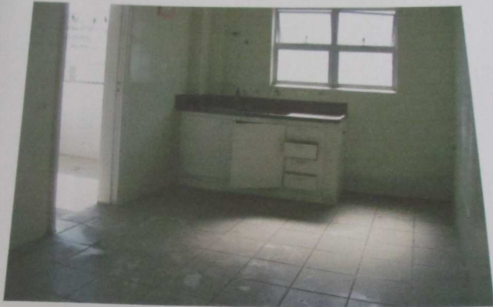
FOTO 184: Vista da cozinha do imóvel.
