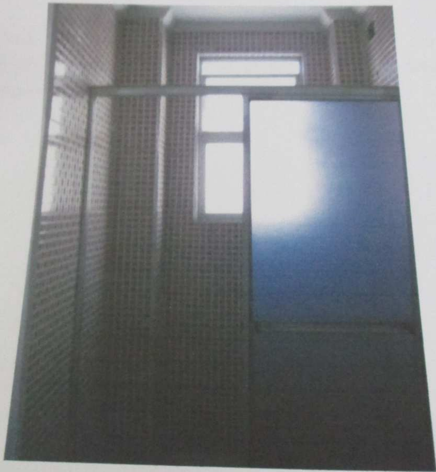
FOTO 111 : Vista do banheiro do imóvel.
