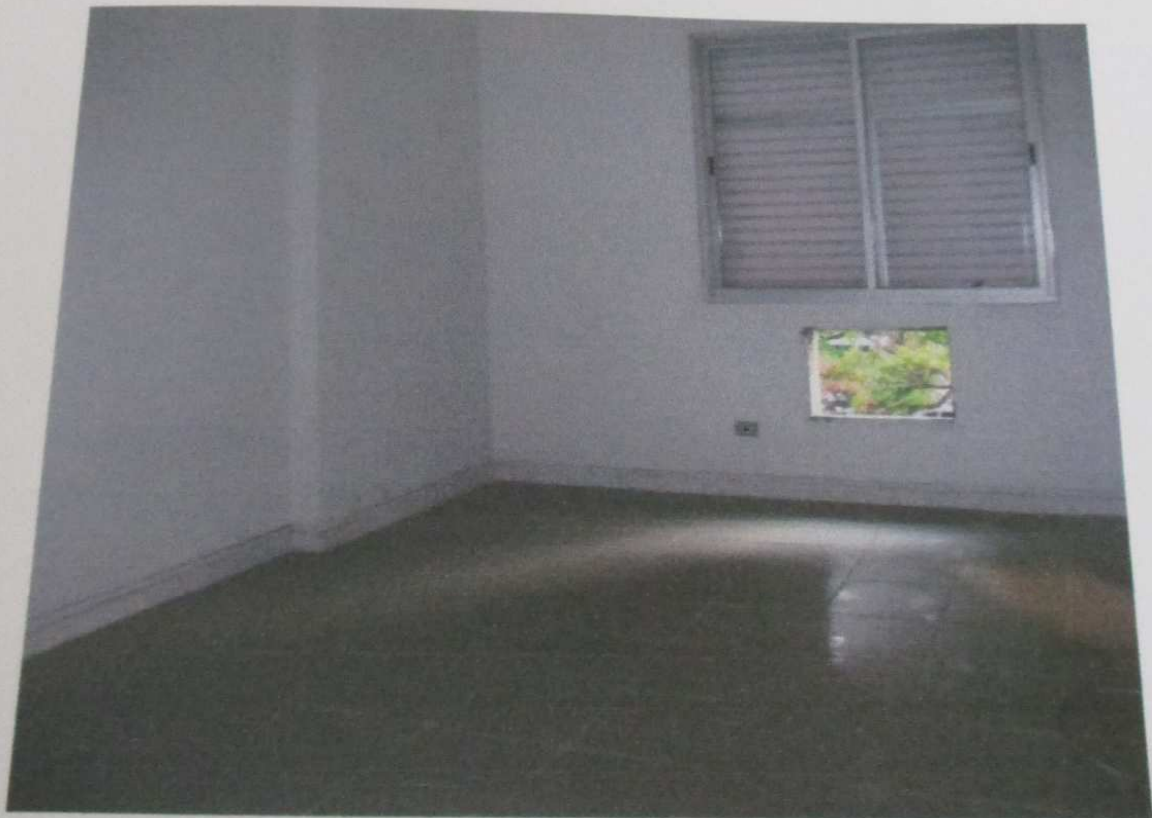
FOTO 27: Vista do dormitório do imóvel.
