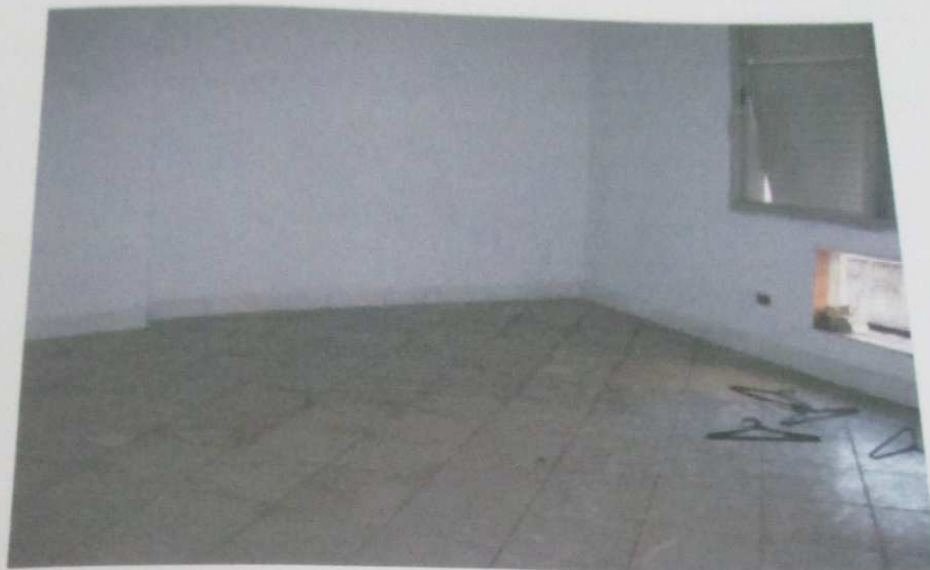
FOTO 19: Vista do dormitório do imóvel.
