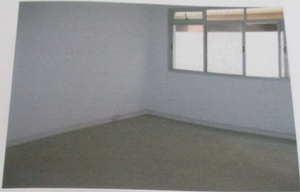
FOTO 22 : Vista da sala do imóvel.
