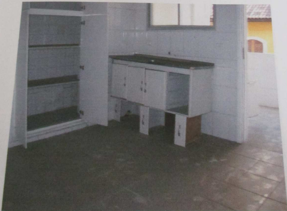
FOTO 23 : Vista da cozinha do imóvel.
