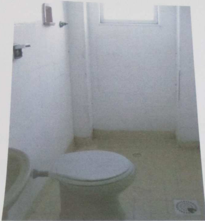
FOTO 118: Vista do banheiro do imóvel.
