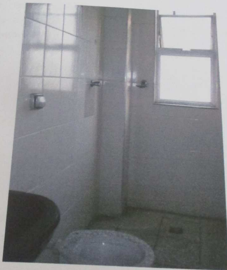
FOTO 28 : Vista do banheiro do imóvel.
