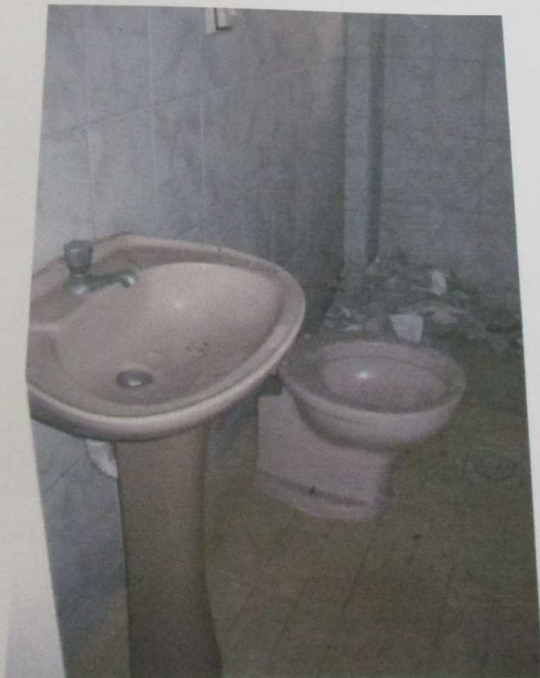
FOTO 18: Vista do banheiro do imóvel.
