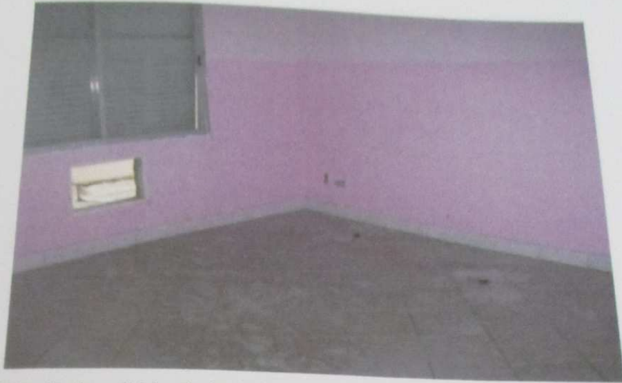
FOTO 17: Vista do dormitório do imóvel.
