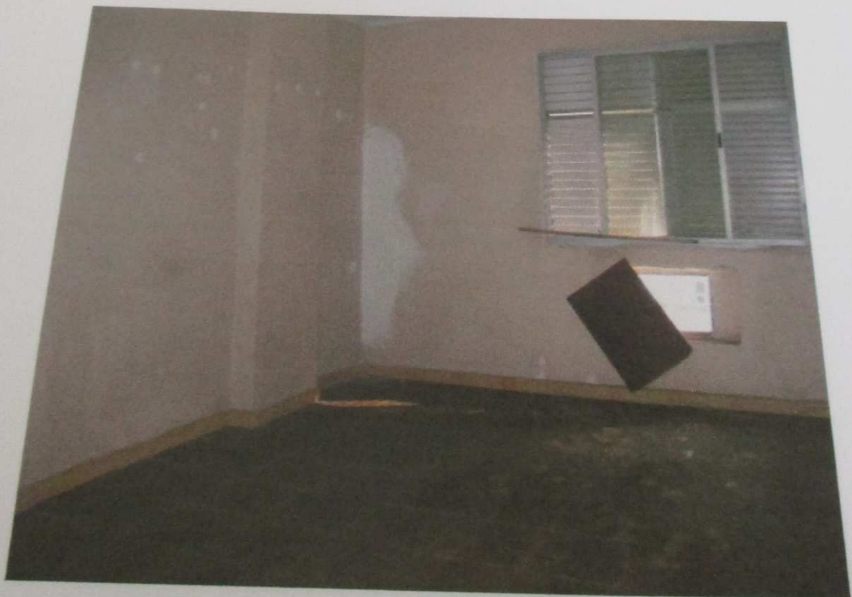
FOTO 100: Vista do dormitório do imóvel.
