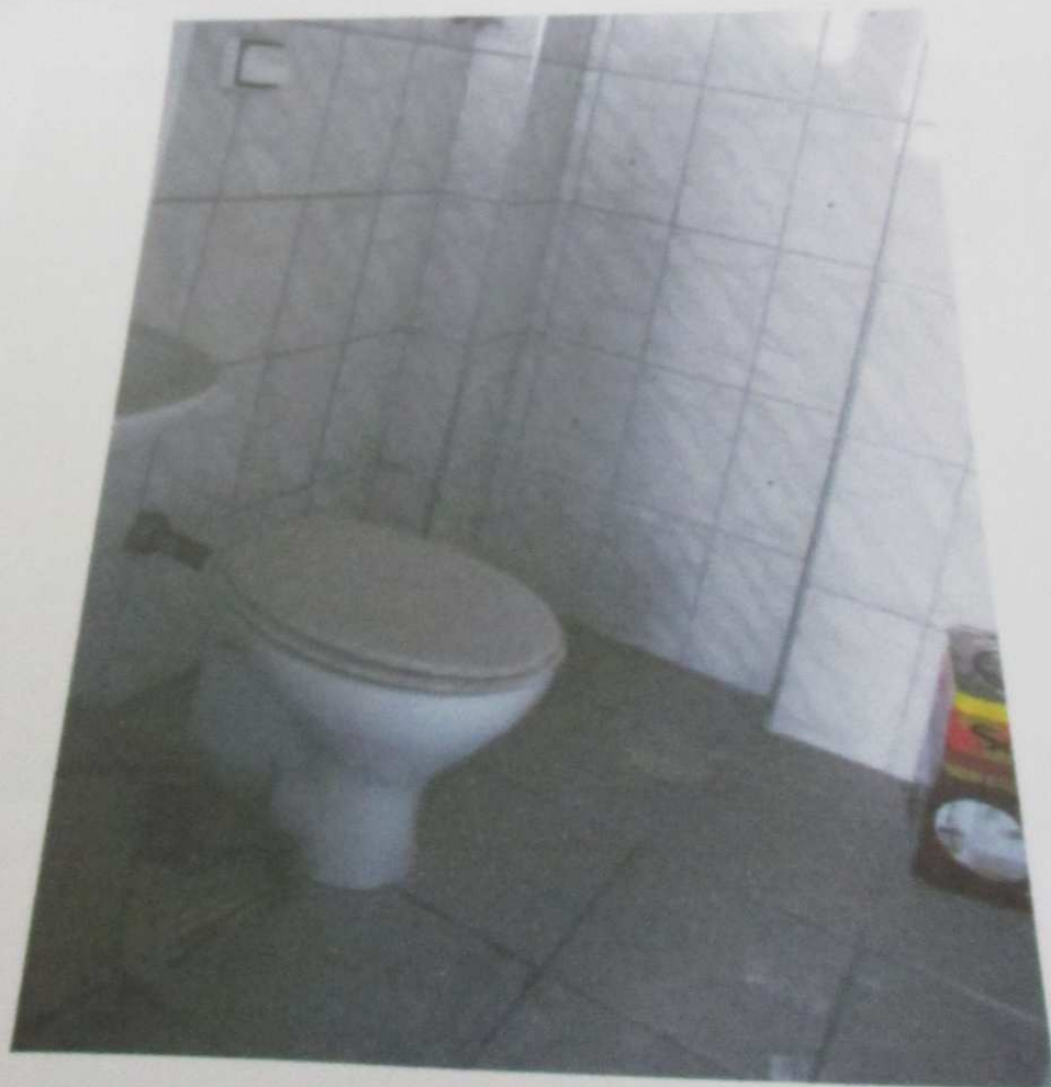
FOTO 131: Vista do banheiro do imóvel.
