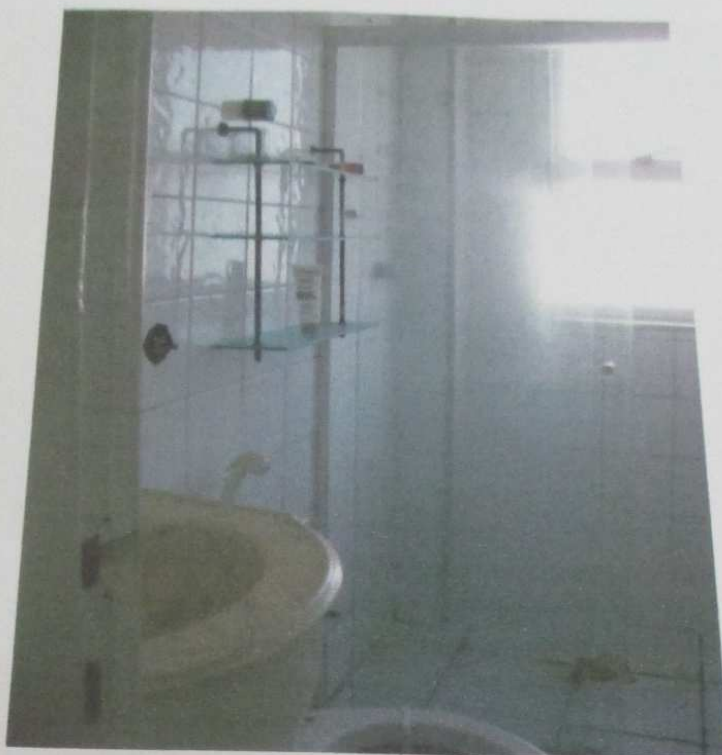
FOTO 166: Vista do banheiro do imóvel.
