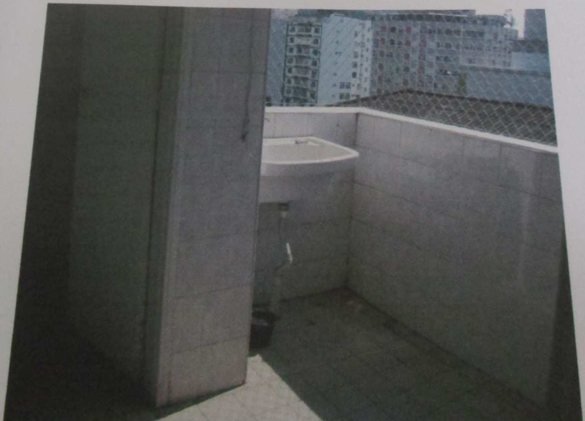
FOTO 185: Vista da área de serviço e banheiro de dependências da empregada.
