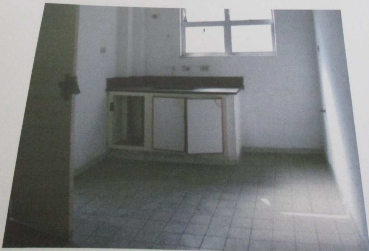
FOTO 113: Vista da cozinha do imóvel.
