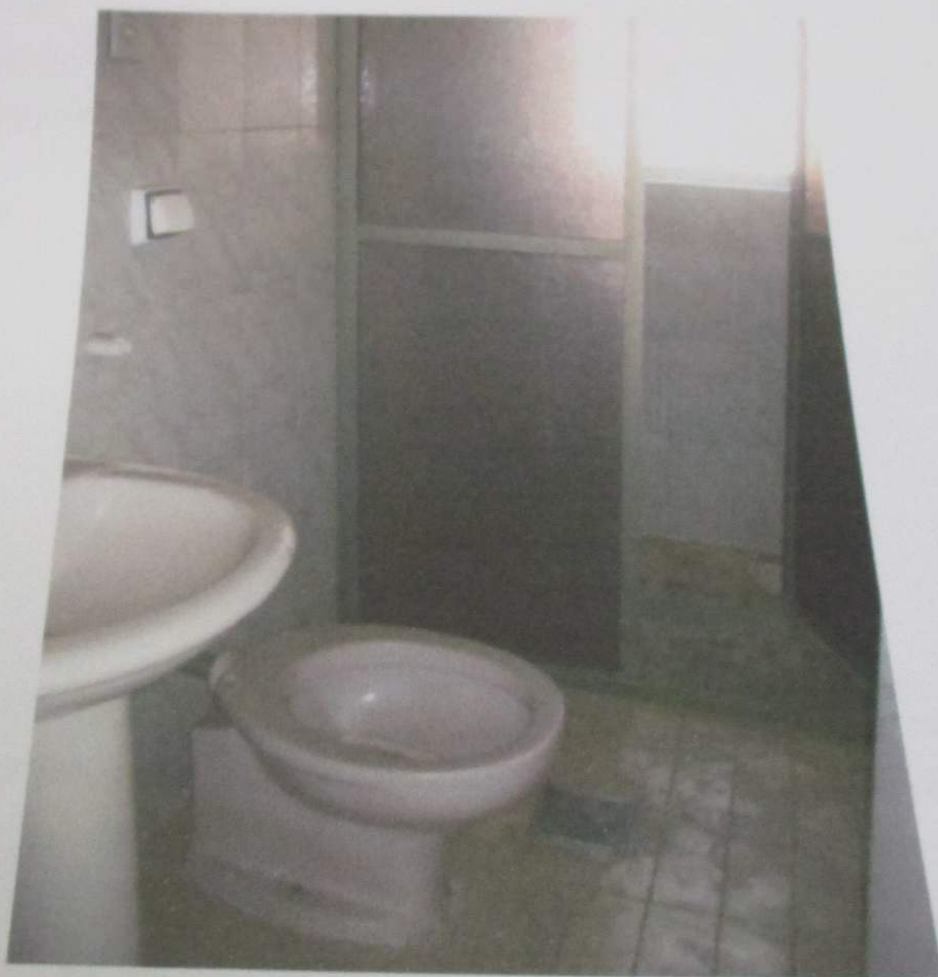
FOTO 127: Vista do banheiro do imóvel.
