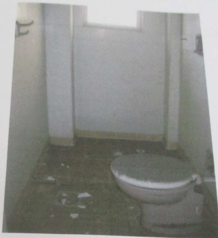
FOTO 56 : Vista do banheiro do imóvel.
