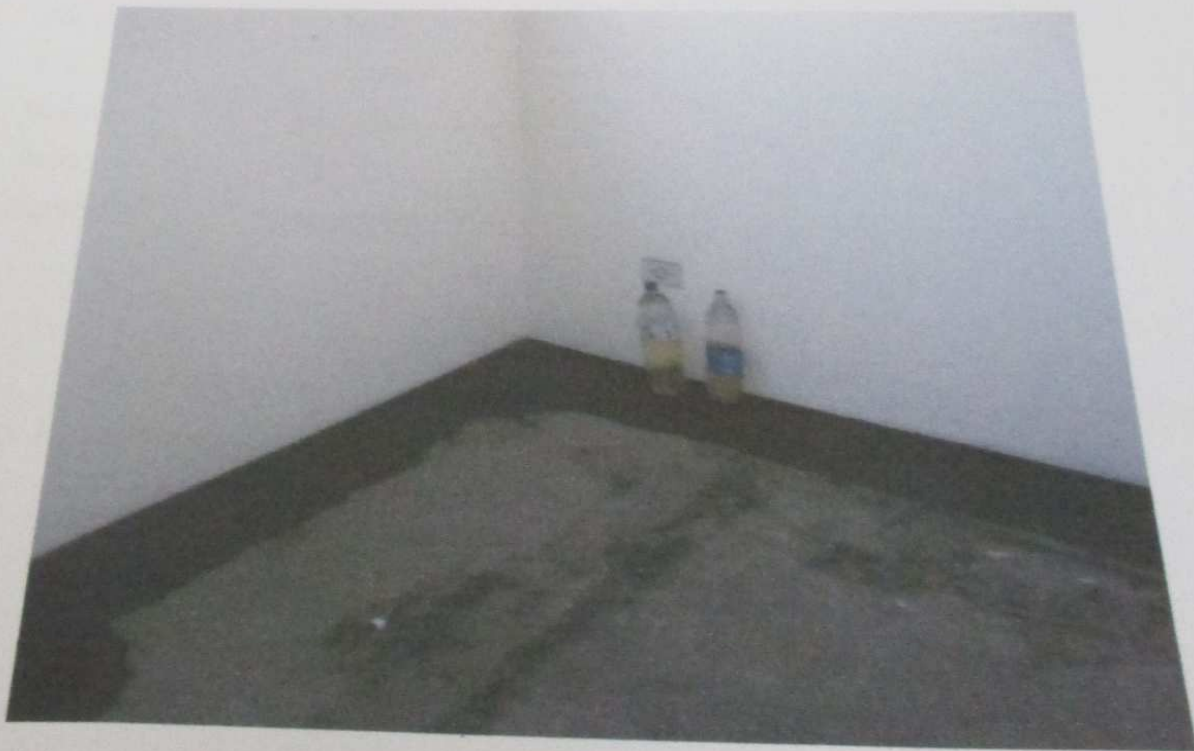
FOTO 135: Vista do dormitório do imóvel.
