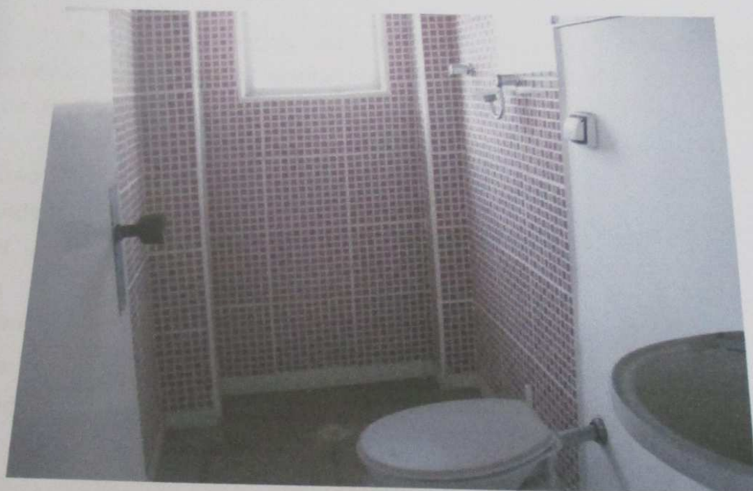
FOTO 154: Vista do banheiro do imóvel.
