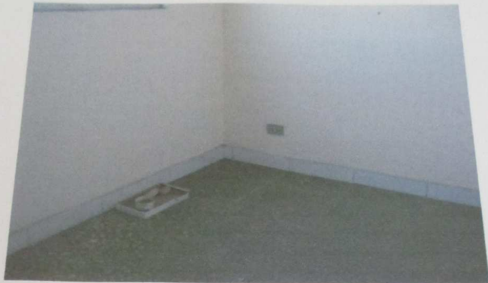
FOTO 148: Vista do dormitório do imóvel.
