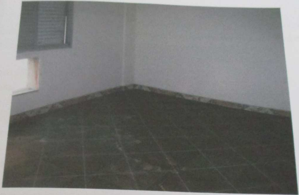
FOTO 35: Vista do dormitório do imóvel.
