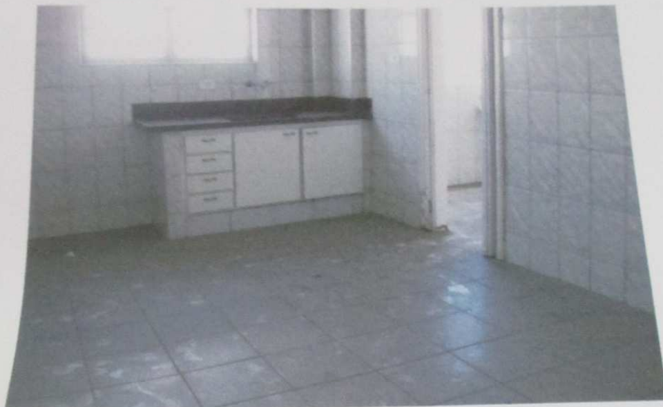
FOTO 128: Vista da cozinha do imóvel.
