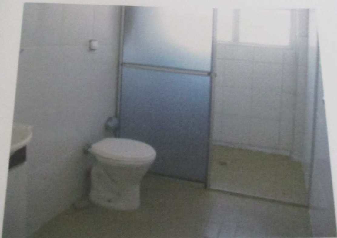
FOTO 179: Vista do banheiro do imóvel.
