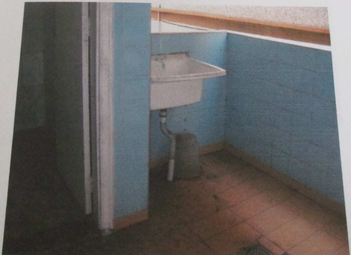
FOTO 14: Vista da área de serviço do imóvel.
