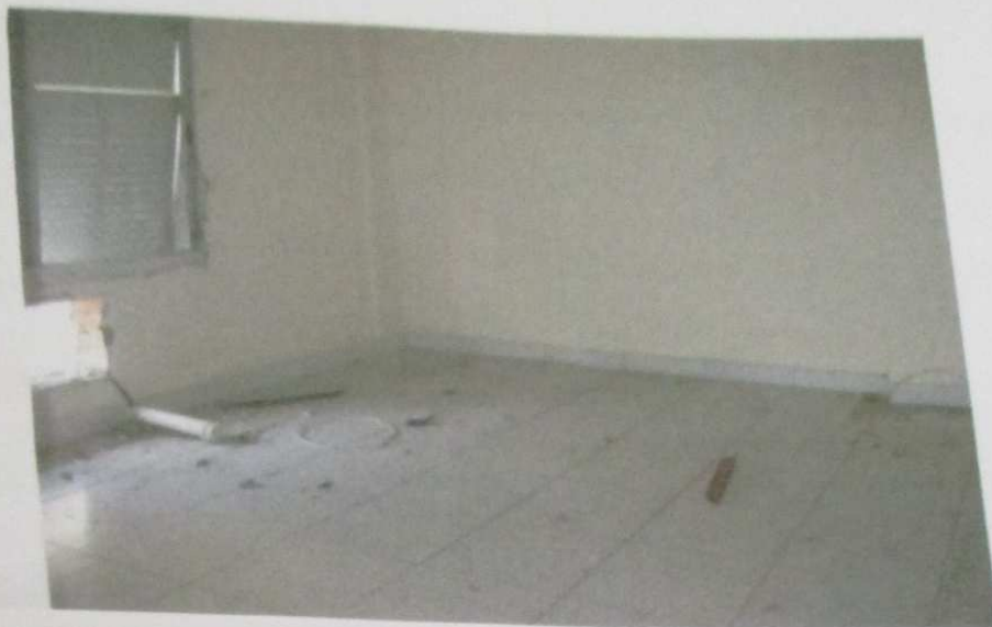
FOTO 182: Vista do dormitório do imóvel.
