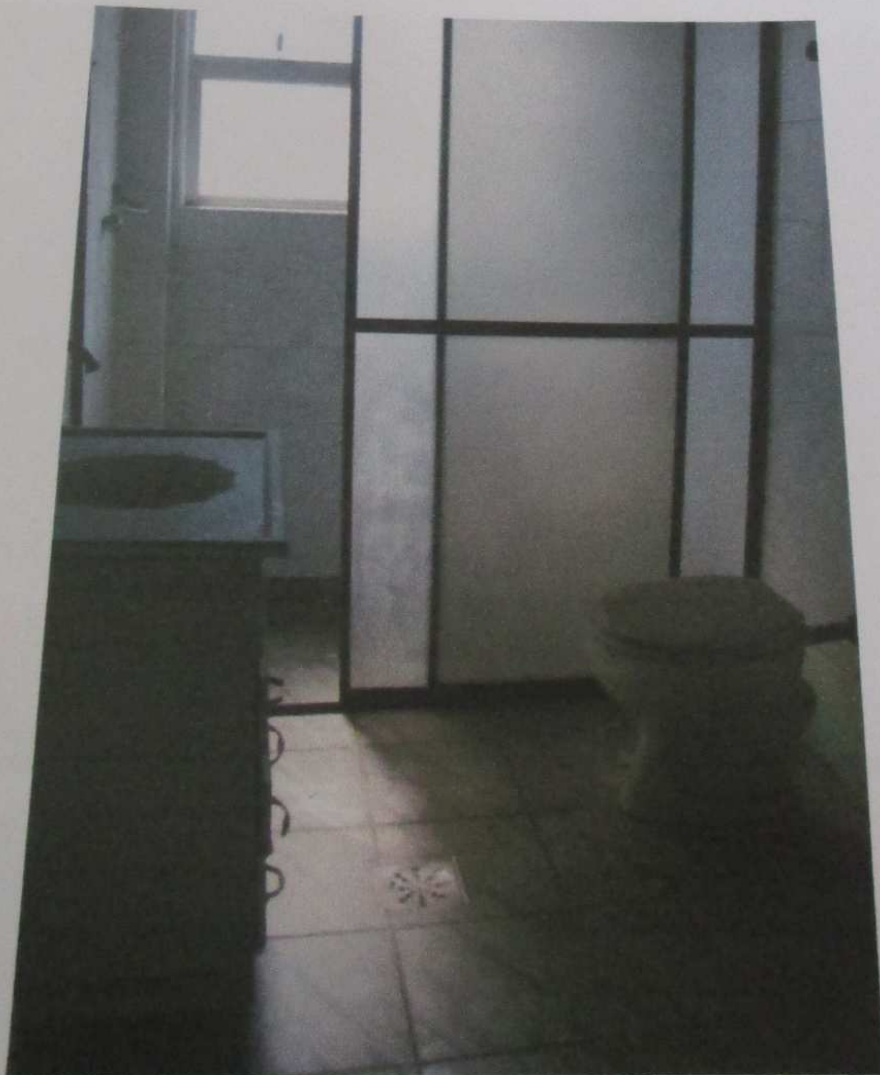
FOTO 189: Vista do banheiro do imóvel.
