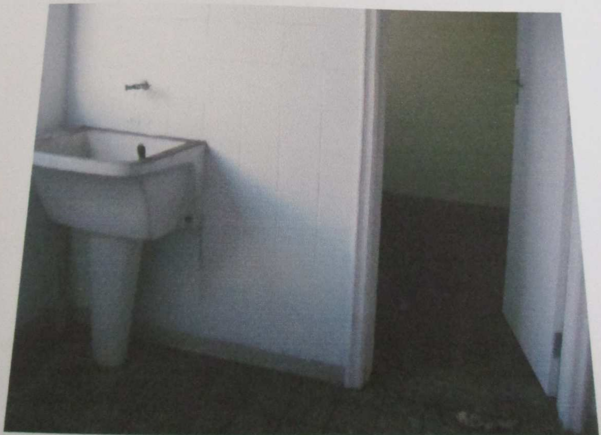
FOTO 30 : Vista da área de serviço do imóvel.
