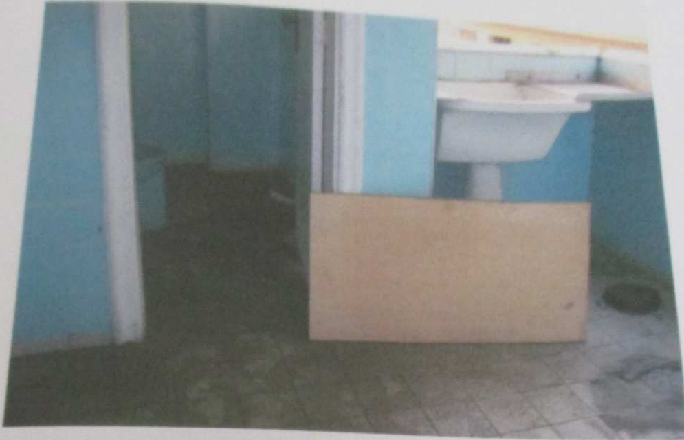
FOTO 58: Vista da área de serviço e banheiro de dependências da empregada.
