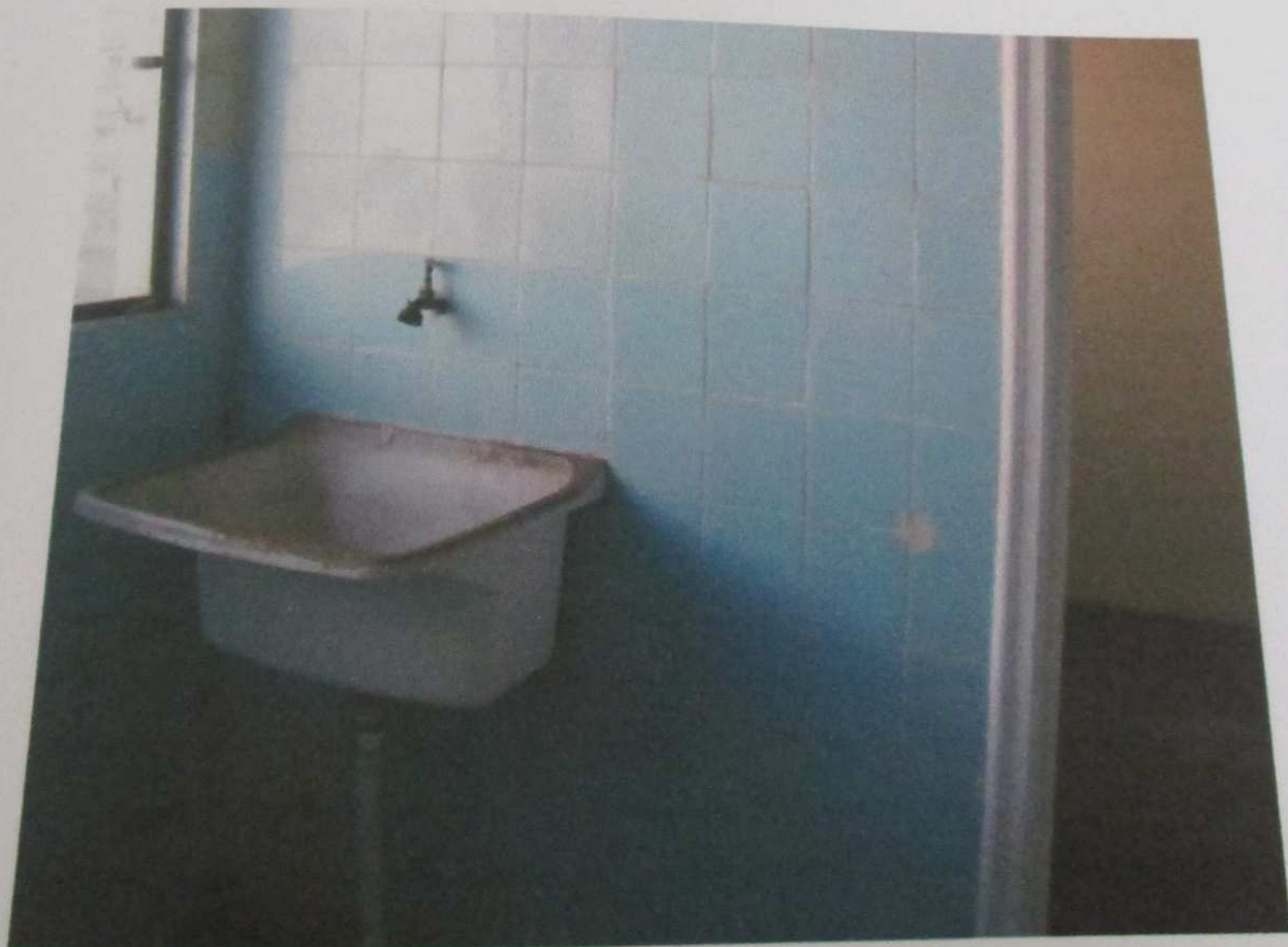
FOTO 68: Vista da área de serviço do imóvel.
