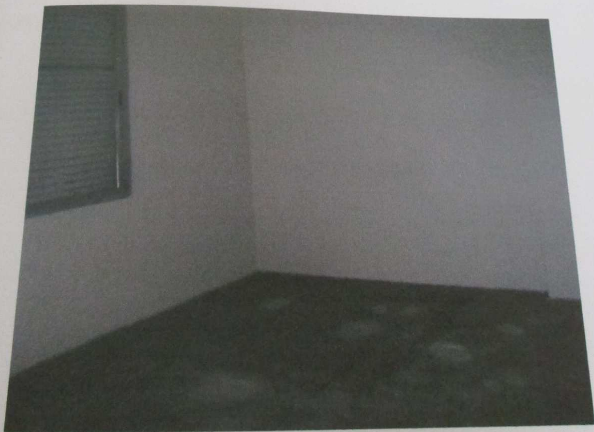
FOTO 74: Vista do dormitório do imóvel.
