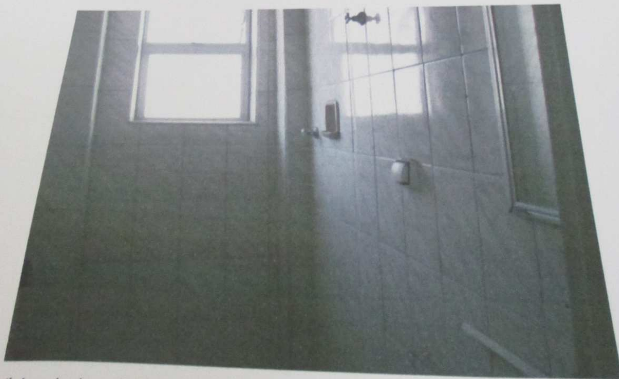
FOTO 133: Vista do banheiro do imóvel.
