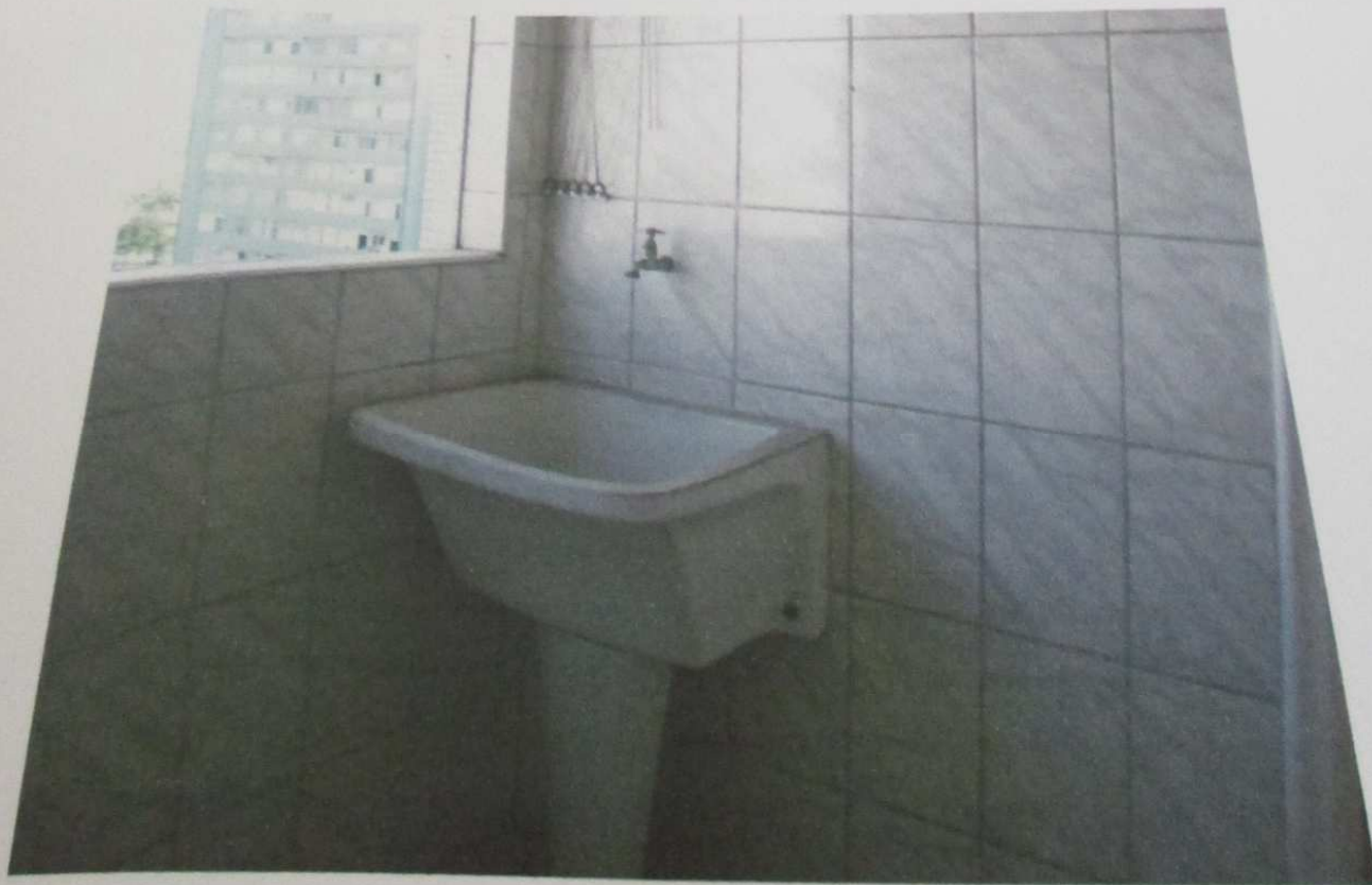
FOTO 129: Vista da área de serviço do imóvel.
