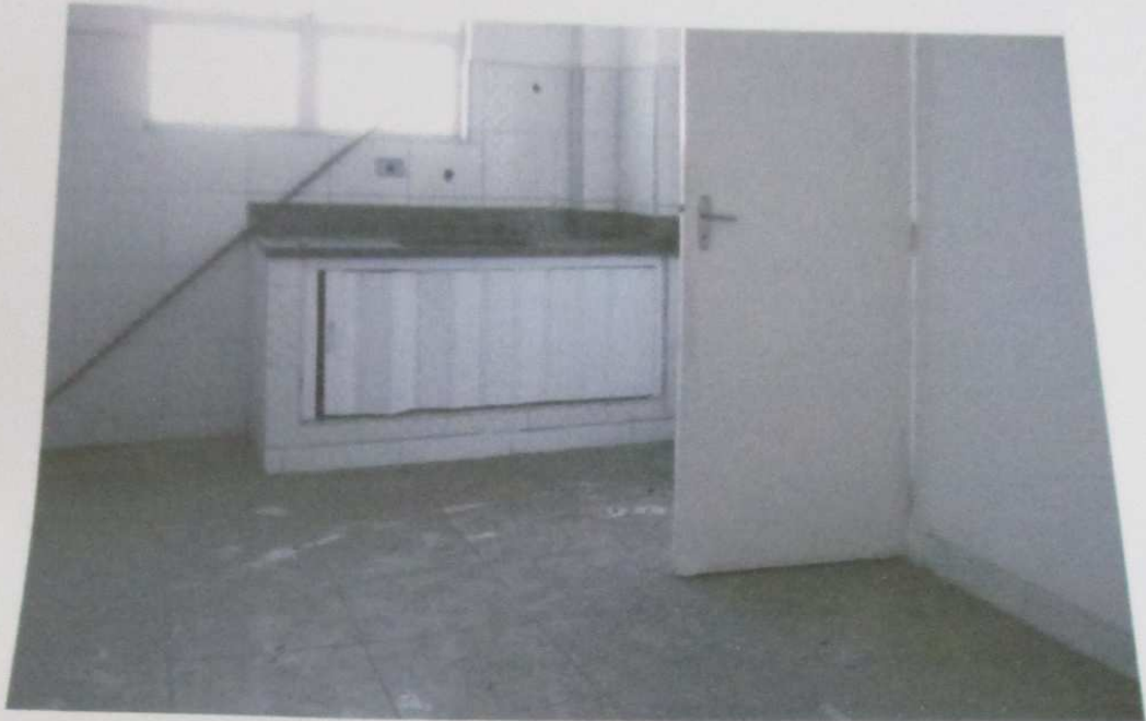
FOTO 103: Vista da cozinha do imóvel.
