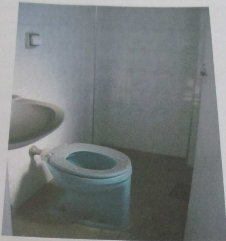
FOTO 186: Vista do banheiro do imóvel.
