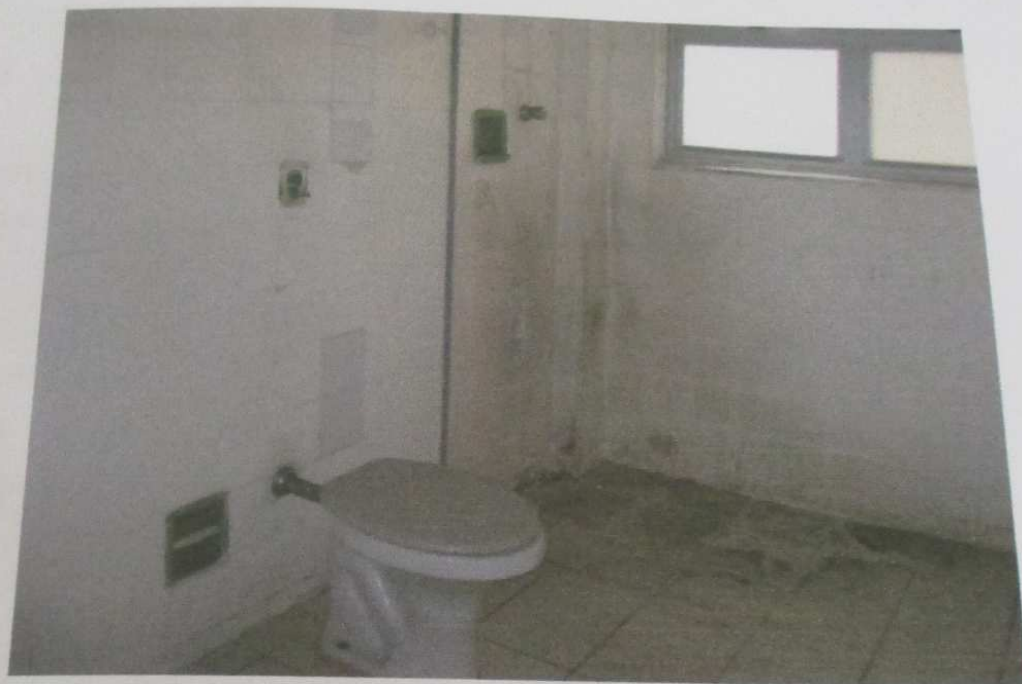
FOTO 21 : Vista do banheiro do imóvel.
