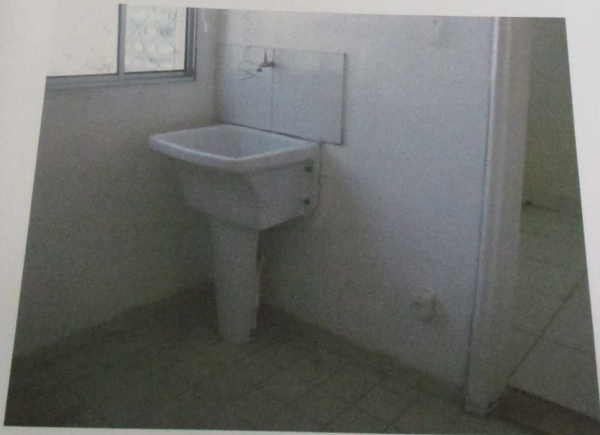
FOTO 175: Vista da área de serviço do imóvel.
