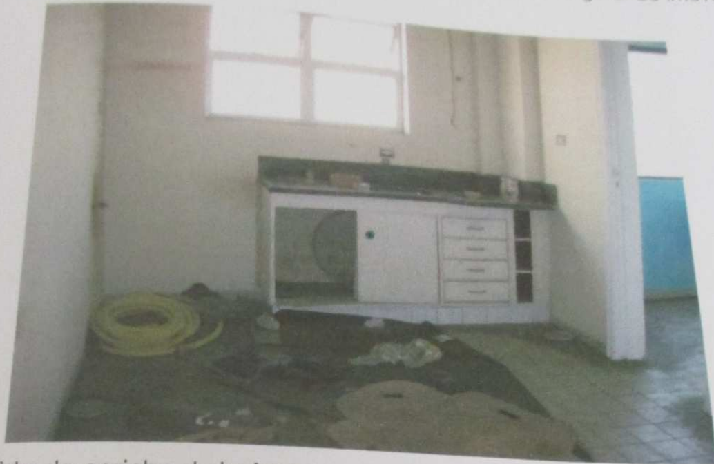
FOTO 67: Vista da cozinha do imóvel.
