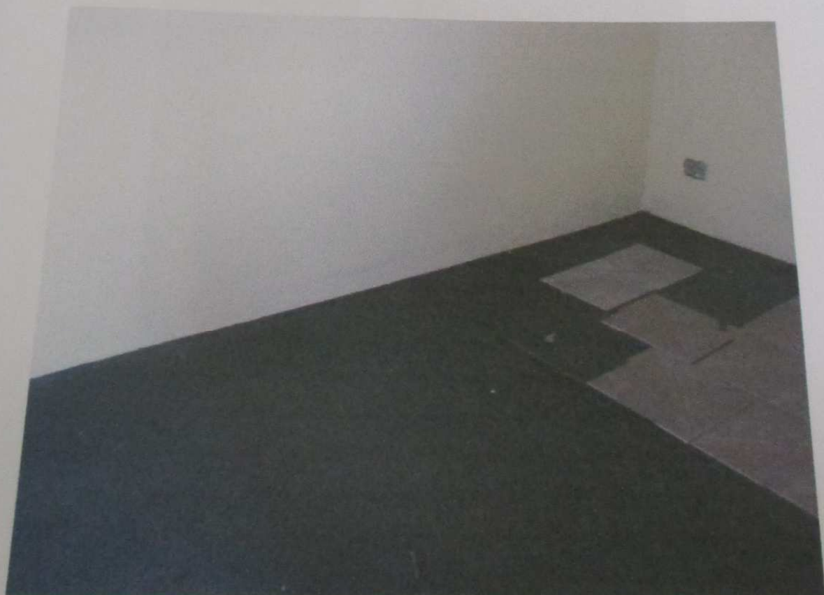
FOTO 187: Vista do dormitório do imóvel.
