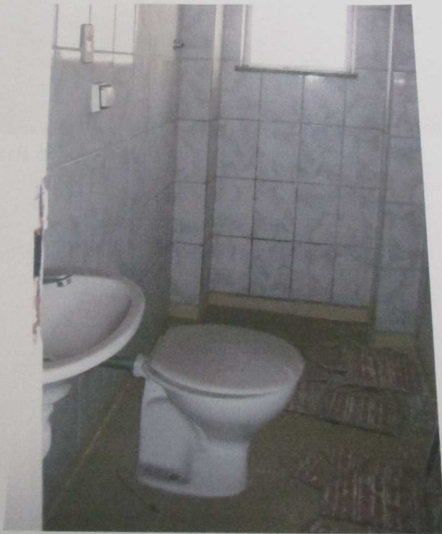
FOTO 162: Vista do banheiro do imóvel.
