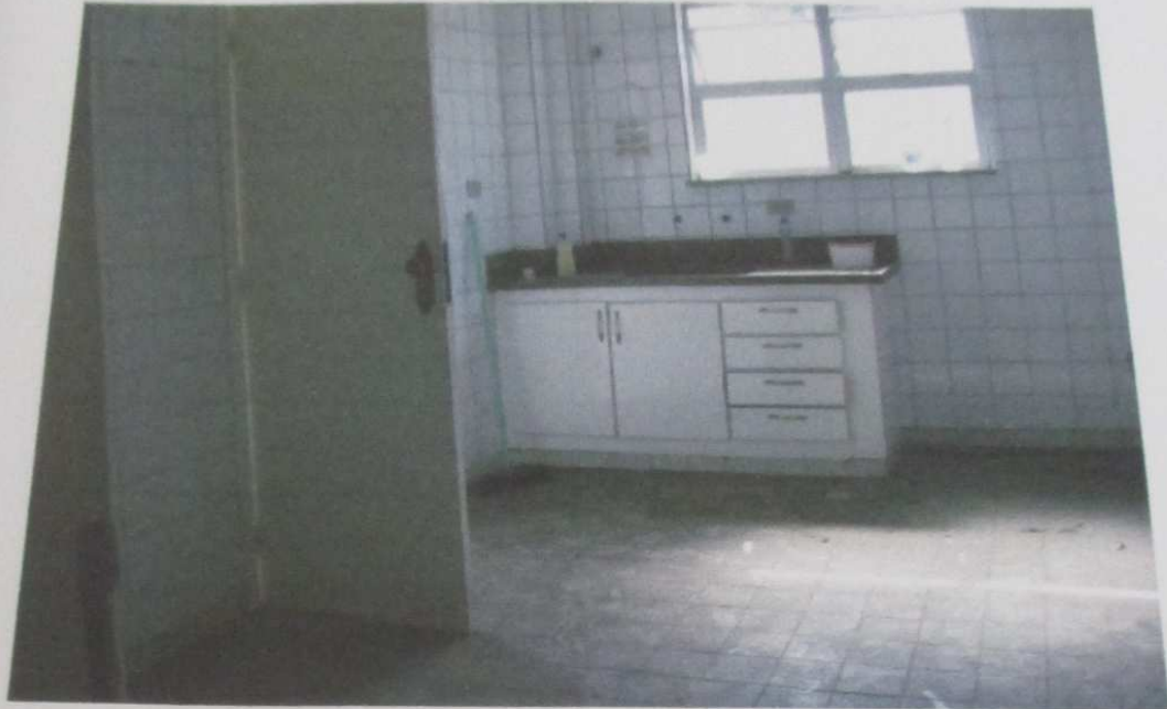
FOTO 155: Vista da cozinha do imóvel.
