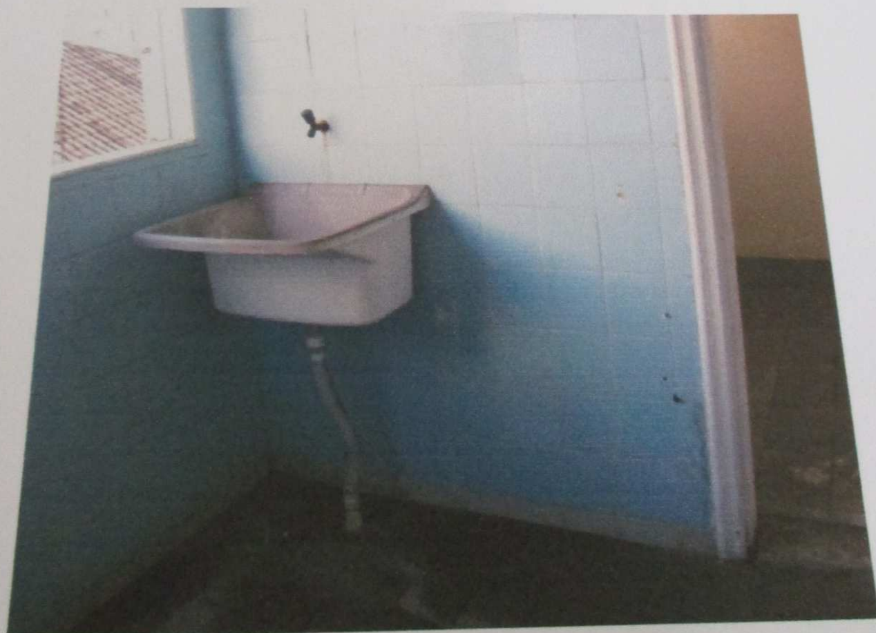
FOTO 51 : Vista da área de serviço do imóvel.
