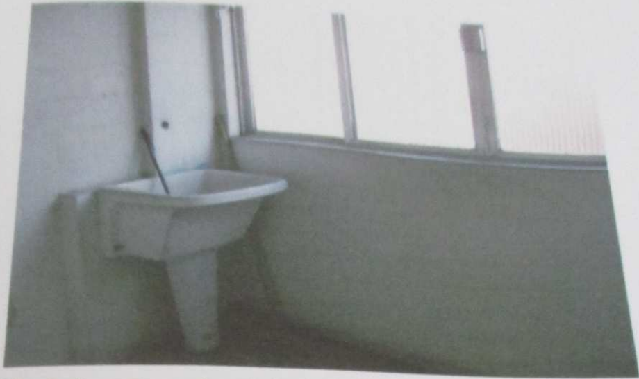
FOTO 44 : Vista da área de serviço do imóvel.
