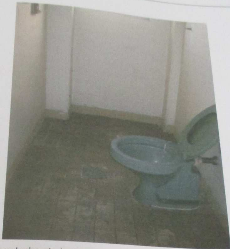
FOTO 73: Vista do banheiro do imóvel.
