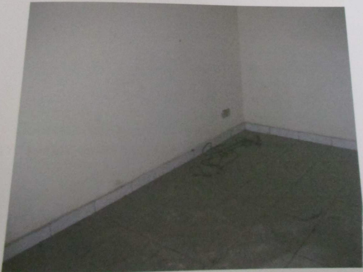
FOTO 59: Vista do dormitório do imóvel.
