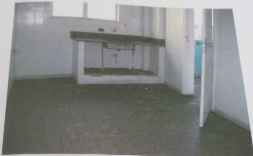
FOTO 50 : Vista da cozinha do imóvel.
