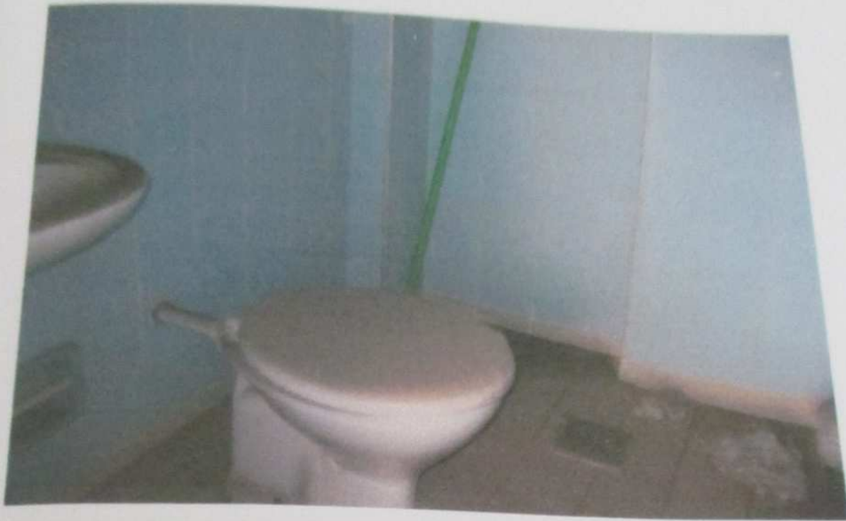
FOTO 52: Vista do banheiro do imóvel.
