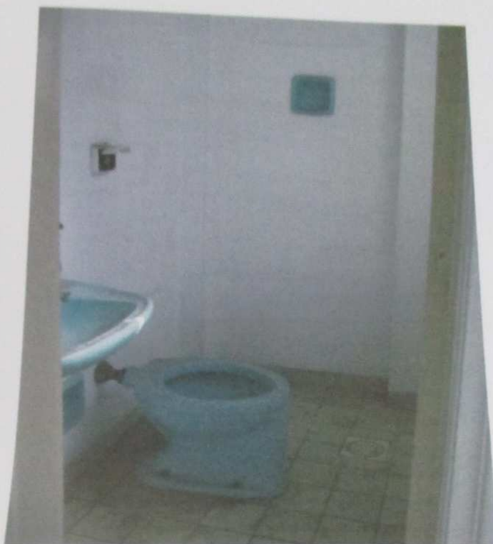
FOTO 114: Vista do banheiro do imóvel.
