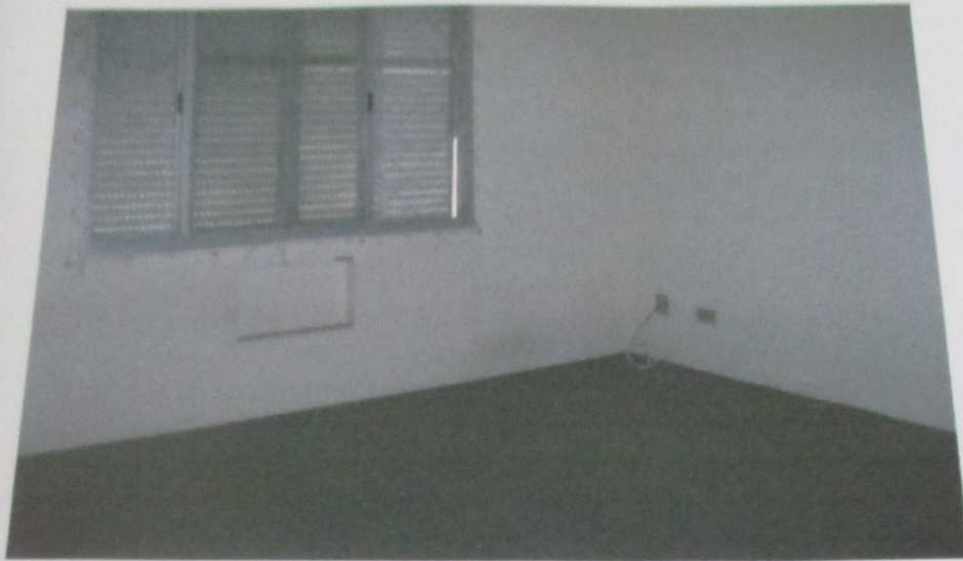
FOTO 161: Vista do dormitório do imóvel.
