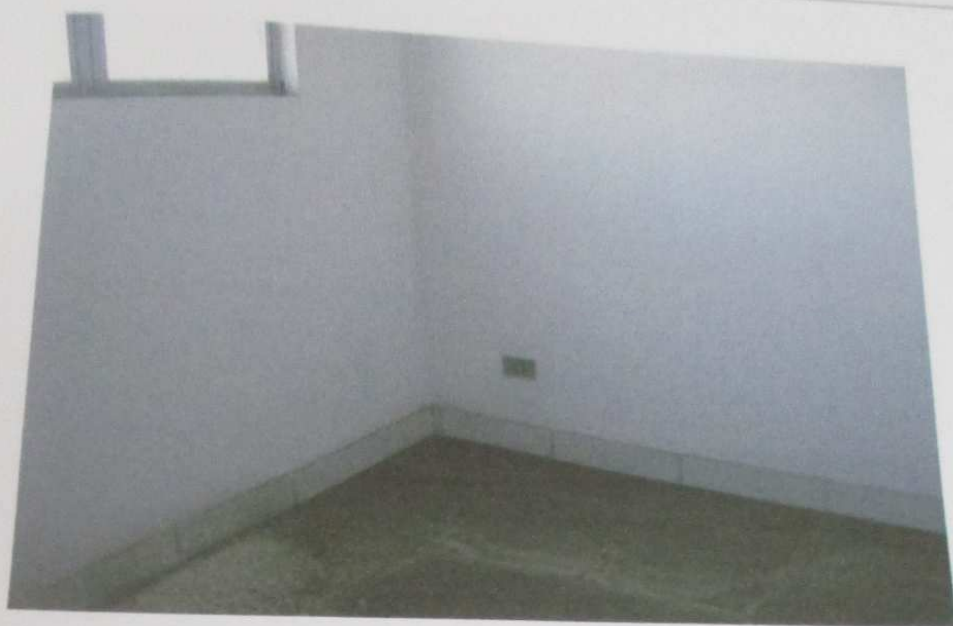
FOTO 105: Vista da sala do imóvel.
