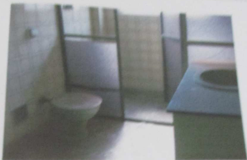
FOTO 123: Vista do banheiro do imóvel.
