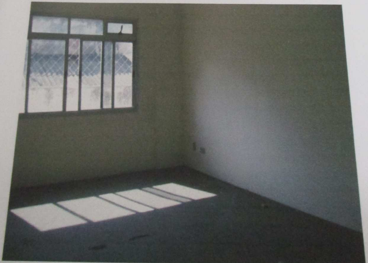
FOTO 156: Vista da sala do imóvel.
