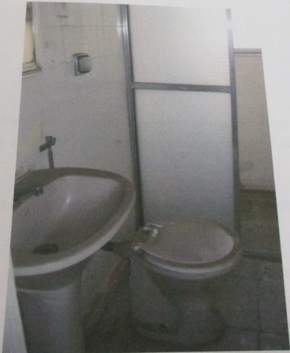
FOTO 49: Vista do banheiro do imóvel.
