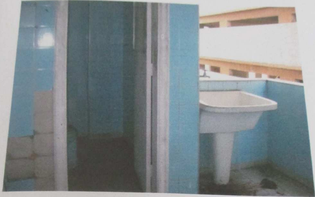
FOTO 36: Vista da área de serviço e banheiro de dependências da empregada.
