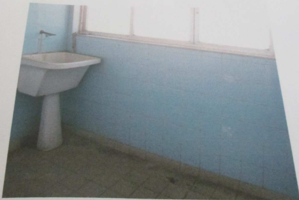
FOTO 122 : Vista da área de serviço do imóvel.
