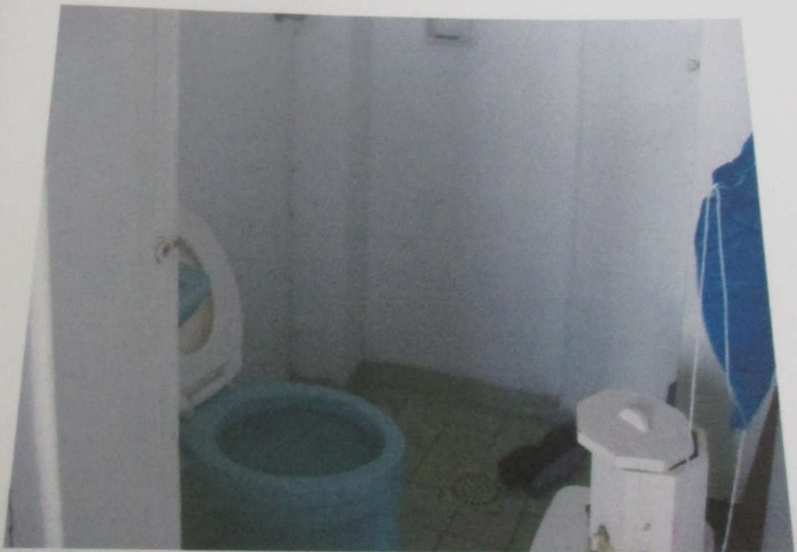
FOTO 177: Vista do banheiro do imóvel.
