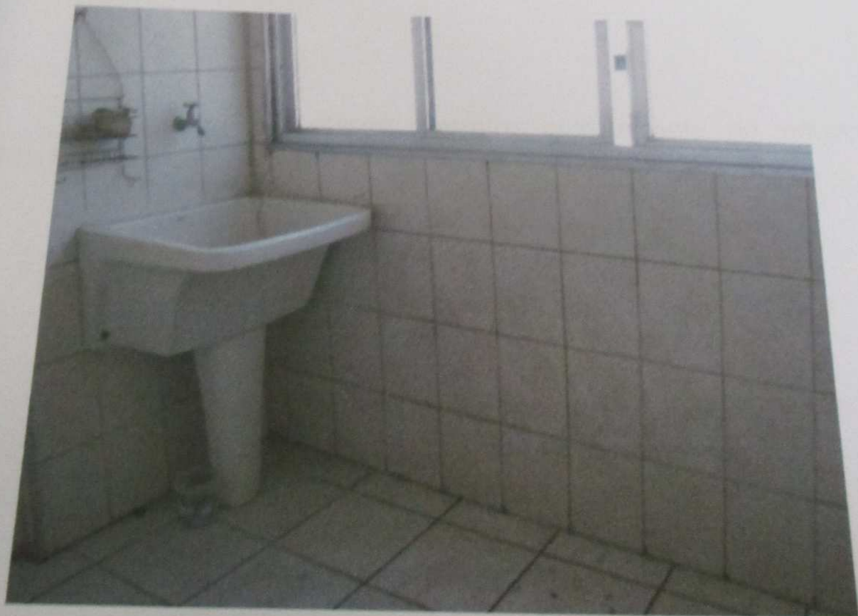
FOTO 173: Vista da área de serviço do imóvel.
