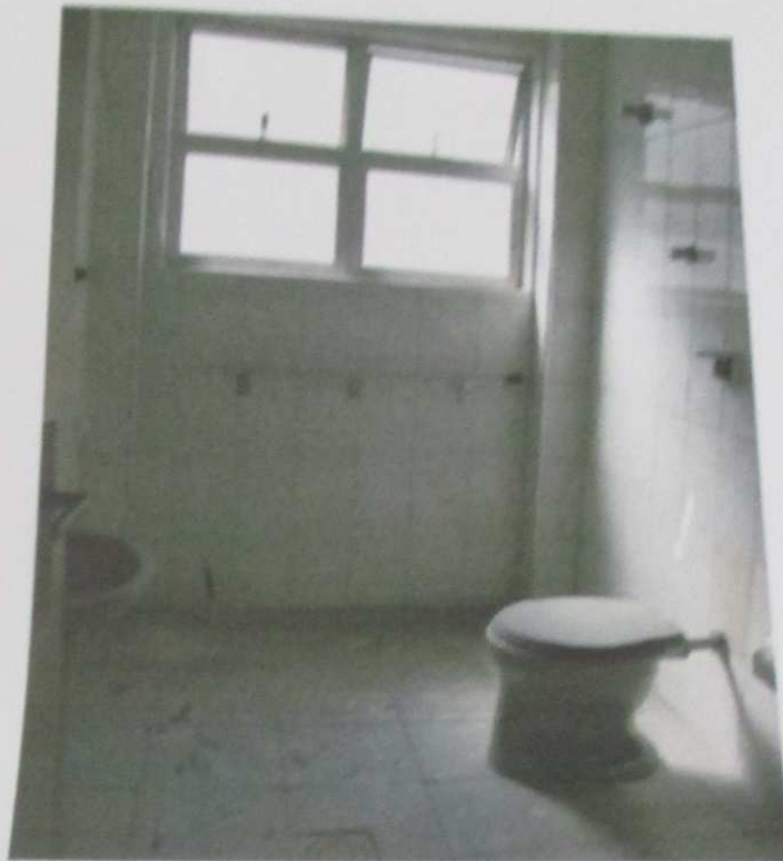
FOTO 116: Vista do banheiro do imóvel.
