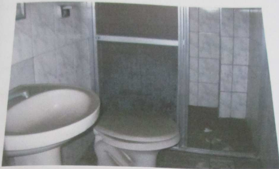
FOTO 40 : Vista do banheiro do imóvel.
