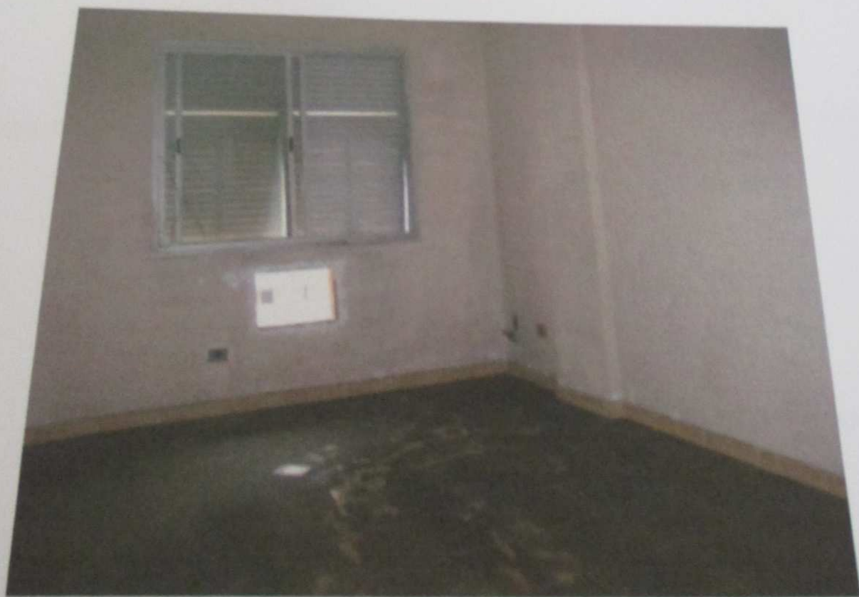
FOTO 102: Vista do dormitório do imóvel.
