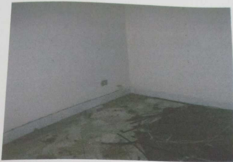
FOTO 15: Vista do dormitório do imóvel.
