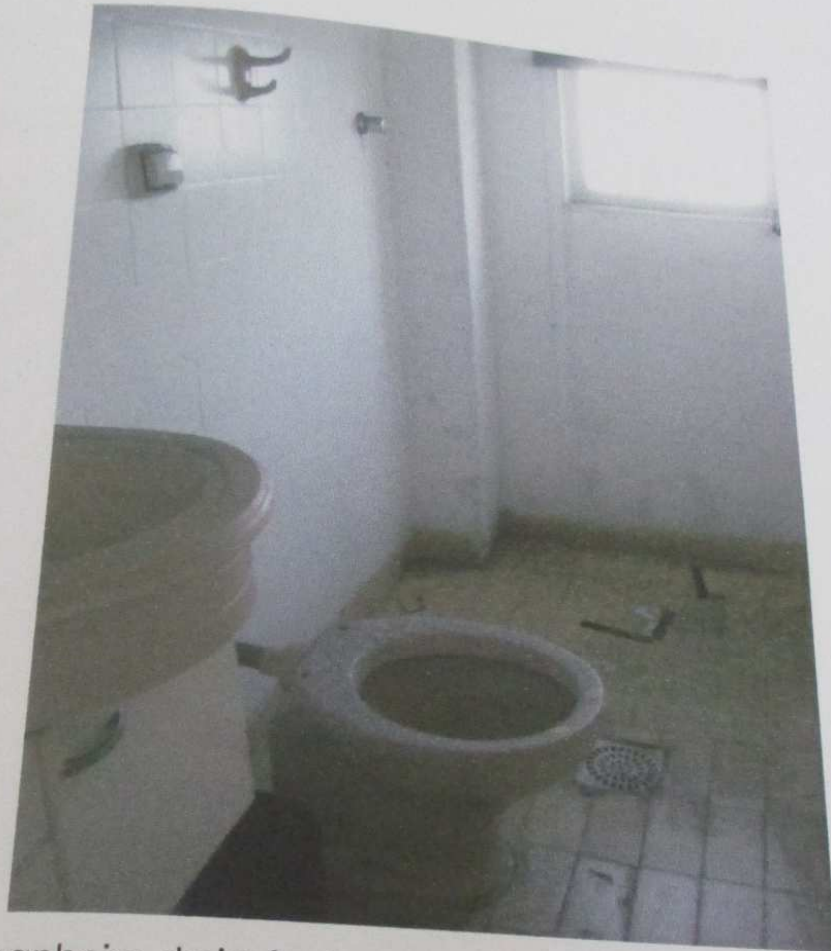
FOTO 89 : Vista do banheiro do imóvel.
