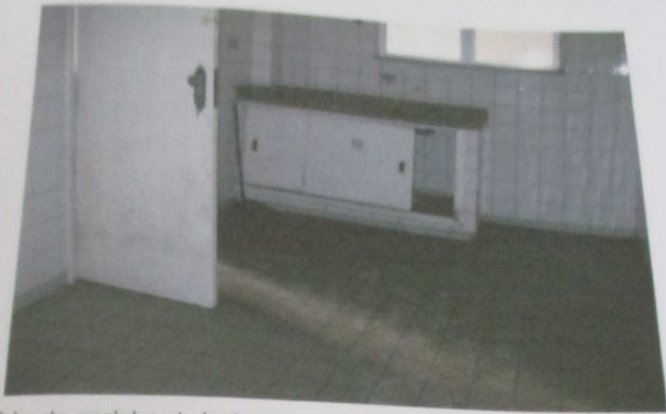
FOTO 60 : Vista da cozinha do imóvel.
