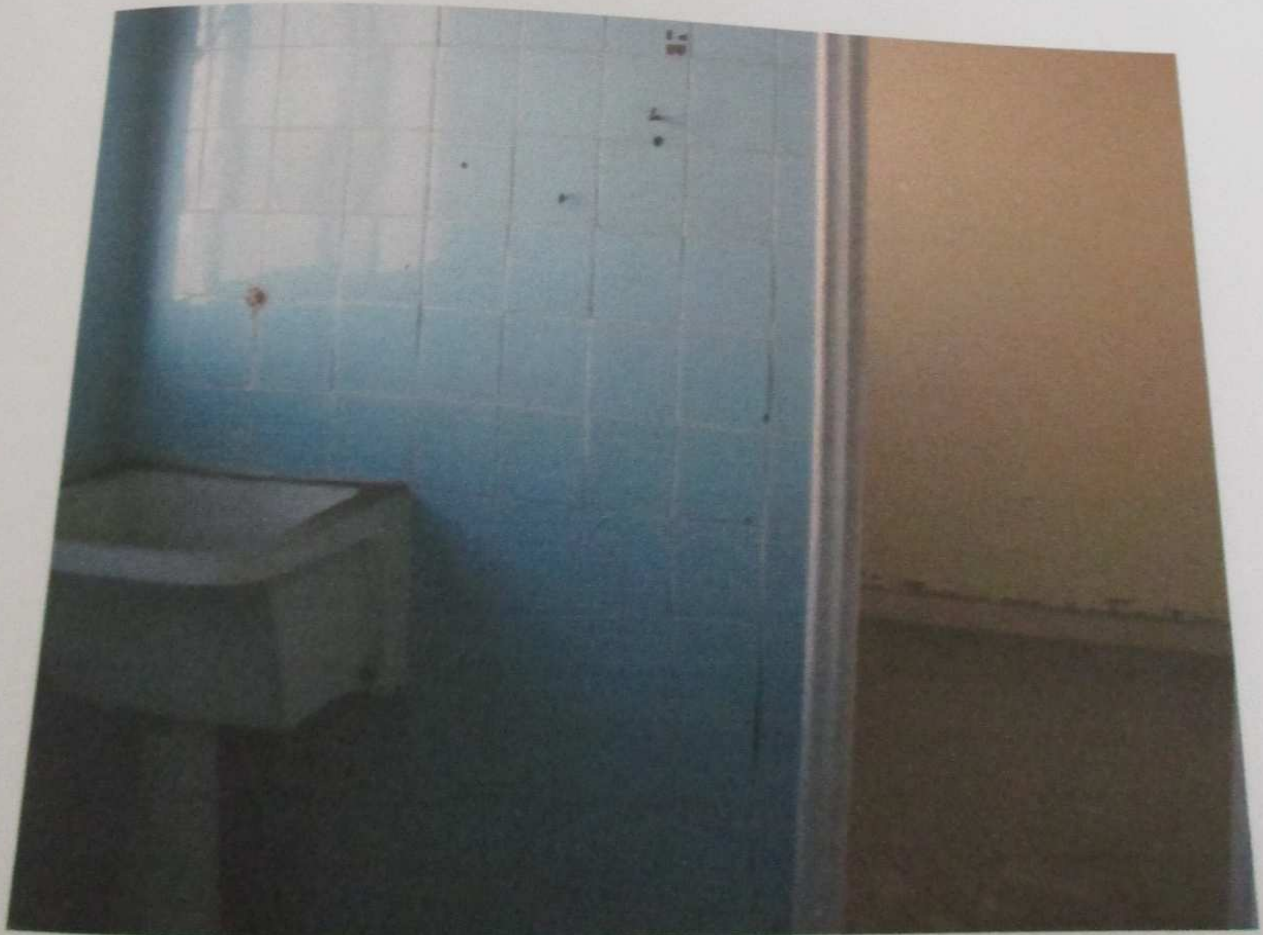
FOTO 91: Vista da área de serviço do imóvel.
