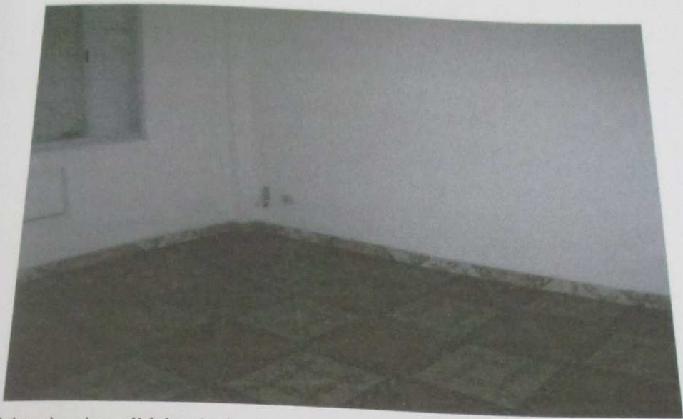
FOTO 33: Vista do dormitório do imóvel.
