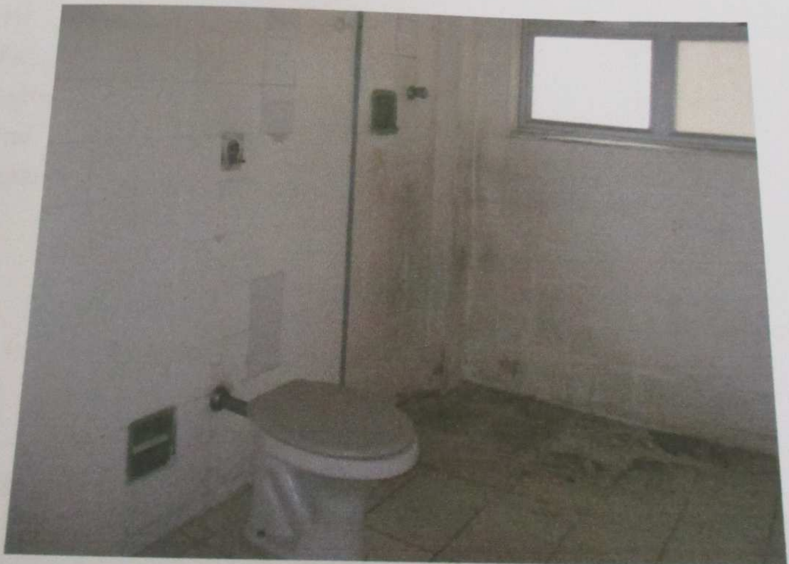
FOTO 11: Vista do banheiro do imóvel.
