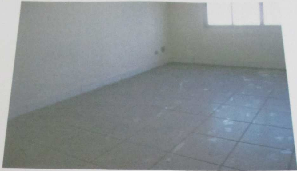
FOTO 150: Vista da sala do imóvel.
