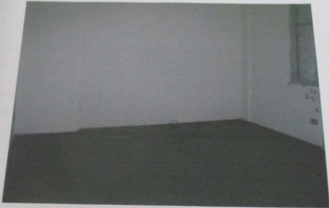
FOTO 163: Vista do dormitório do imóvel.
