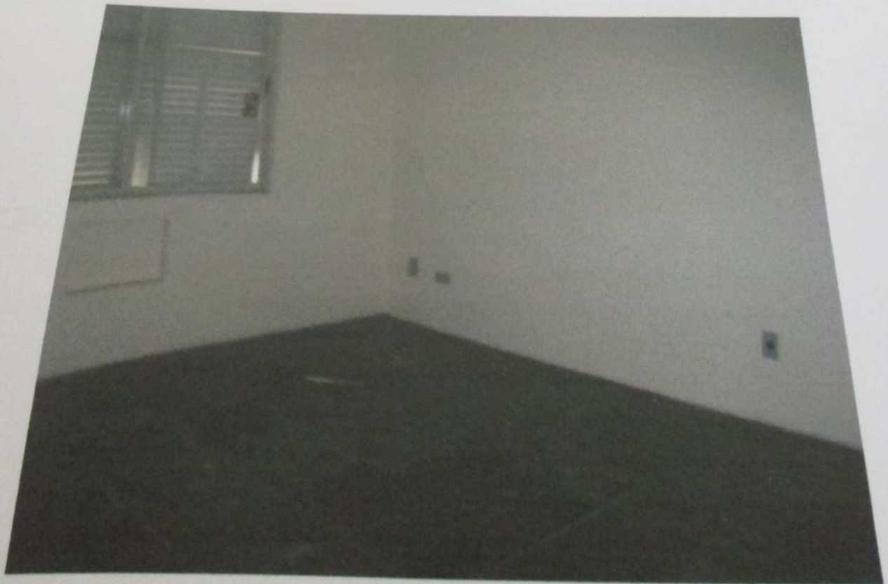
FOTO 119: Vista do dormitório do imóvel.
