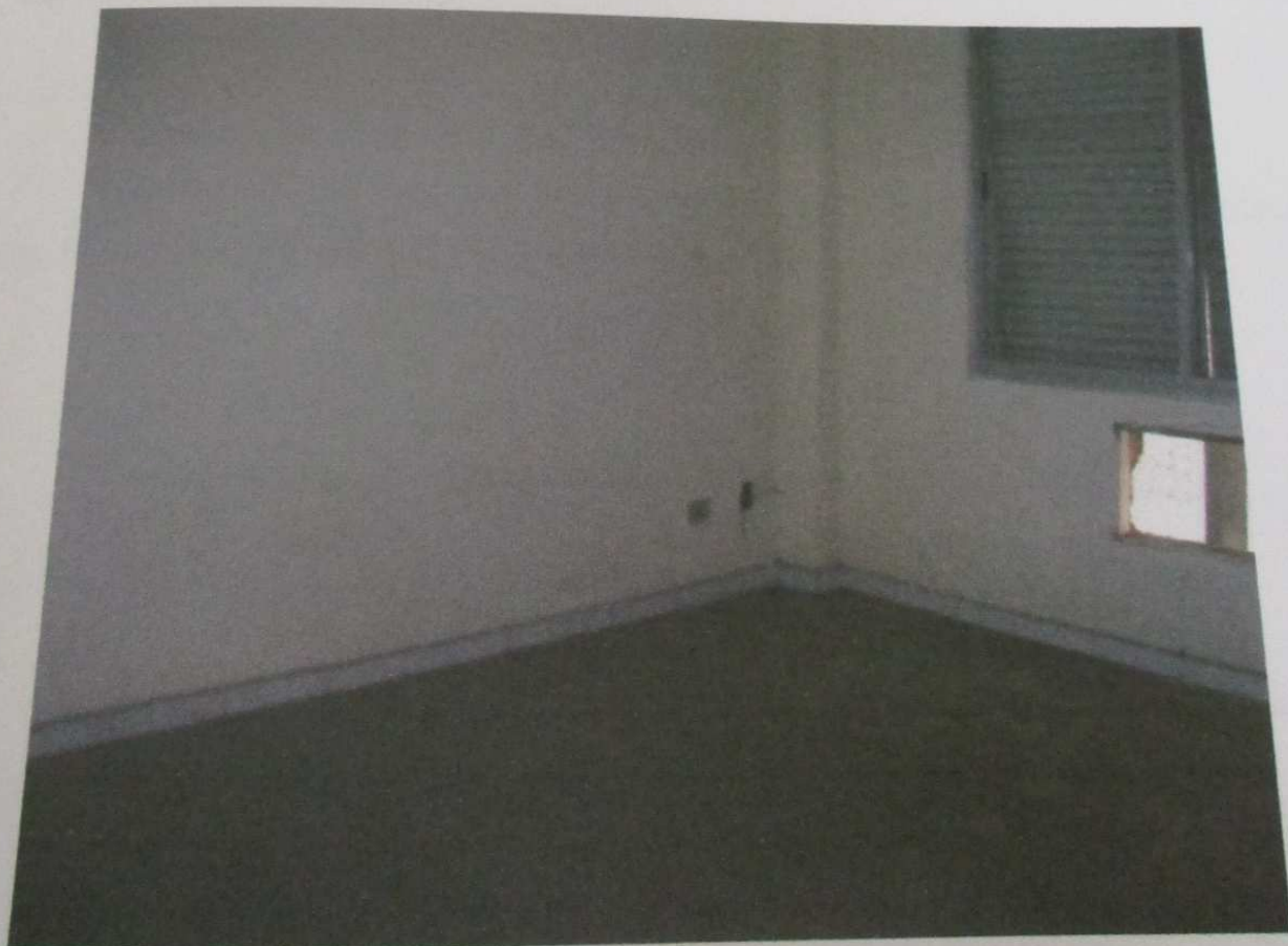
FOTO 65: Vista do dormitório do imóvel.
