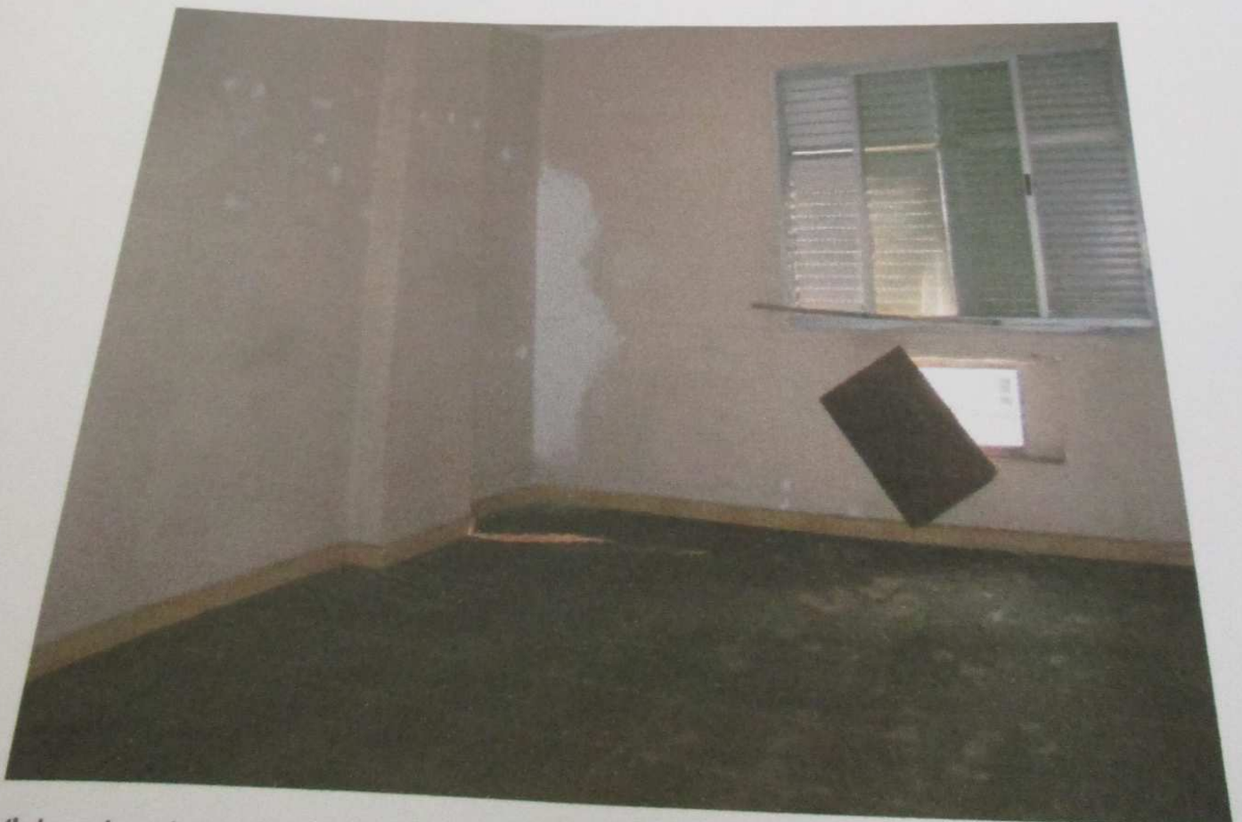
FOTO 143: Vista do dormitório do imóvel.
