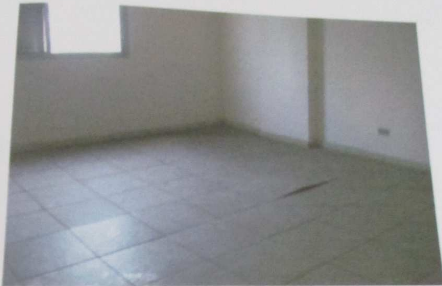
FOTO 125: Vista do dormitório do imóvel.
