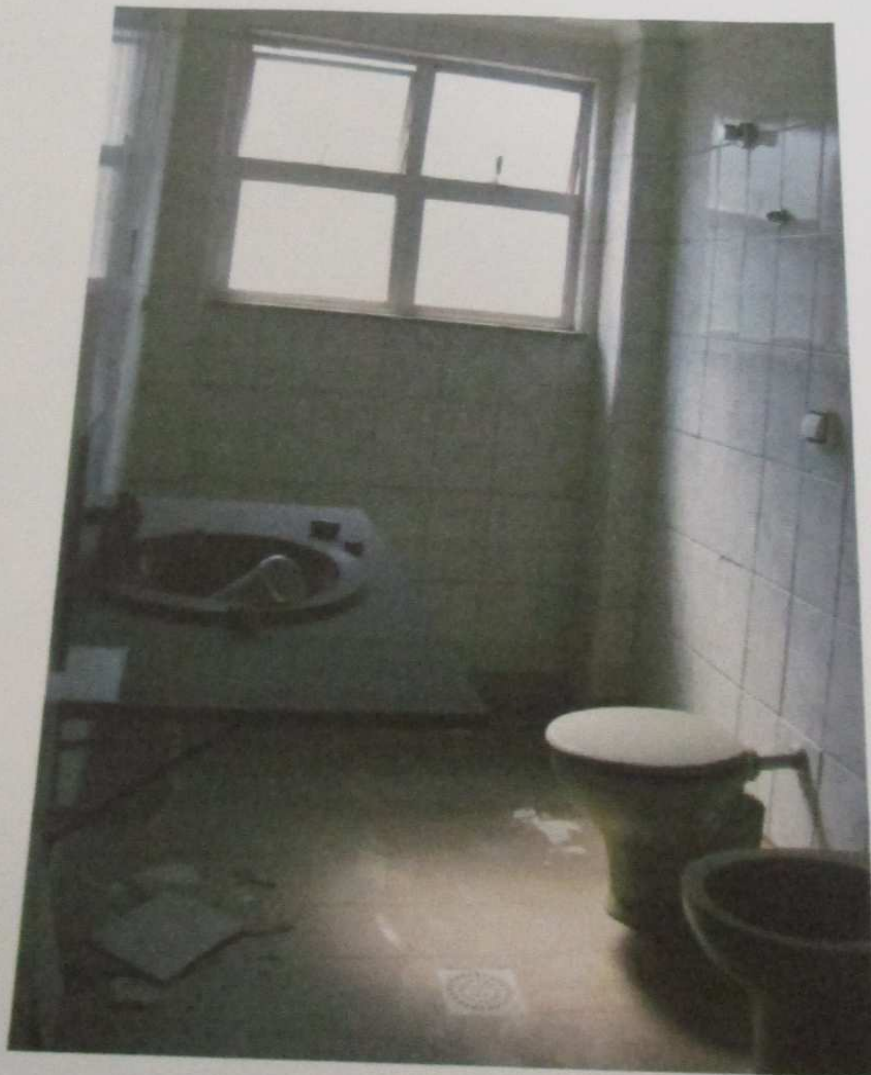
FOTO 160: Vista do banheiro do imóvel.
