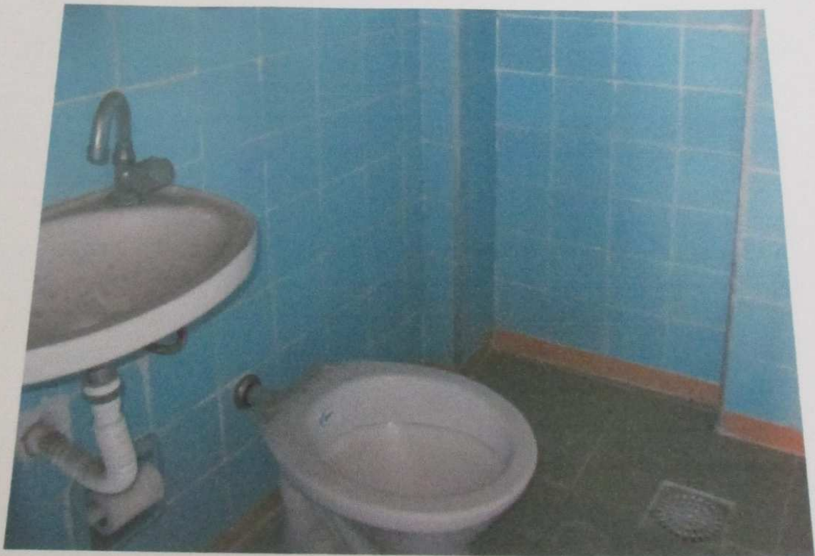
FOTO 149: Vista do banheiro do imóvel.
