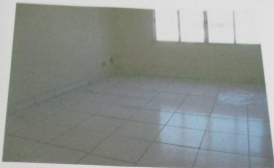
FOTO 178: Vista da sala do imóvel.
