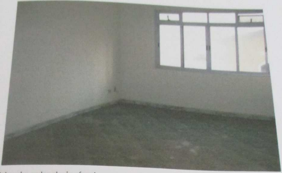
FOTO 31 : Vista da sala do imóvel.
