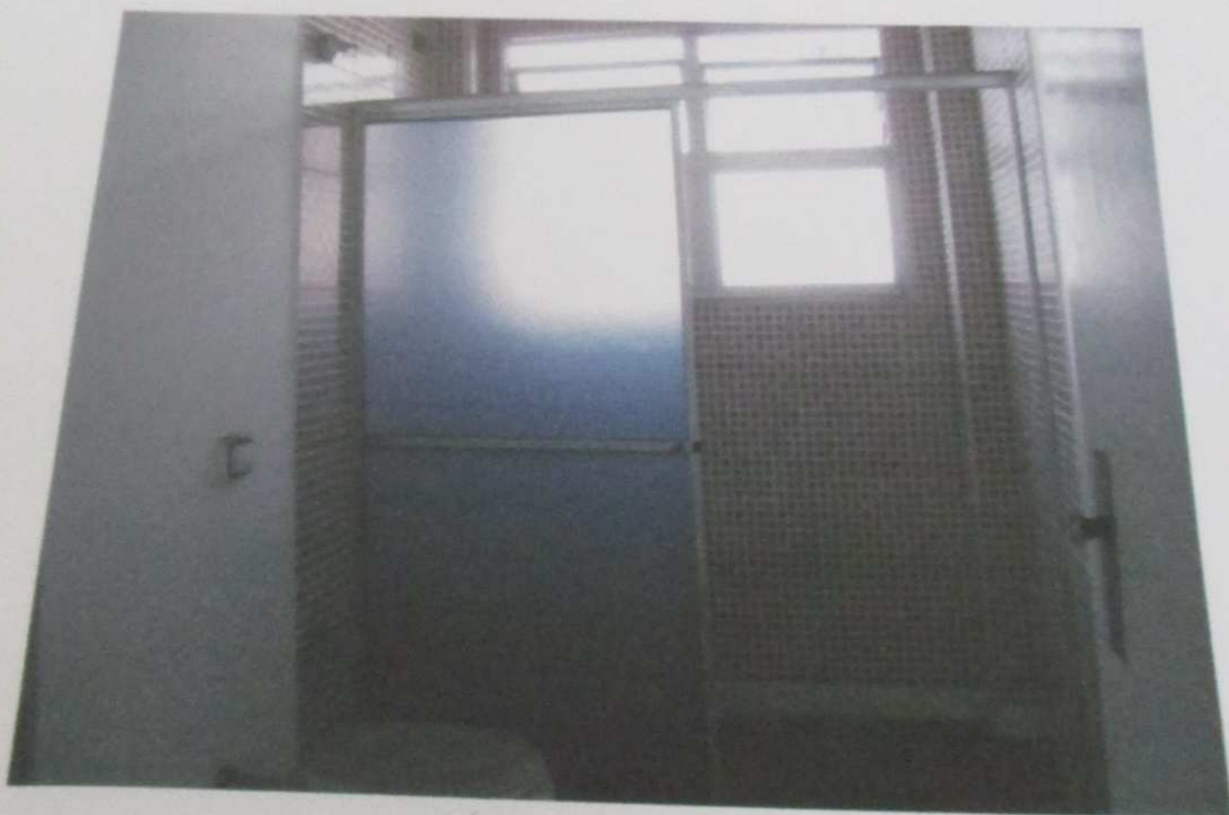
FOTO 108: Vista do banheiro do imóvel.
