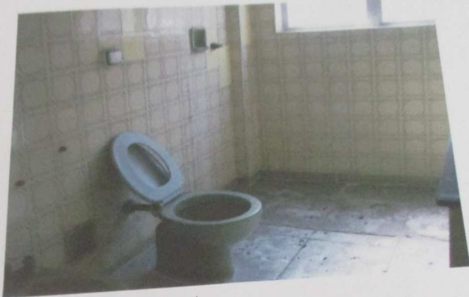
FOTO 140: Vista do banheiro do imóvel.
