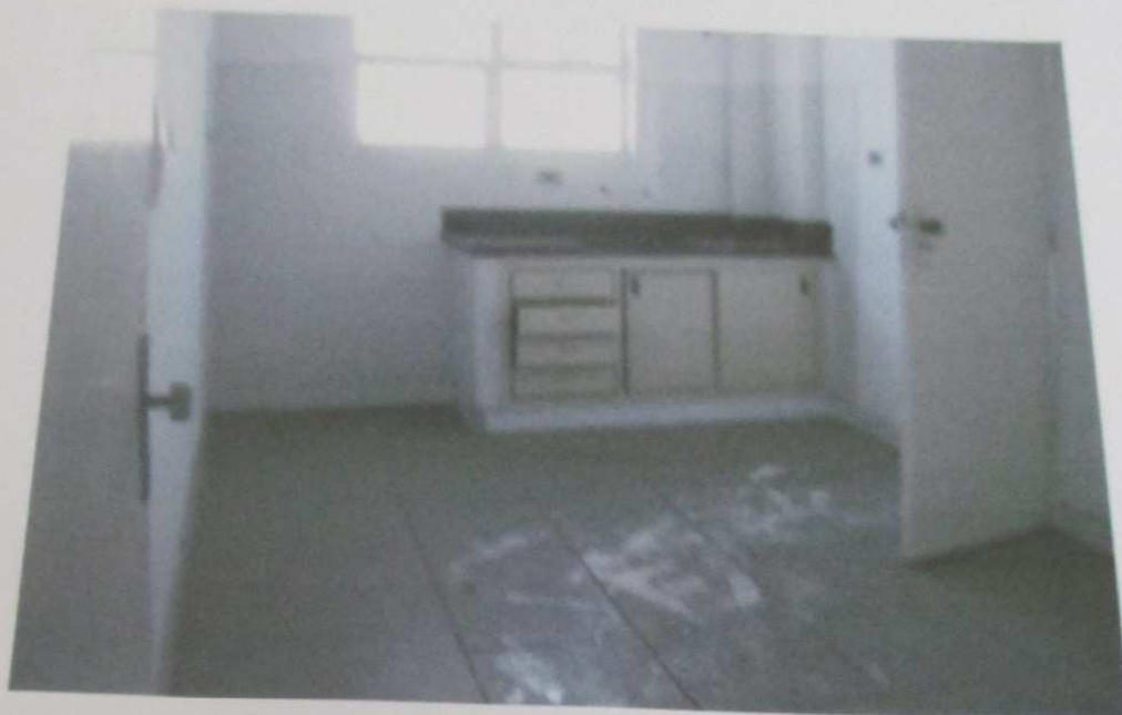
FOTO 146: Vista da cozinha do imóvel.
