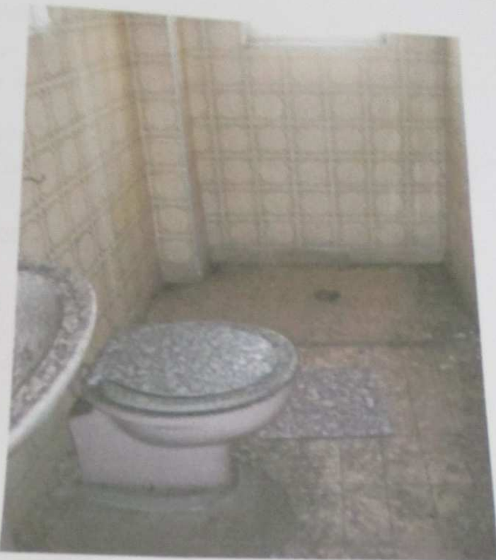
FOTO 101: Vista do banheiro do imóvel.
