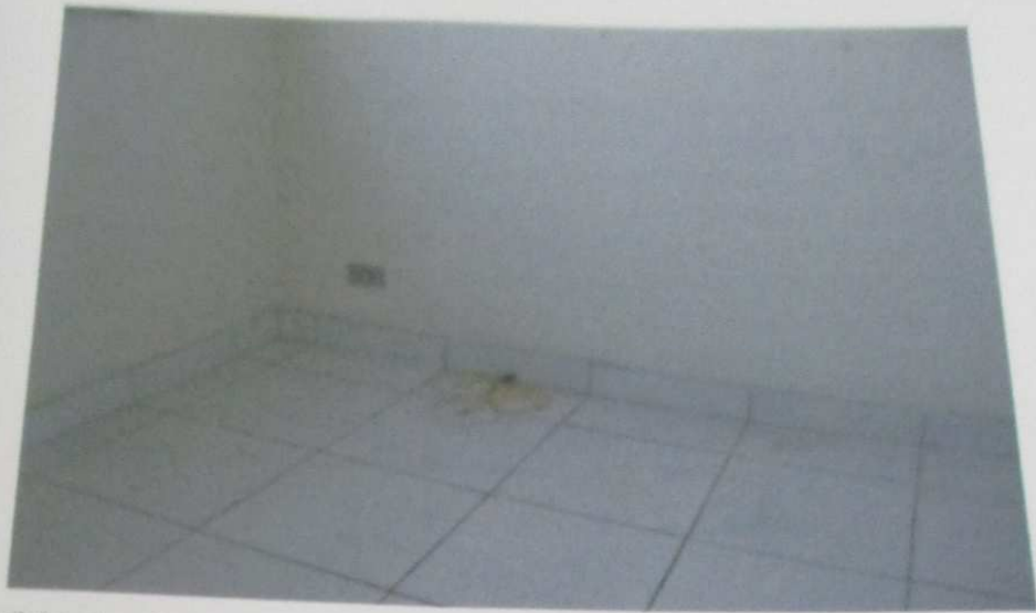
FOTO 176: Vista do dormitório do imóvel.
