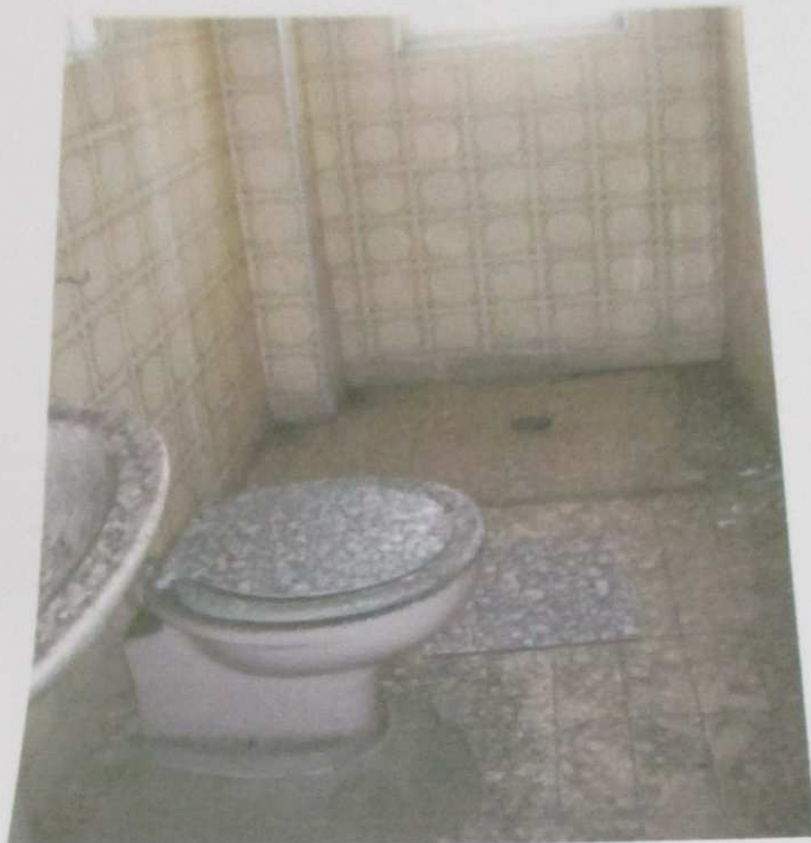
FOTO 142: Vista do banheiro do imóvel.
