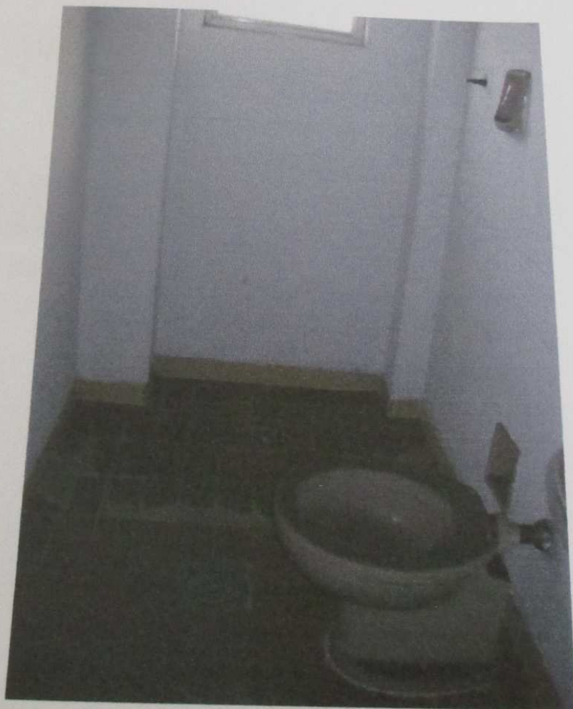
FOTO 34: Vista do banheiro do imóvel.
