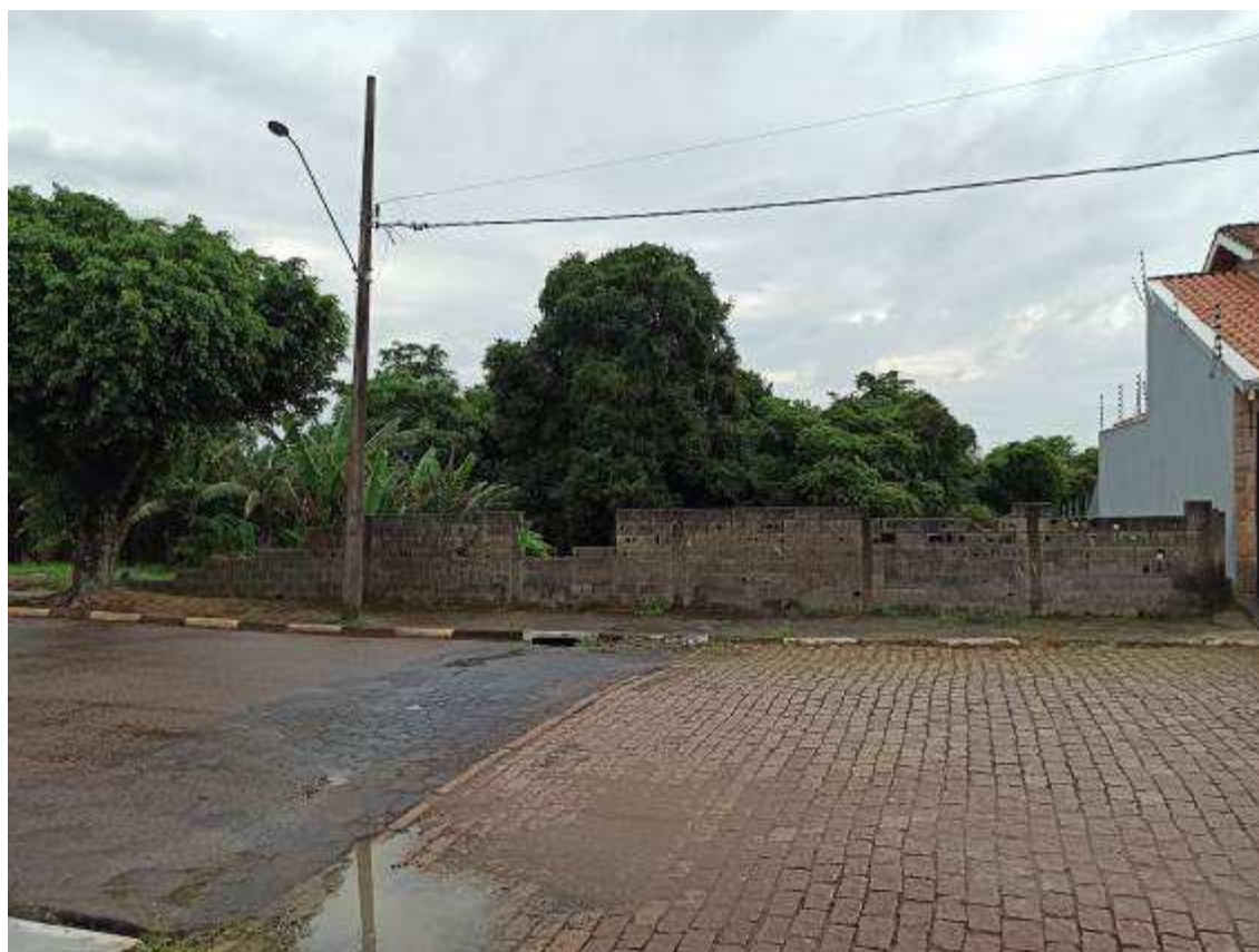
Foto 1: Frente do imóvel avaliando: no mesmo não há benfeitorias e lhe guarda um muro em ruínas.
