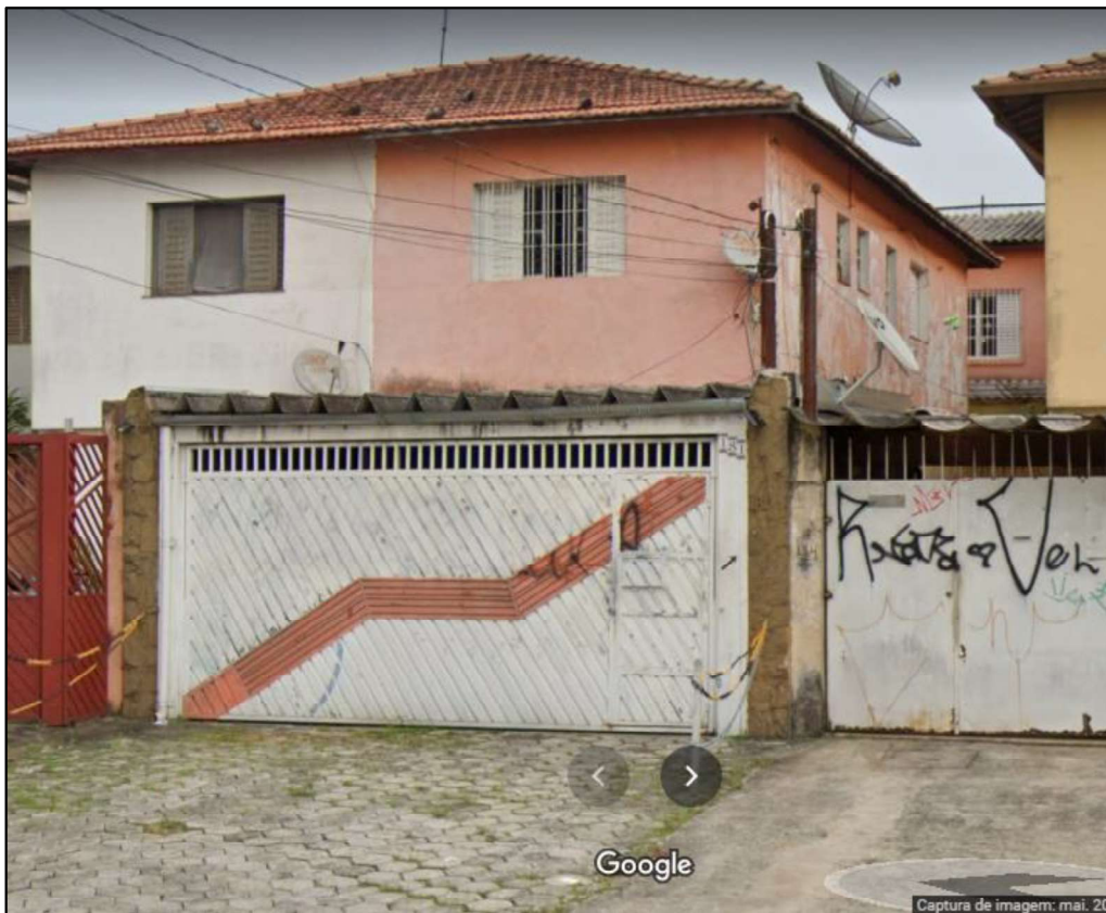
Foto 01 – Frente do imóvel
