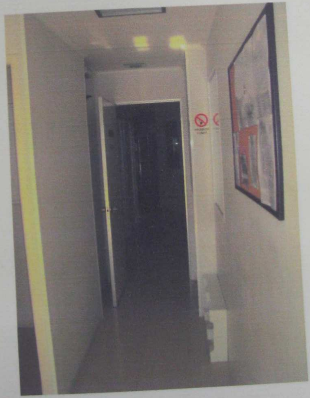
VISTA DO CORREDOR DE ACESSO AS DEPENDÊNCIAS DO IMÓVEL.
